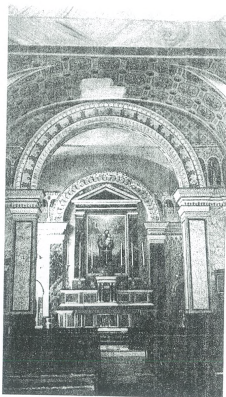
93γ. Εσωτερική άποψη του ναού. Διακρίνεται ο ελκυστήρας που συγκρατεί τους κατά μήκος τοίχους.
