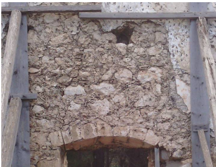
Εικ.8. Οι τοιχοποιίες είναι αργολιθοδομές με μικρούς σχετικά λίθους, πλούσιο κονίαμα στους αρμούς και βύσματα,
