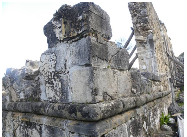
Εικ.9. ΒΔ γωνία του ναού, διακρίνονται τα ορθογωνισμένα τεμάχια λίθων που προέρχονται από αρχαιότερες κατασκευές.
