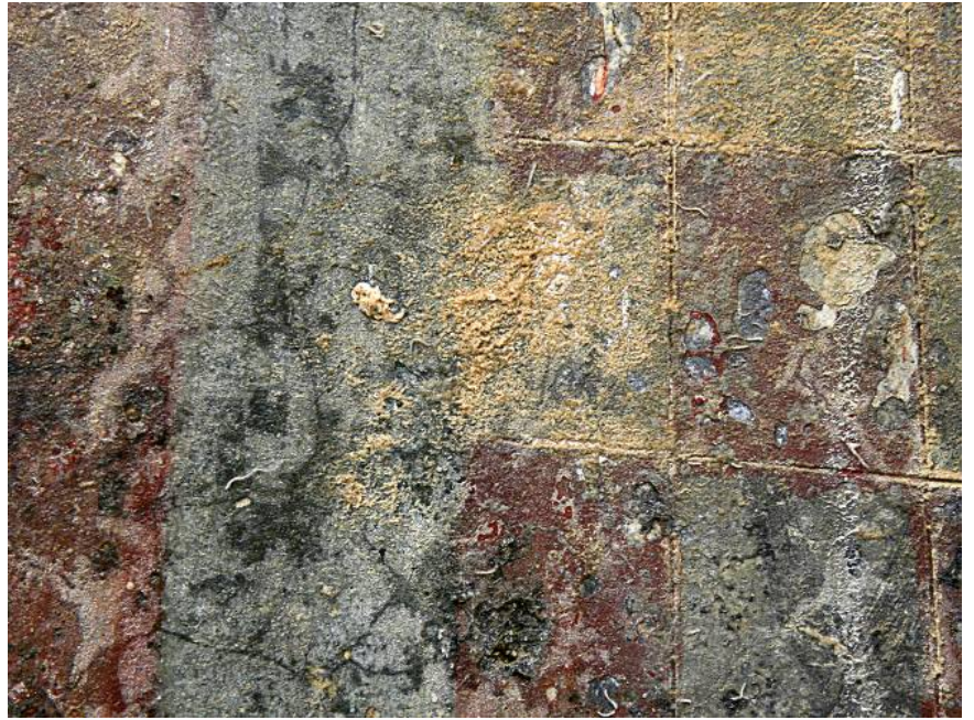
Εικ.35. Σχηματισμός κρούστας αλάτων στην επιφάνεια των τοιχογραφιών
