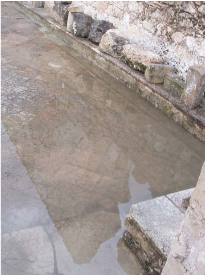
Εικ.40. Οι κεραμικές πλάκες του δαπέδου στο καθολικό είναι κατακερματισμένες σε ποσοστό 50% του συνόλου
