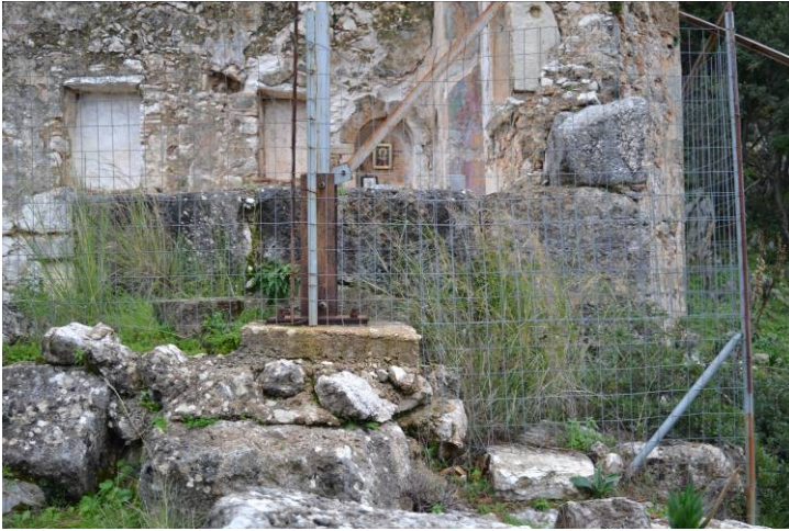
Εικ.20. Λεπτομέρεια του νότιου τοίχου με τους μορφοποιημένους ασβεστόλιθους στη ΒΑ γωνία και τη βάση του
