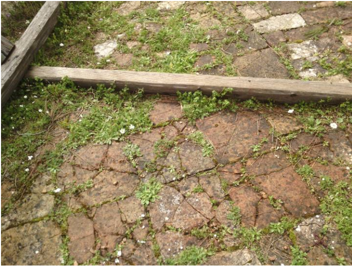
Εικ.40. Οι κεραμικές πλάκες του δαπέδου στο καθολικό είναι κατακερματισμένες σε ποσοστό 50% του συνόλου
