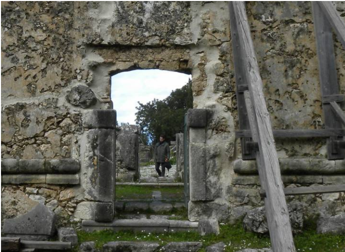
Εικ. 12. Από διαμορφωμένους ασβεστολιθικούς ογκόλιθους των αρχαίων καταλοίπων είναι διαμορφωμένα τα πλαίσια των ανοιγμάτων.
