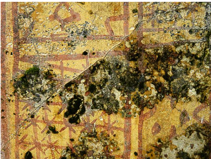
Εικ.38,39. Ανάπτυξη μικροοργανισμών στις οπές των τοιχογραφημένων επιχρισμάτων και των νεώτερων σφραγίσεων.
