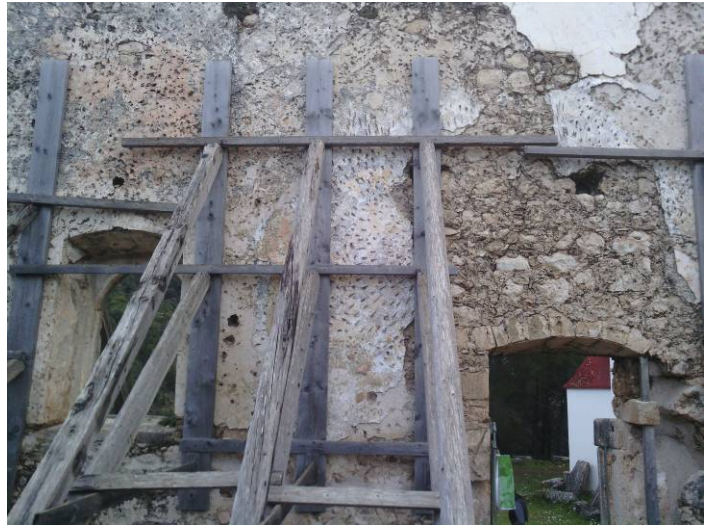
Εικ. 11. Με ψαμμίτη είναι διαμορφωμένοι οι θολίτες των ανοιγμάτων.
