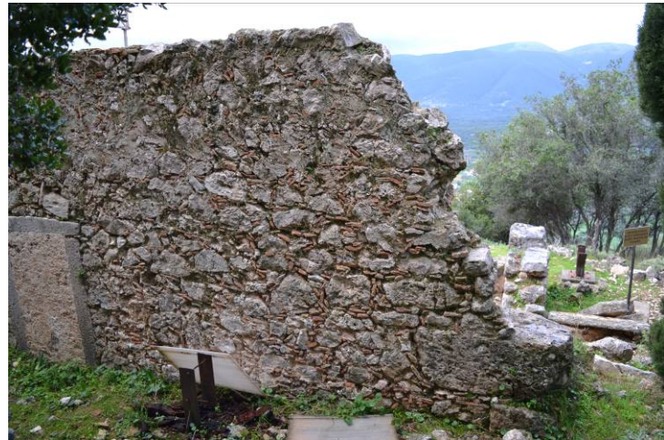
Εικ.19. Λεπτομέρεια του βόρειου τοίχου από δυτικά όπου διακρίνεται η ποιότητα της τοιχοποιίας με τα κεραμικά βύσματα.
