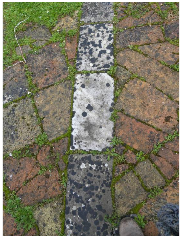
Εικ.33. Ανάπτυξη ποώδους βλάστησης στους αρμούς του δαπέδου και εποίκιση μικροοργανισμών στις επιφάνειες .
