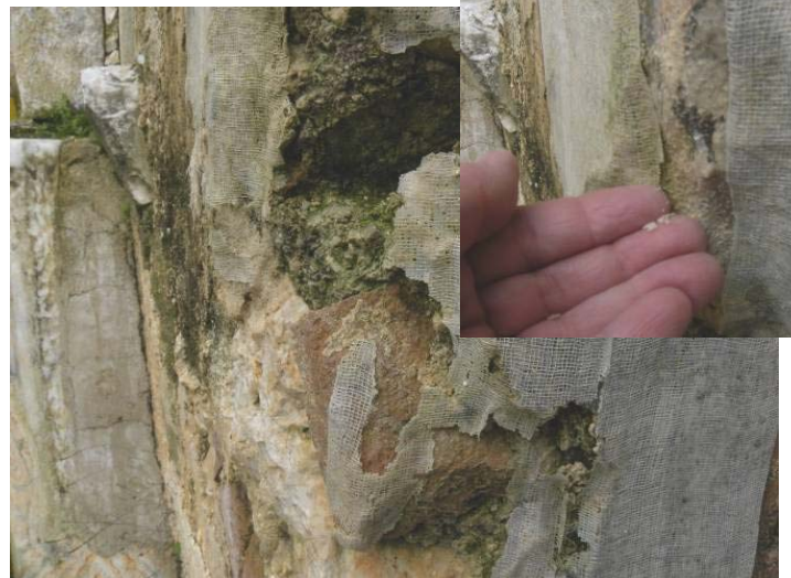
Εικ.37,37α. Γήρανση των υλικών στερέωσης
