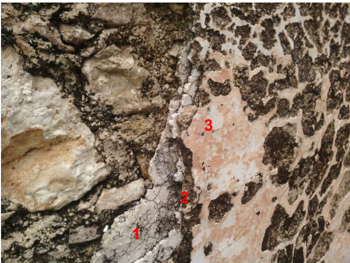
Εικ. 14. Λεπτομέρεια από τον βόρειο τοίχο στο εσωτερικό του ναού, όπου διακρίνονται οι τρεις στρώσεις επιχρίσματος και επιφανειακά η ροδόχρους βαφή.
