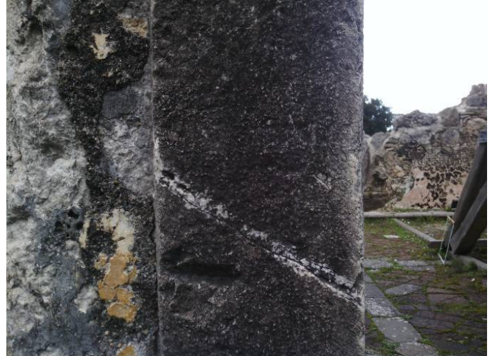
Εικ.31. Θραύση μονολιθικών αρχιτεκτονικών μελών
