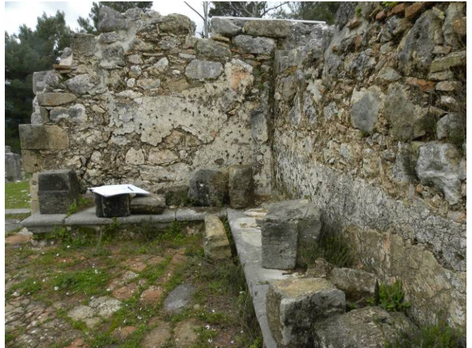
Εικ. 13. Περιμετρικά κατά μήκος τόσο του ανατολικού όσο και των μακριών τοίχων σχηματίζεται χαμηλός αναβαθμός για την τοποθέτηση των στασιδίων.
