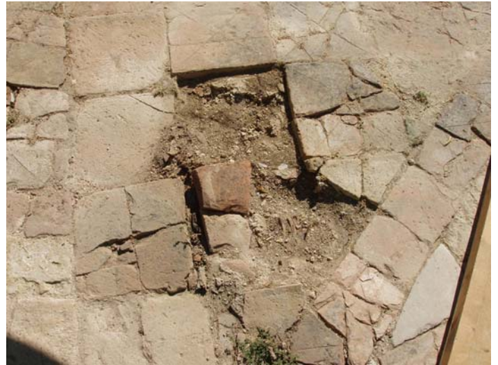
Εικ.41. Διατάραξη των πλακών του δαπέδου μετά την αφαίρεση ξυλώδους φυτού.
