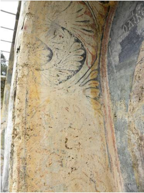
Εικ.34. Απόπλυση του γραπτού διακόσμου και απώλεια της λαμπρότητας των βαφών του διακόσμου.
