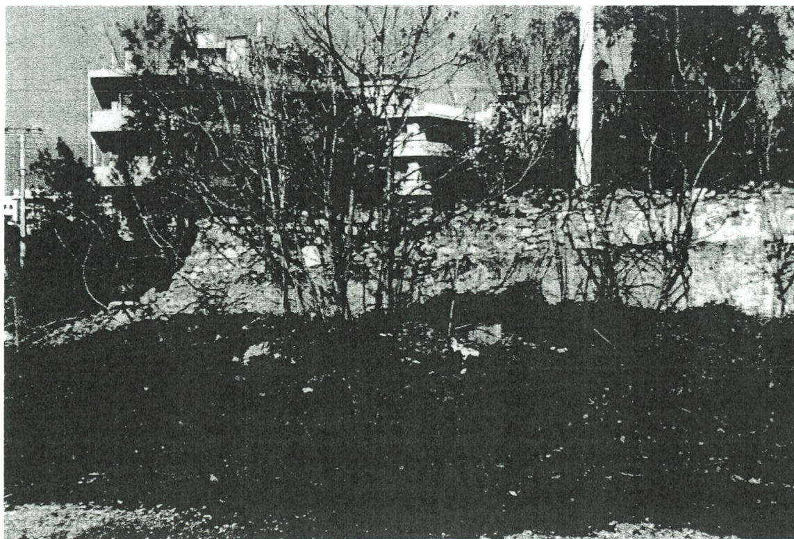
Φωτ.4. Διακρίνεται τμήμα του μανδροτοίχου. Τα κελλιά 'έχουν ήδη καταστραφεί.
