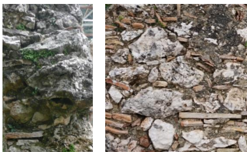
Εικ. 2.8,9 : Τοιχοποιία Παρεκκλησίου Αγίου Νικολάου, δόμηση κατά το πάχος και κατά την όψη
