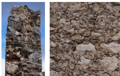
Εικ. 2.6,7 : Τοιχοποιία Καθολικού, δόμηση κατά το πάχος και κατά την όψη
