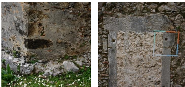
Εικ. 2.12,13 : Τοιχοποιία Παρεκκλησίου Αγίου Νικολάου, λεπτομέρειες διαμόρφωσης γωνιών και θυρωμάτων
