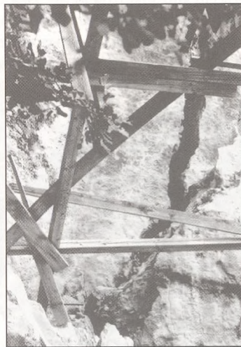
Η ξύλινη σκαλωσιά και τα συρμάτινα πλαίσια είναι ανεπαρκή για τις καταπτώσεις βράχων
