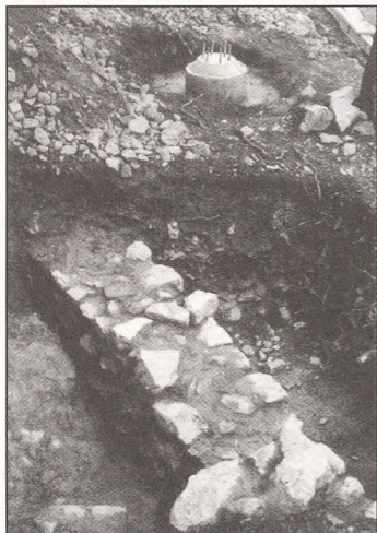
Τοποθέτηση τσιμεντών και βάσεων για τα κάγκελα πάνω σε αρχαιολογικά ευρήματα
