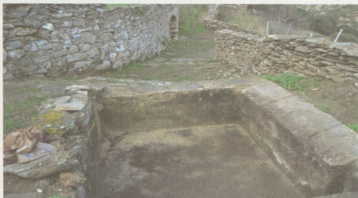
Η δεξαμενή πλύσης ρούχων στις Μηλιές. Στο βάθος η δεύτερη πηγή (φωτό: Γ. Αντωνίου).
