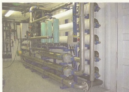
ΦΩΤΟ 1, 2: Μονάδες Αντίστροφης Όσμωσης που αποδεικνύουν τη συμπαγή κατασκευή τους και τη δυνατότητα εγκατάστασής τους σε κιβώτια μεταφοράς (container).
