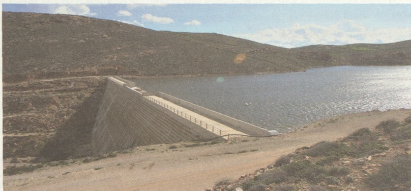
Φράγμα Άνω Μεράς, Μύκονος.
