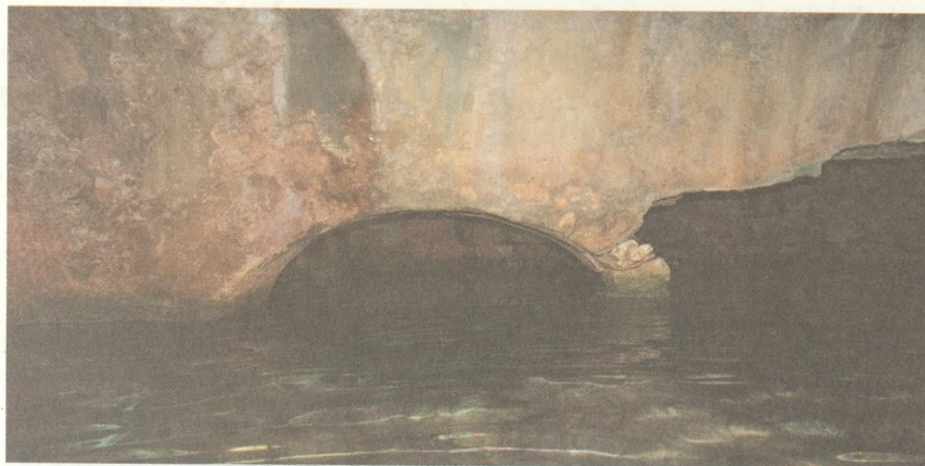
Δίκωρη δεξαμενή στο νησάκι του Αγίου Γεωργίου (φωτό: Γ. Ν. Καραβέλατζης).
