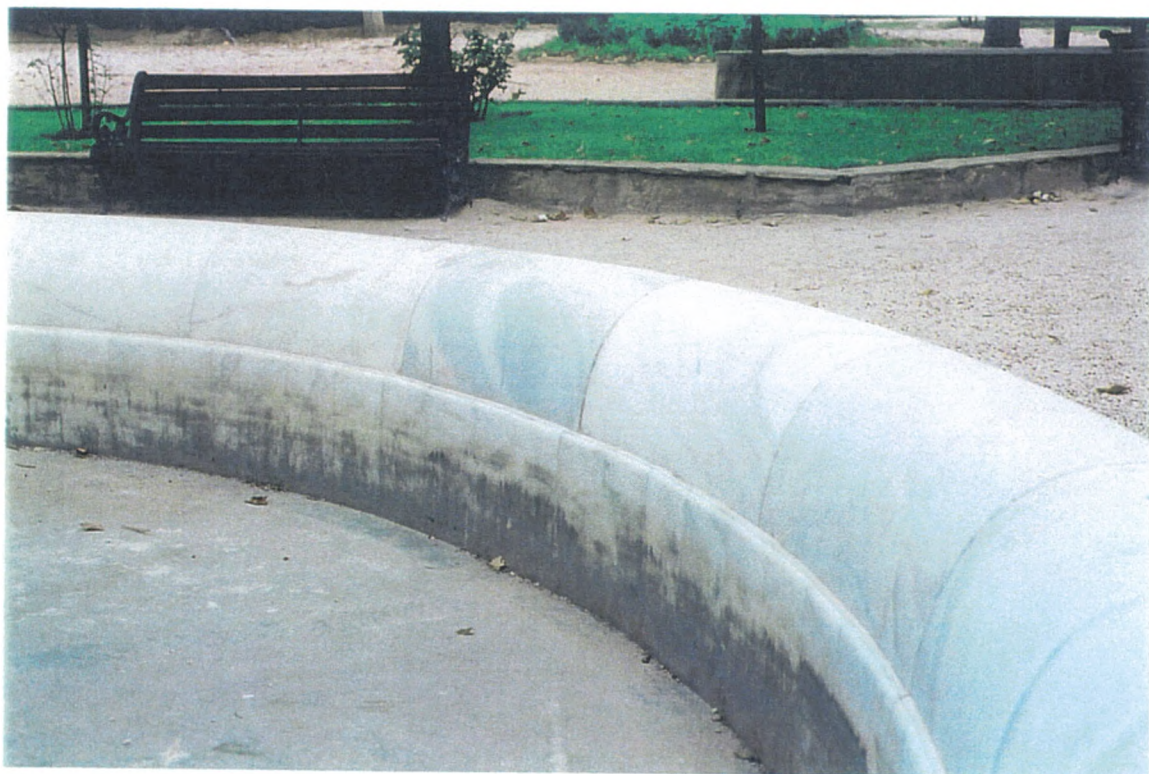
Λεπτομέρεια του τοιχώματος της λίμνης
