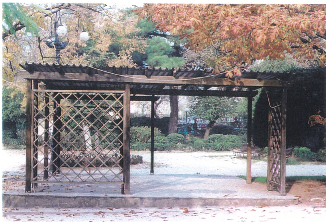
Ένα στέγαστρο με επικάλυψη λαμαρίνα
