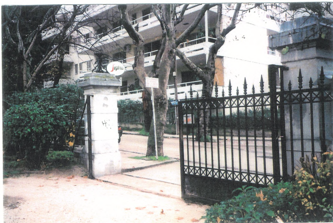
Πλάγια θύρα επί της Ηρώδου του Αττικού. Νεώτερη ανακατασκευή του παλιού θυρώματος σε σύγχρονη «νεοκλασική» μορφολογία, συρόμενη και με μεγαλύτερο άνοιγμα για την είσοδο οχημάτων, και φωτεινή διαφήμιση του αναψυκτηρίου επί του ενός πεσσού στον οποίο διασώζεται η χυτοσιδηρά βάση του φανοστάτη
