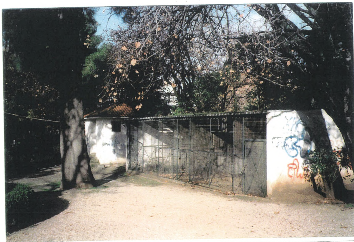
Οικίσκος των WC και το κοτέτσι. Σε πολλά άλση των ευρωπαϊκών πόλεων υπάρχουν και WC και κλουβιά για πουλιά ή μικρά ζώα, τα οποία όμως είναι περίτεχνες σιδηροκατασκευές σε νεοκλασικό ρυθμό ή σε art nouveau ανάλογα με την εποχή που κατασκευάστηκαν, και έχουν μείνει στην ιστορία της τέχνης και της αρχιτεκτονικής, όπως της Βιέννης, του Λονδίνου, των Παρισίων. Ακόμη και στην Αθήνα, στον Εθνικό Κήπο έχουμε τέτοια αξιόλογα δείγματα. Στην νεοκλασική (όσο απέμεινε) Κηφισιά όμως, προτιμήθηκε το «kotetsi styl».
