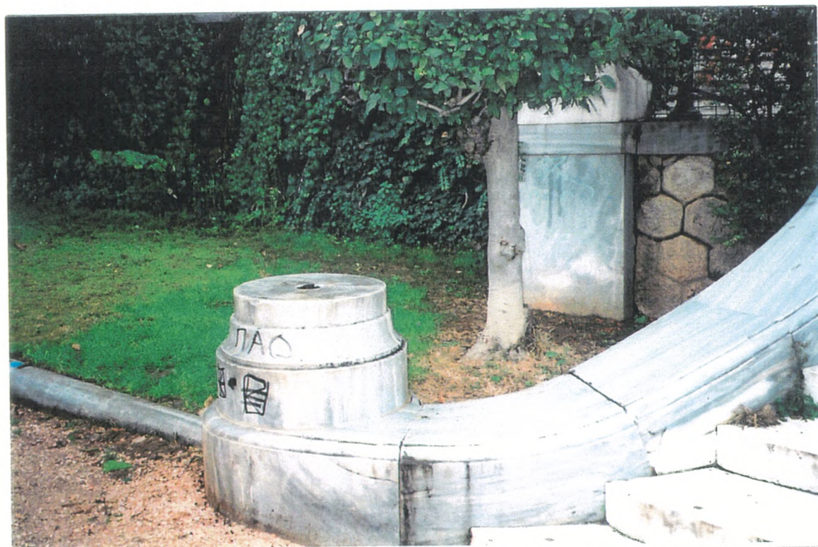
Απόληξη της μεγαλοπρεπούς κλίμακας στην Πλατεία Πλατάνου. Ολόσωμα μάρμαρα στις βαθμίδες, ακόμη και στο διαχωριστικό πεζούλι του παρτεριού. Η κυκλική βάση του καταληκτικού πεσσού, περιέχει σιδηρούν σύνδεσμο, το οποίο υποδηλοί συνέχειά του, προς το παρόν όμως παραμένει άνωστο το πώς κατέληνε επάνω.
