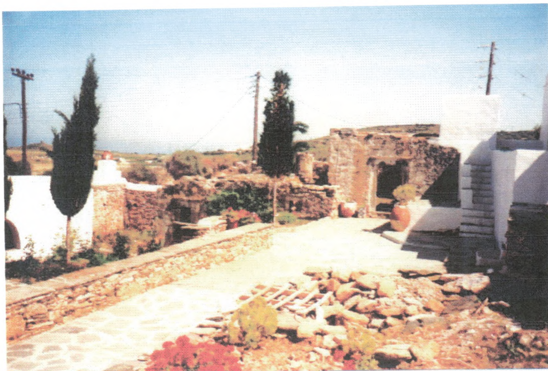
Ἡ αὐλή μπροστά ἀπό τήν δυτική πλευρά μέ τά χαλάσματα τοῦ μεσαίου τμήματος. Στό βάθος ἡ νότια πλευρά πού ἐξακολουθεῖ νά παραμένει ἐρειπωμένη.
