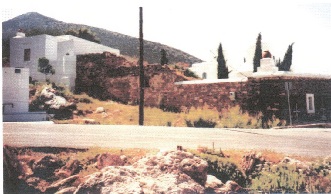
Ἡ νότια πλευρά. Μπροστά ὁ δρόμος πρὸς το Βαθύ. Ὅπως φαίνεται ἡ πλευρά αὐτή ἐξακολουθεῖ νά εἶναι ἐρειπωμένη.
