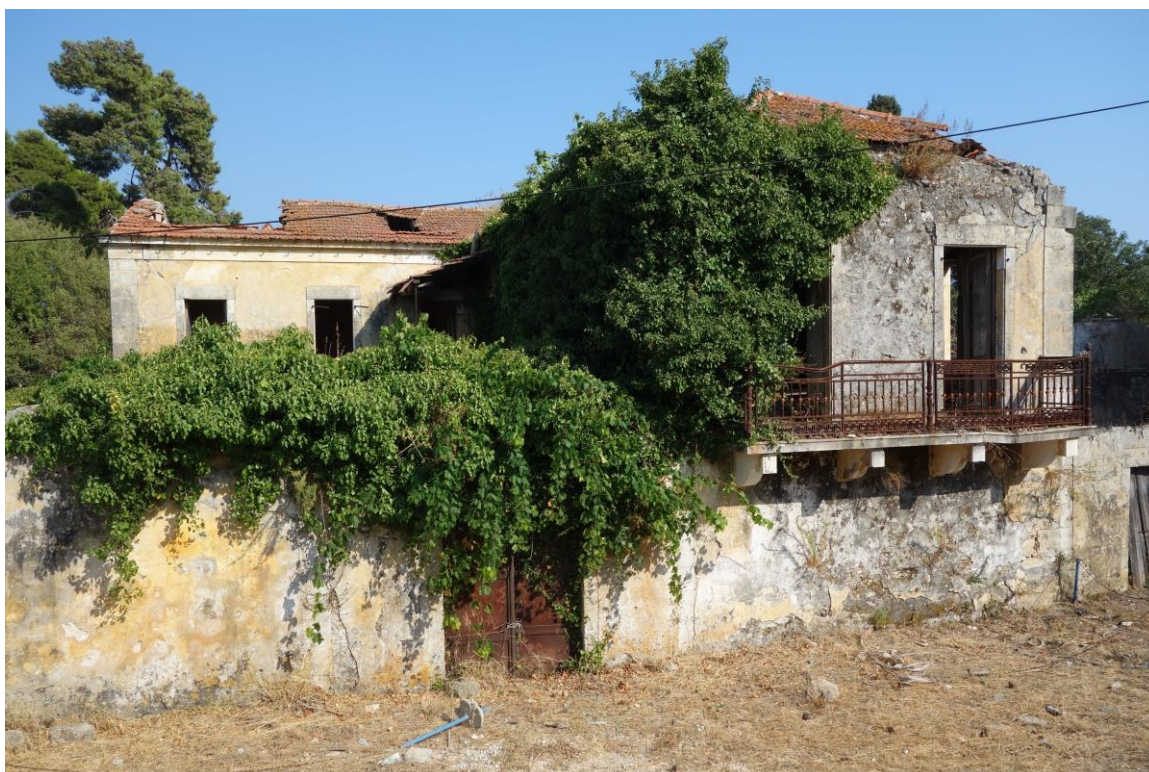
Εικ. 10. Δυτική όψη της οικίας, σημερινή κατάσταση.
