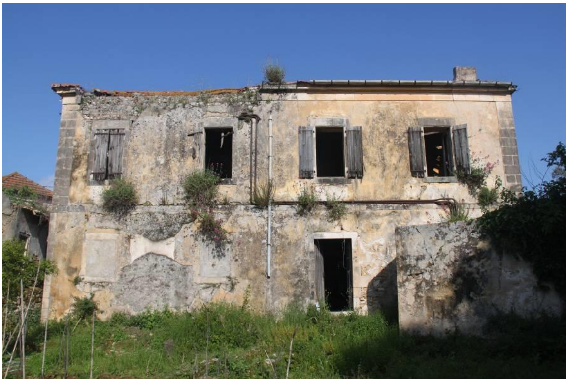
Εικ. 9. Βόρεια όψη της οικίας, σημερινή κατάσταση.
