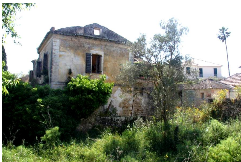
Εικ. 8. Ανατολική όψη της οικίας, σημερινή κατάσταση.
