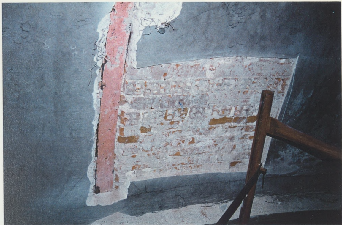
Φωτ. 5. Λεπτομέρεια θόλου του τρούλου. Διακρίνεται η μεικτή κατασκευή από συμπαγή και διάτρητα τούβλα.
