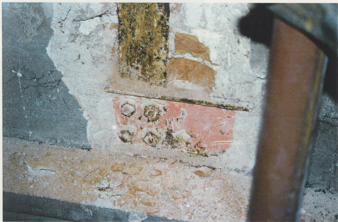
Φωτ. 6. Λεπτομέρεια μεταλλικού σκελετού τρούλου.
