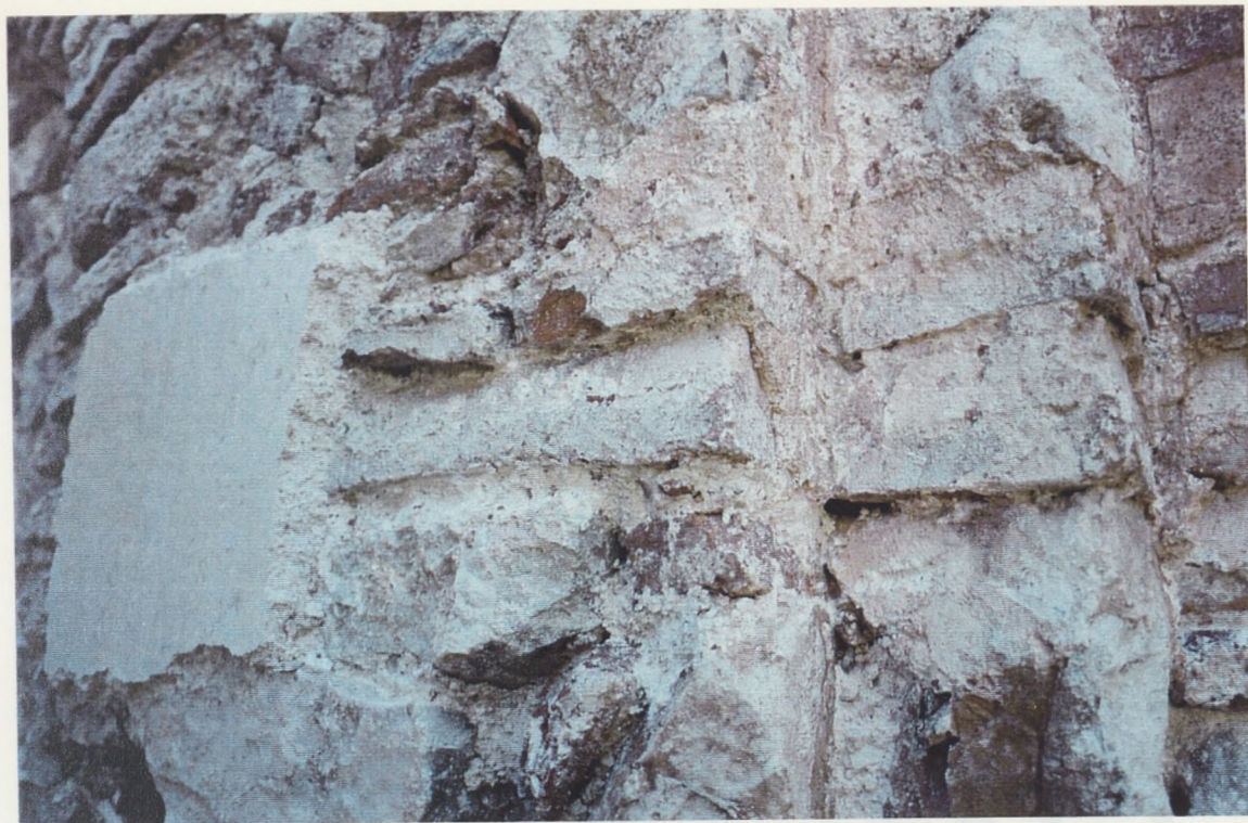
Φωτ. 19. Λεπτομέρεια βόρειας όψης. Διακρίνεται αρμολόγημα με κύριο συστατικό τον ασβέστη.
