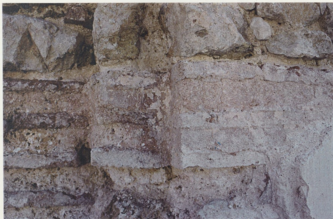
Φωτ. 20. Λεπτομέρεια βόρειας όψης. Διακρίνεται αρμολόγημα με κουρασάνι..
