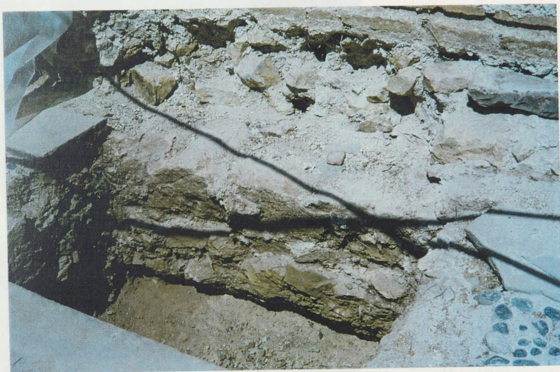
Φωτ. 10. Λεπτομέρεια θεμελίωσης τοίχου κυρίως ναού.
