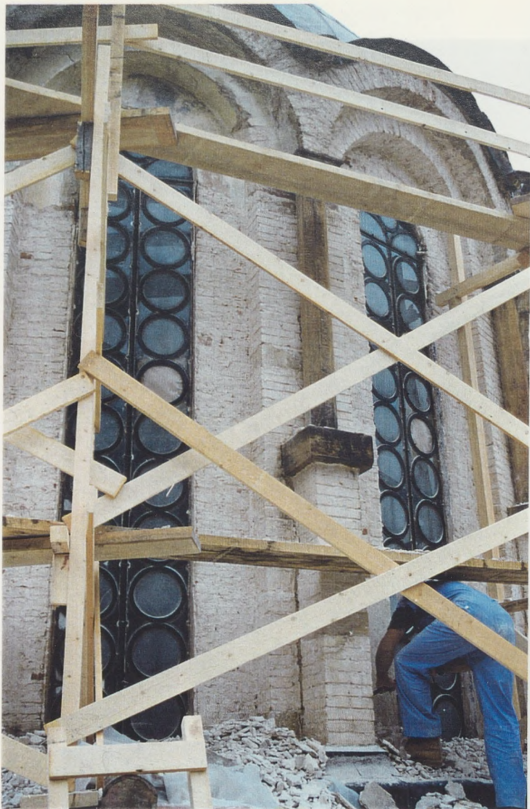
Φωτ. 3. Αποψη του τρούλου μετά την καθαίρεση των εξωτερικών επιχρισμάτων.
