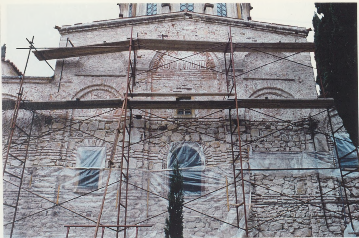
Φωτ. 13. Αποψη της νότιας όψης μετά την καθαίρεση των επιχρισμάτων.
