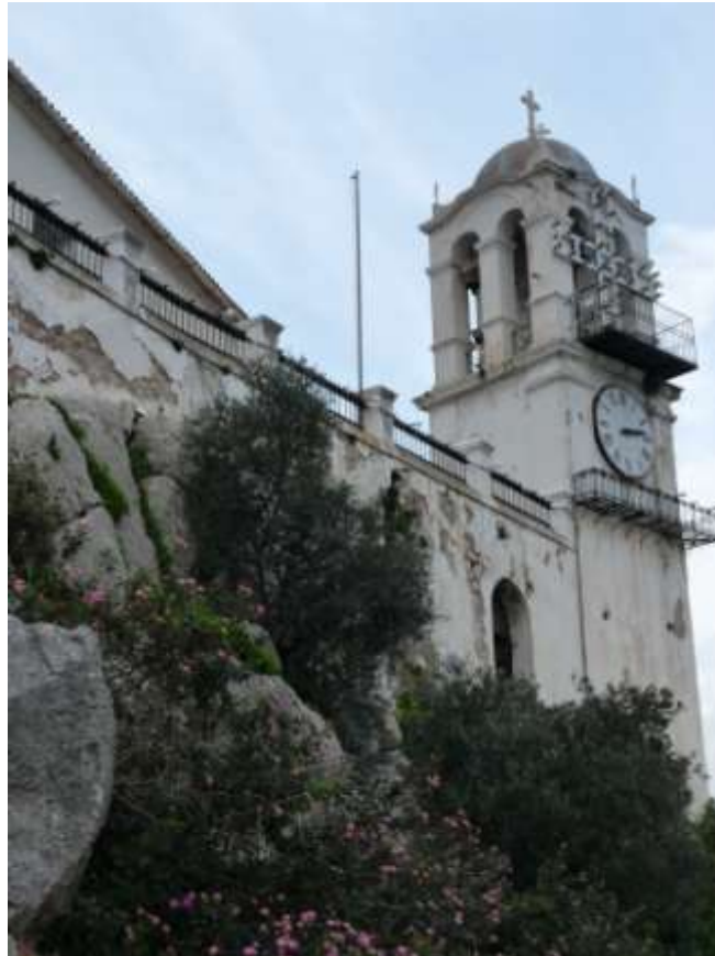
39. Άποψη του κωδωνοστασίου από τα νοτιοανατολικά. Αριστερά από τη βάση του φαίνεται η θύρα πρόσβασης στο χώρο 118.
