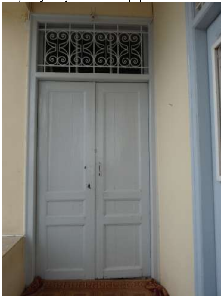
46. Άποψη του ημιυπαίθριου χώρου 213 του ξενώνα, με τις θύρες πρόσβασης στους εσωτερικούς του χώρους 215 και 214 (δεξιά).
