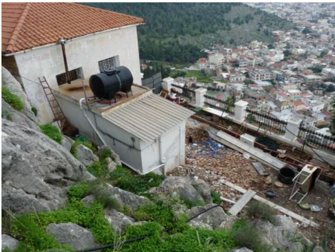
53. Άποψη της αυλής στα νότια του συγκροτήματος με τους πρόσθετους στον ξενώνα χώρους 218 και 219.
