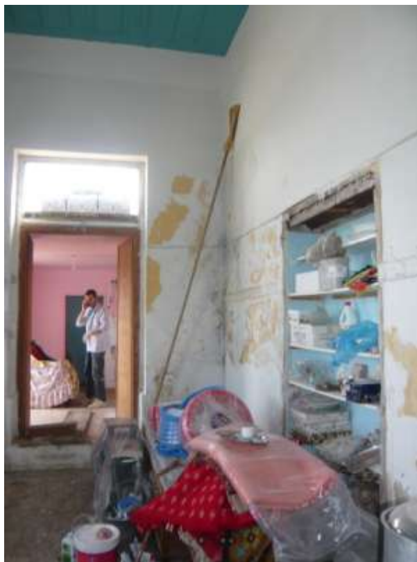
49. Άποψη της νοτιοδυτικής γωνίας του χώρου 216 του ξενώνα, με τη θύρα πρόσβασης στο χώρο 218 (κουζίνα). Στο βάθος διακρίνεται και η θύρα πρόσβασης στο χώρο 219 (WC).
