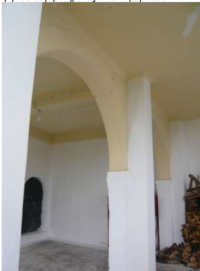
4. Άποψη των χώρων 101 και 102 από τα βόρεια, με τη θύρα πρόσβασης στο χώρο 103.
