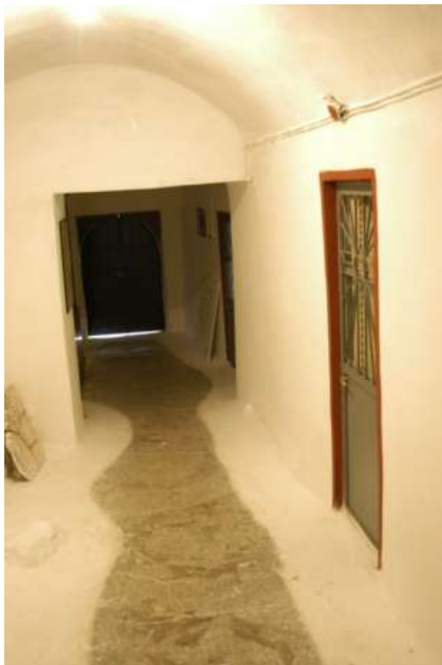
5. Άποψη του χώρου 105 από τα νοτιοανατολικά. Μαζί με το χώρο 103 στο βάθος, αποτελούν το δυτικό τμήμα του υπόγειου νότιου διαδρόμου, με τις θύρες πρόσβασης στους χώρους 107 και 104 (στο βάθος).
