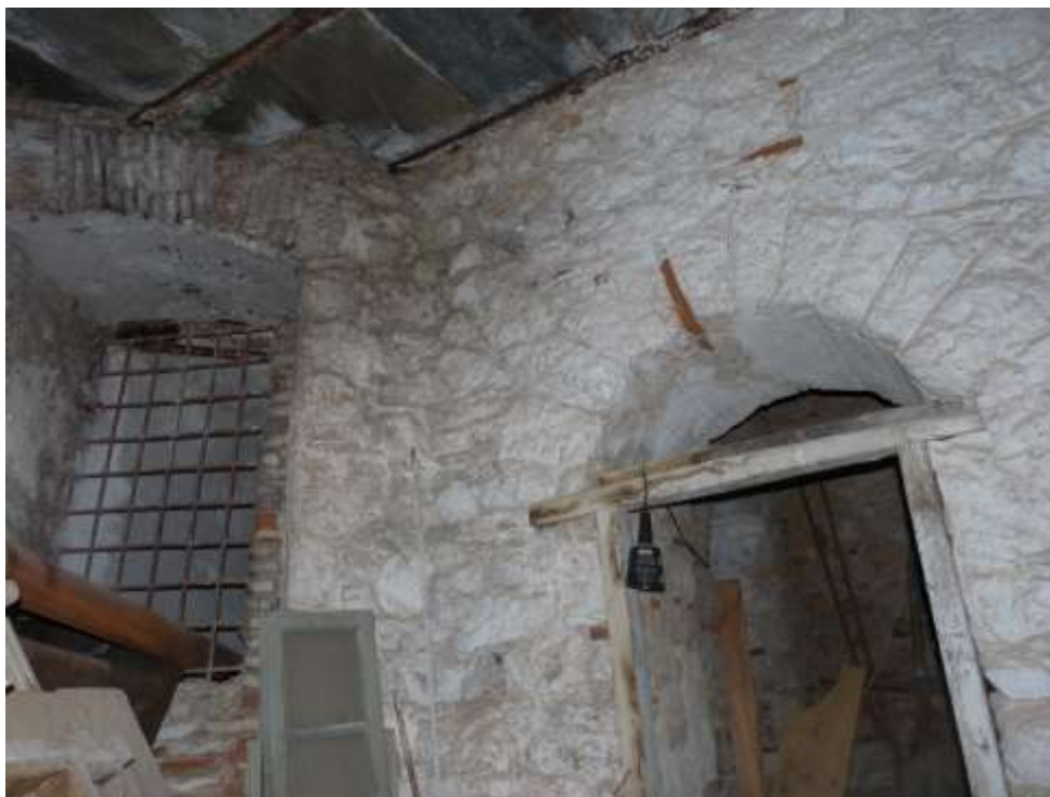
15. Άποψη του βορειοδυτικού τμήματος του χώρου 118, με το τοξωτό άνοιγμα πρόσβασης στο χώρο 117.
