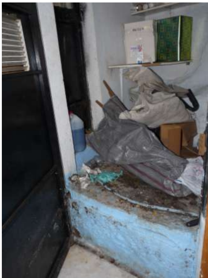
21. Άποψη του χώρου 202 στον εξωνάρθηκα όπως φαίνεται από τη θύρα πρόσβασης του χώρου 203. Στα αριστερά η θύρα εξόδου στον εξωτερικό νοτιοδυτικό διάδρομο.
