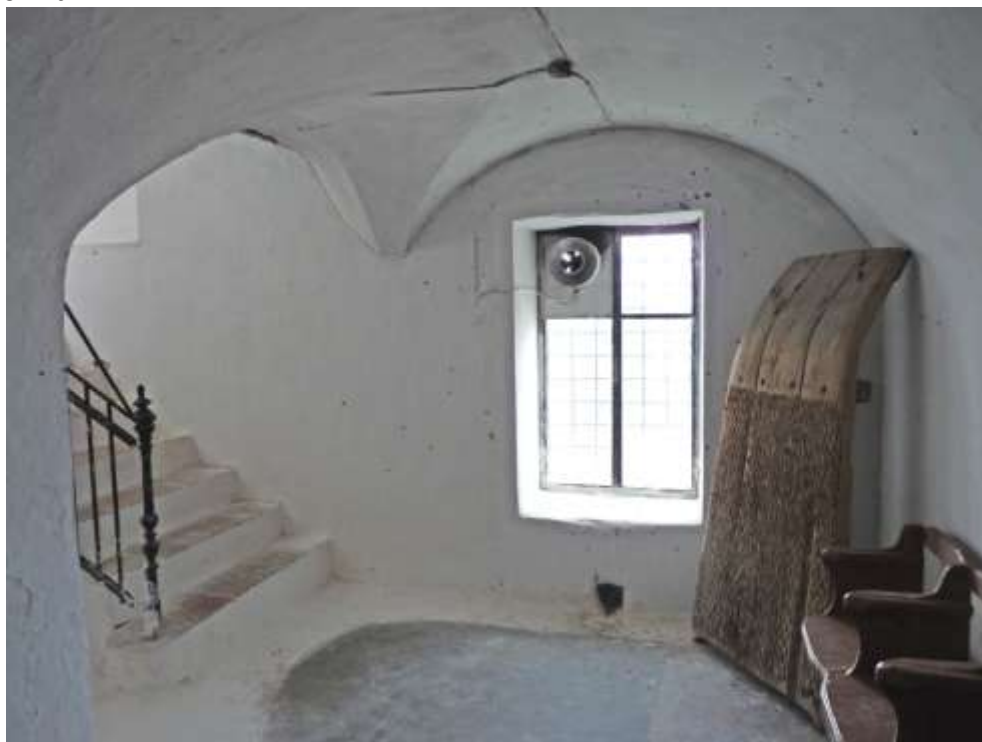
10. Άποψη του ανατολικού τμήματος του νότιου υπόγειου διαδρόμου (χώρος 110) και αριστερά η κλίμακα ανόδου στην αυλή του συγκροτήματος (χώρος 211).
