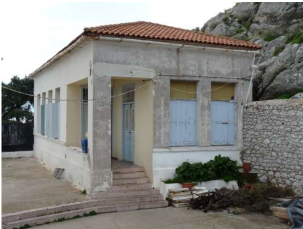
45. Άποψη του κτίσματος του ξενώνα από τα βόρεια.
