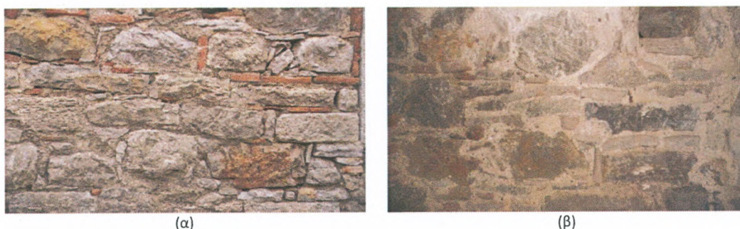
Εικ. 2.2: Δόμηση τοιχοποιίας: (α) εξωτερική και (β) εσωτερική παρειά.
