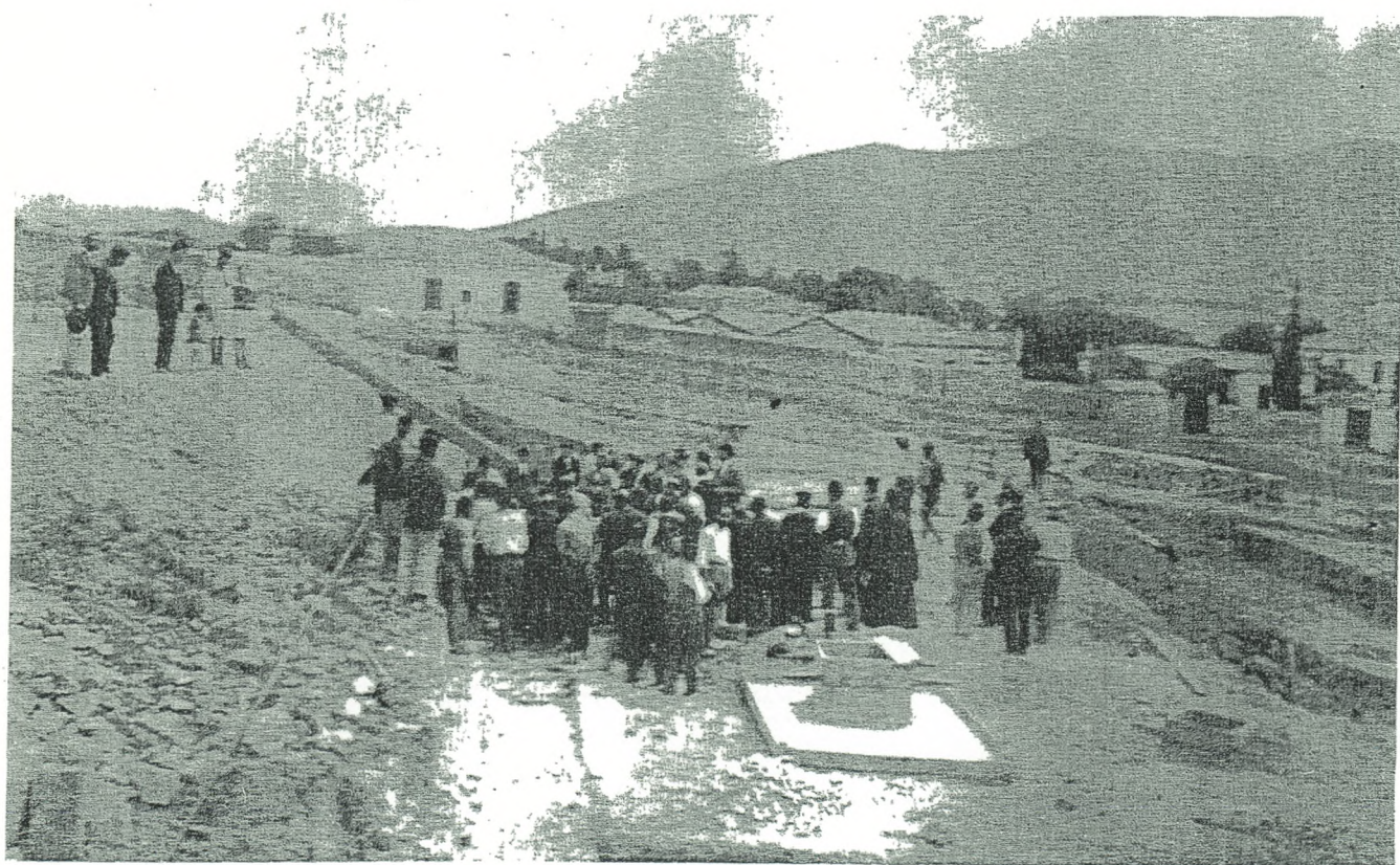
Στο πρώτο μέρος διακρίνονται οι εργασίες θεμελιώσεως της Αμερ. Σχολής. Πέραν του χώρου της Σχολής φαίνεται ο μανδρότοιχος του Στρατοπέδου, οποίος άρχιζε από την σημερινή οδόν Αθηναίων Εφήβων και δια της Ιατρίδου έφθανε στην λεωφορ. Βασ. Σοφίας. Δεξιά της εκτός του τείχους οικίας, διακρίνεται το οίκημα Λυράκη του 401 Γ.Σ. Νοσοκομείου.
