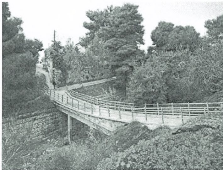
Εικ. 15. Άποψη προς την οδό Βριλησίων Δήμου Αμαρουσίου της υφιστάμενης μπετονένιας γέφυρας του ρέματος από όπου ως πρόσφατα διέρχονταν τα αυτοκίνητα των κατοίκων χωρίς να επιβαρύνουν τη βορειότερα κείμενη στενή οδό Σισμανογλείου.
