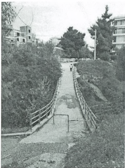
Εικ. 14. Άποψη προς την οδό Ομήρου Δήμου Βριλησίων της υφιστάμενης μπετονένιας γέφυρας του ρέματος από όπου ως πρόσφατα διέρχονταν τα αυτοκίνητα των κατοίκων της περιοχής.
