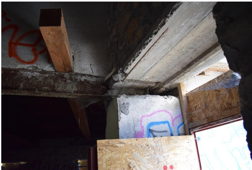
Φ35. Θέσεις αποσπασμένων ξύλινων πρεκίων που θέλουν αποκατάσταση.
