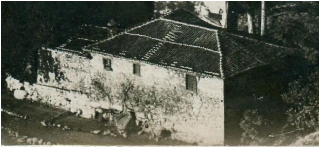
(1917) 20 Η δυτική όψη του ισόγειου τμήματος.
