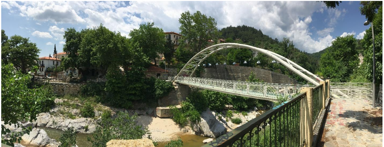
Φ1. Το 2015, στην ίδια σχεδόν θέση της 1 ης γέφυρας του Σαμακώβ, λίγο νοτιότερα και δίπλα ακριβώς στον Νερόμυλο, κατασκευάστηκε η σημερινή κρεμαστή μεταλλική πεζογέφυρα.
