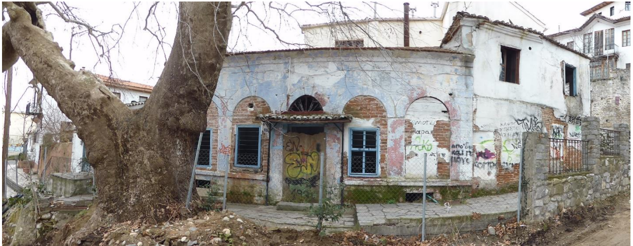
Φ63. (2015) Τα κτίσματα επί της οδού Πινδάρου 27 & Σοφοκλέους
