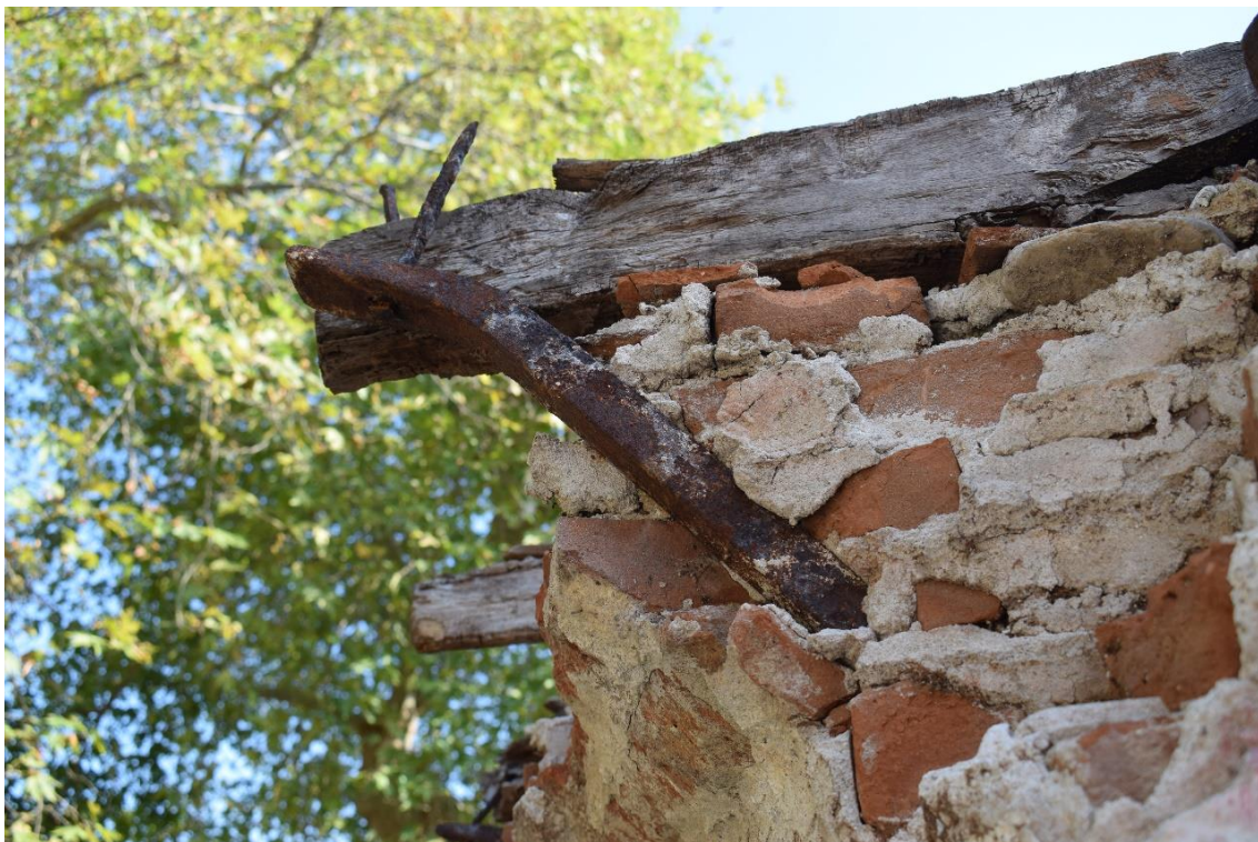
Φ86. Το ξύλινο μεσοπάτωμα εξείχε κατά 0,47cm και σχημάτιζε ένα μικρό σαχνισί. Για την υποστήριξη των προεξεχόντων ξύλινων γρεδιών υπήρχαν μεταλλικά, κυρτωμένα στο άκρο, σίδερα.
