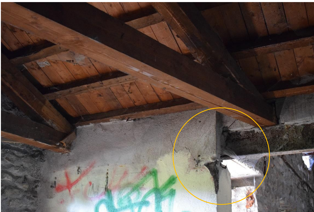
Φ27. Η έδραση της μεταλλικής δοκού, στην ένωση των δύο κτισμάτων, χρειάζεται ενίσχυση.
