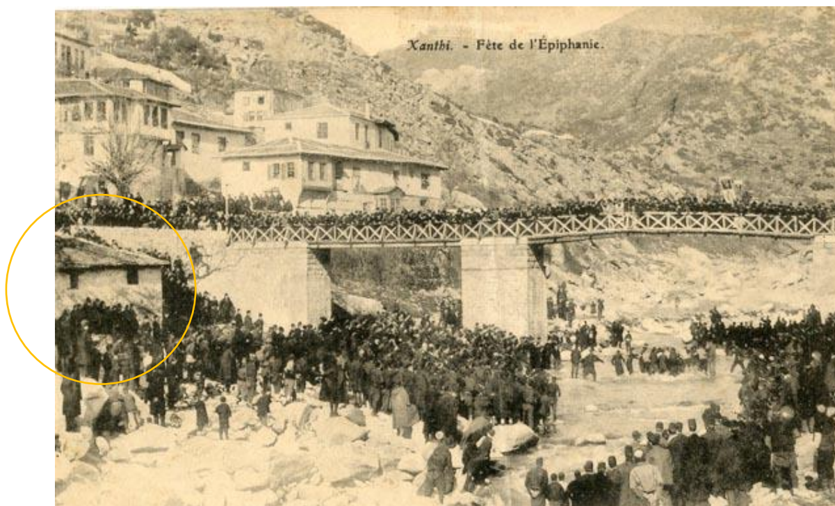
Φ5 3 . Η δεύτερη μορφή της 1 ης γέφυρας του Κόσυνθου, γύρω στο 1902, πάνω σε υπερυψωμένα λίθινα βάθρα. Κατέρρευσε στη μεγάλη πλημμύρα του 1912. Στα αριστερά, σημειώνεται το ισόγειο τμήμα του παλιού Νερόμυλου.
