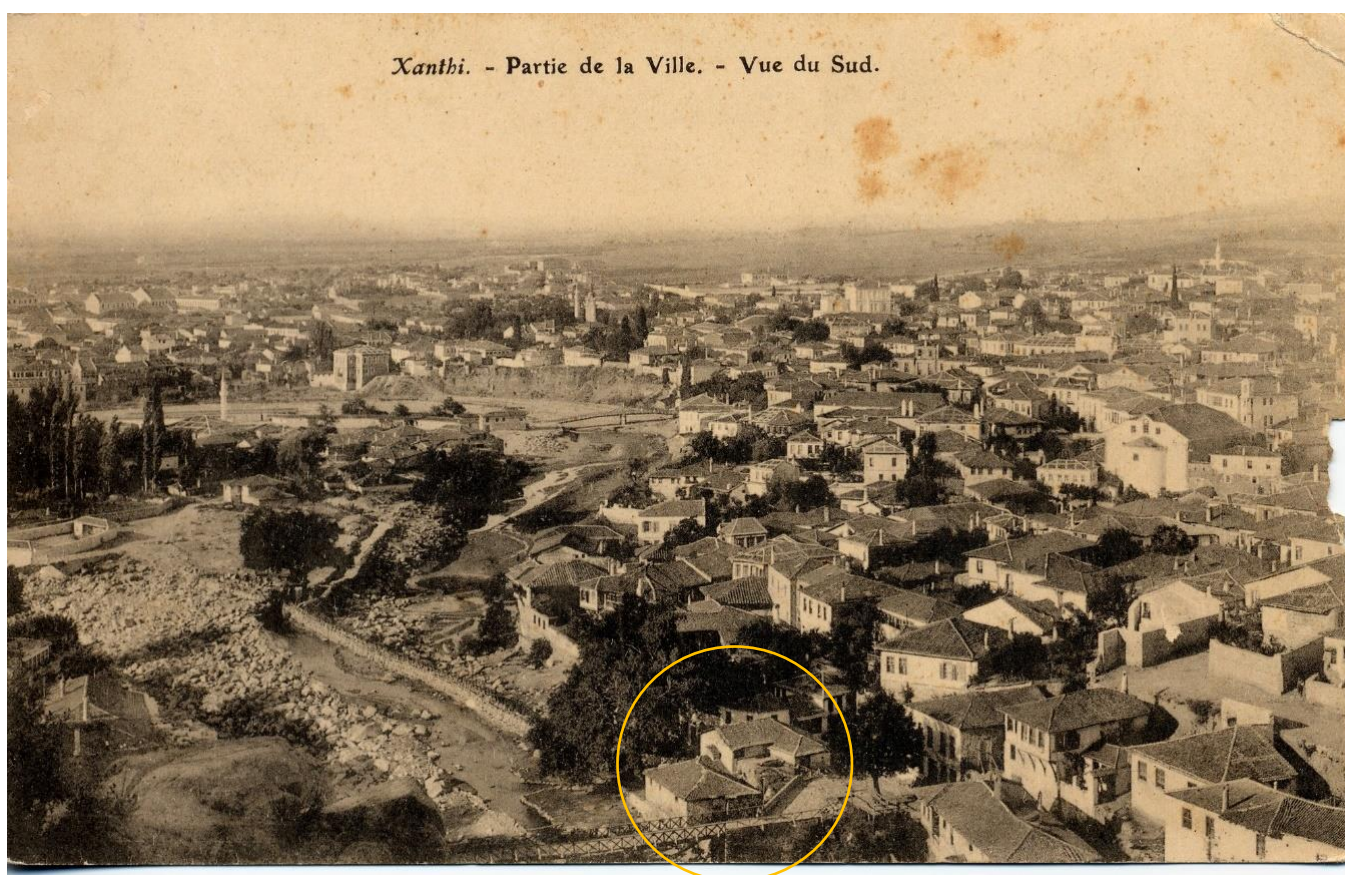
Φ6 4 . Μια εξαιρετική και σπάνια φωτογραφία, γύρω στο 1902, που δείχνει τις δύο κοίτες του ποταμού Κόσυνθου και τις γέφυρες που ένωναν την πόλη. Η δυτική κοίτη του Κόσυνθου,
