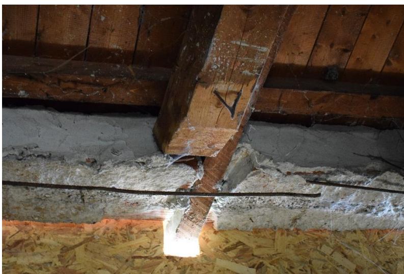
Φ36. Βόρεια είσοδος του ισόγειου κτίσματος. Το πρέκι της εξώθυρας αφαιρέθηκε και η ξύλινη δοκός της στέγης έχει μείνει στο αέρα.
