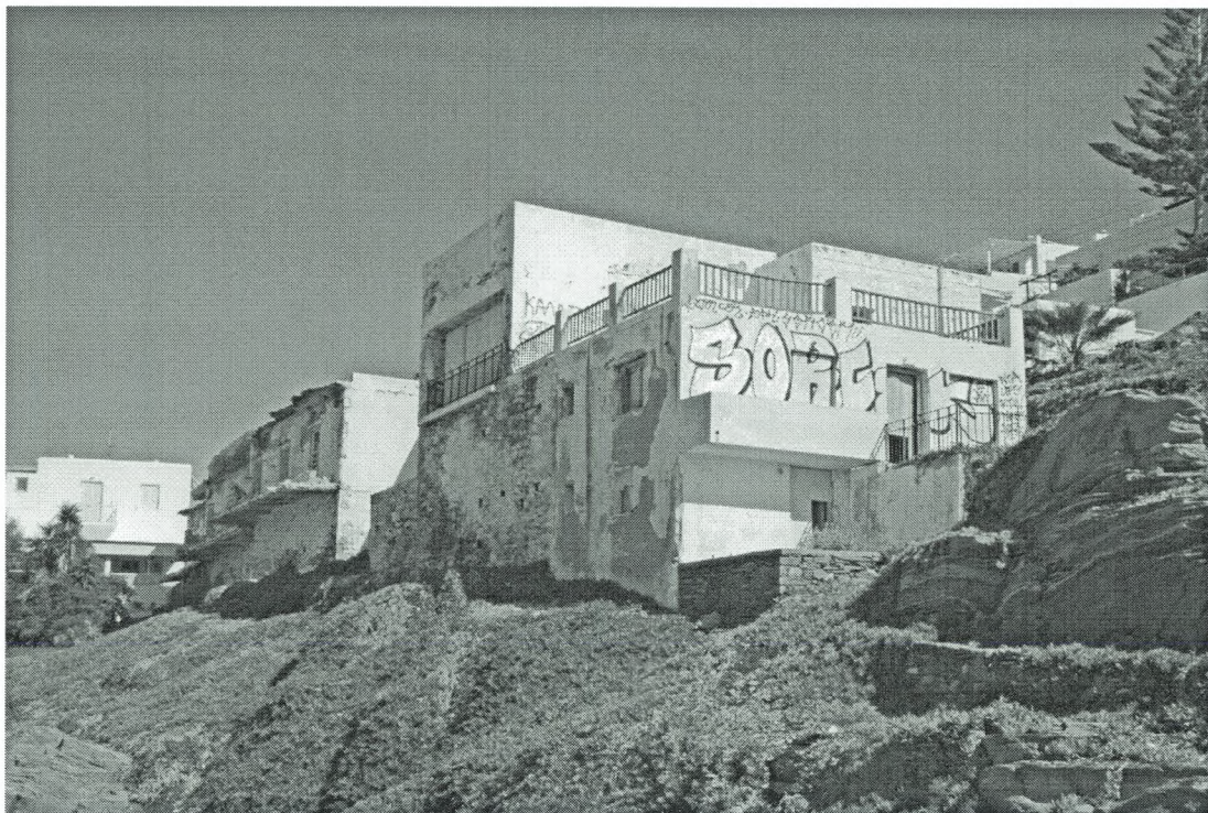
Εικ. 1 Γενική άποψη του κτηρίου από Δ.
