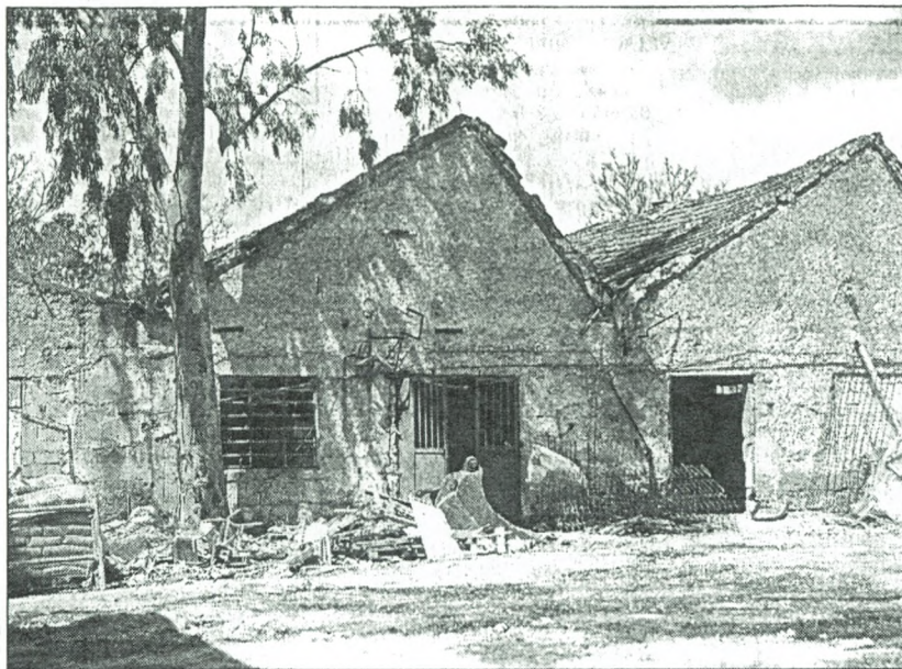
Μερική άποψη του βιομηχανικού συγκροτήματος της Ανατολικής Ταπητουργίας, προσφυγική μνήμη της Νέας Ιωνίας, που κινδυνεύει με αφανισμό.
