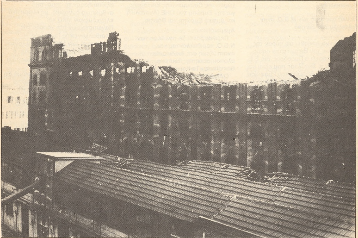
Όπως φαίνεται και στην φωτογραφία ολοσχερώς είχε καεί μόνον ο τελευταίος όροφος (1950).
