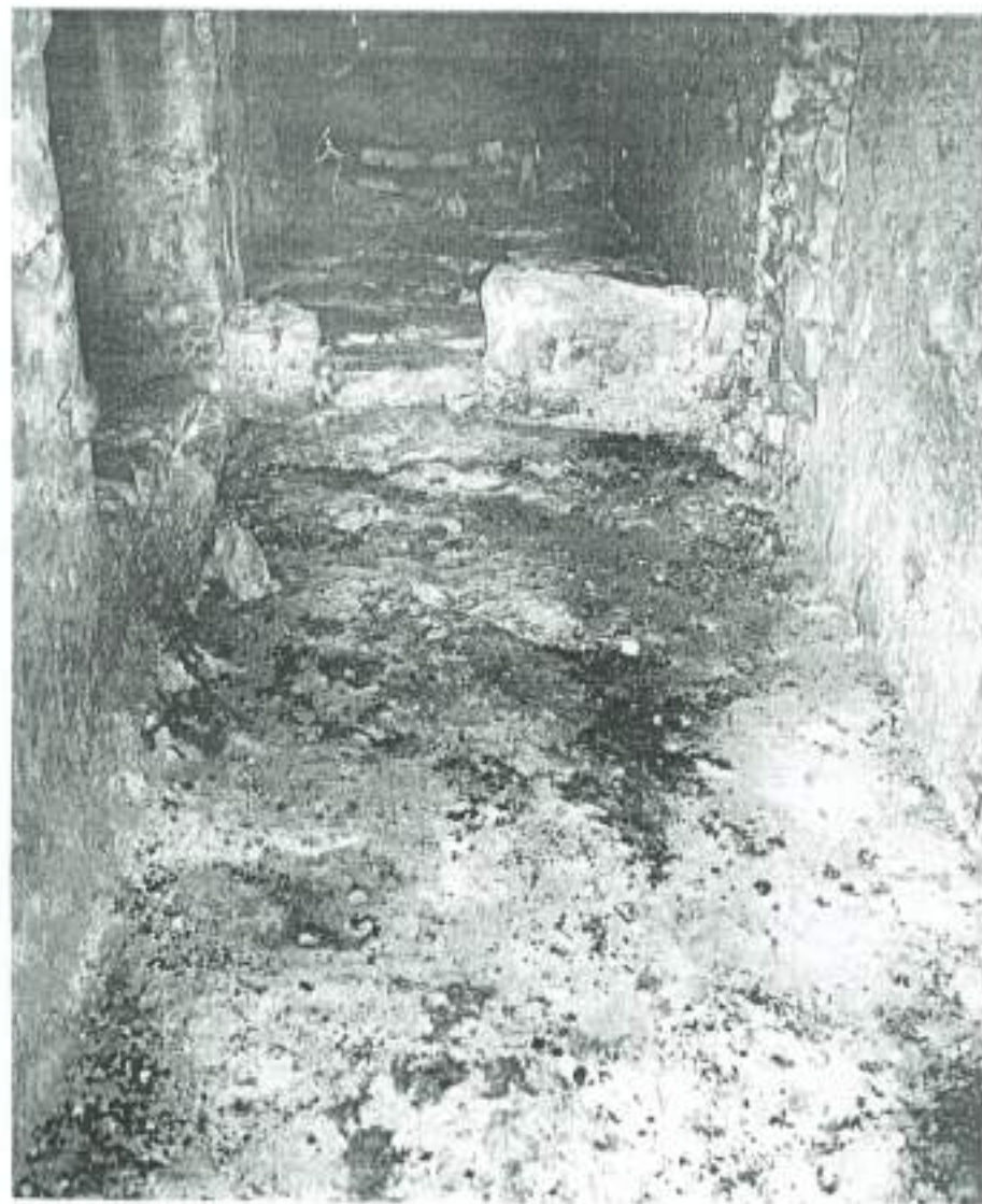
Εσωτερικό του παρεκκλησίου. Στο δάπεδο υπάρχουν ίχνη κονιάματος, στο βάθος χαμηλό σπηθαίο στο υπερυψωμένο δάπεδο. Στα δεξιά η τοιχισμένη θύρα του νότιου τοίχου.
