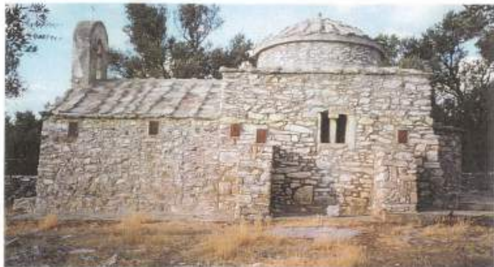
ώτερο αρμολόγημα και στέγαση. 26 b Jointoyage et toiture ents.
