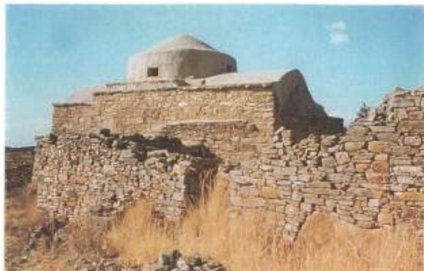
Αγιος Αρτέμιος. Αρμολόγημα-τσιμεντοκονία θόλων. Pl. 27a Hagios Artemios. Jointoyage - crépissage des voûtes au ciment.
