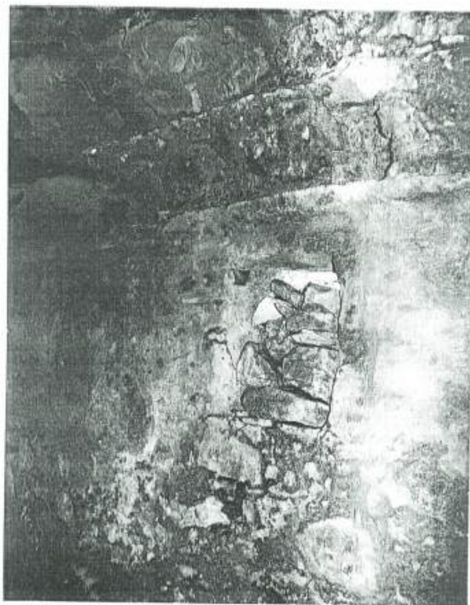
Το φραγμένο παράθυρο στον δυτικό τοίχο του νάρθηκα. Επάνω από αυτό διακρίνεται η γένεση του παλαιού και του νέου θόλου.
