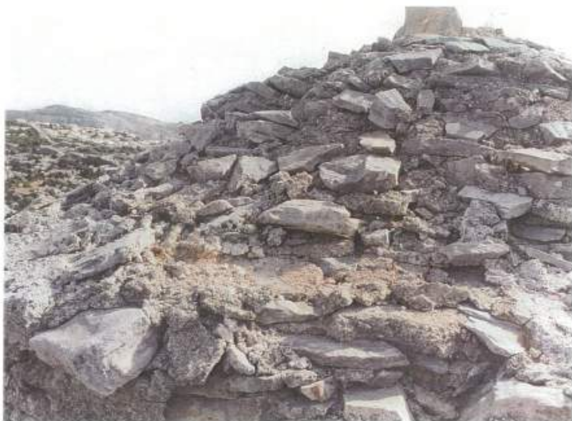
Η κατεστραμμένη επικάλυψη του τρούλλου. Στην κορυφή διακρίνεται το εναπομένον τμήμα του λίθινου σταυρού.
