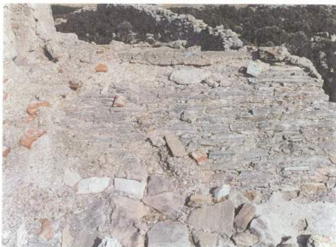
Η καμάρα που καλύπτει την περιοχή του ιερού. Η στέγαση έχει καταστραφεί και διακρίνεται το εξωράχιο με τους πλακοειδείς λίθους.
