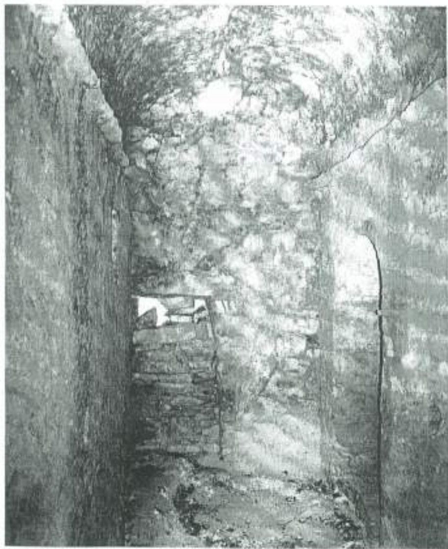
Εσωτερικό του παρεκκλησίου. Στο βάθος ο δυτικός τοίχος με την τοιχισμένη θύρα προς τον νάρθηκα. Στο δάπεδο υπολείμματα παλαιού κονιάματος.
