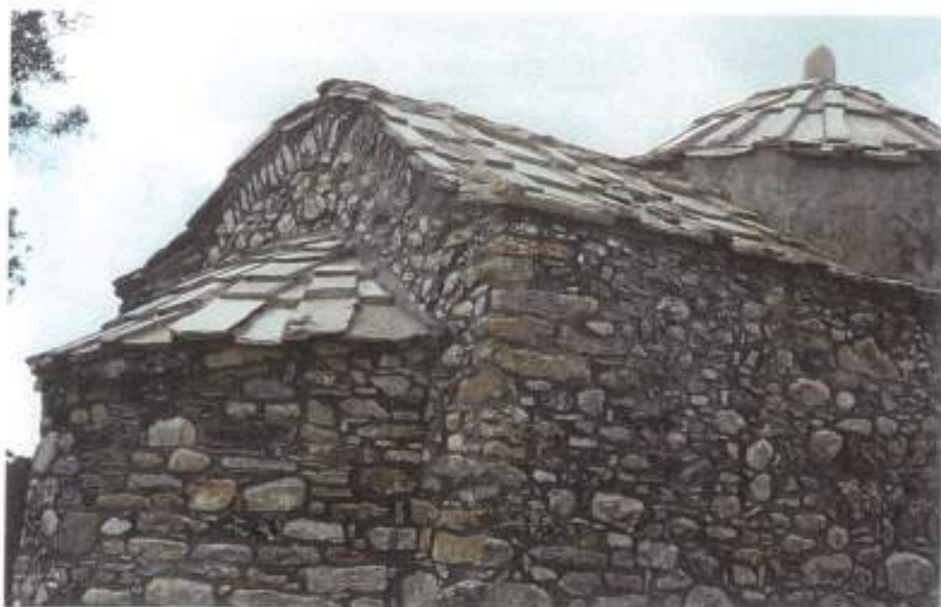
Αγιος Ιωάννης Αδησσαρού. Αρμολόγημα τσιμέντου. Pl. 27 d Hagios Ioannis, Adissaro Jointoyage récent au ciment.
