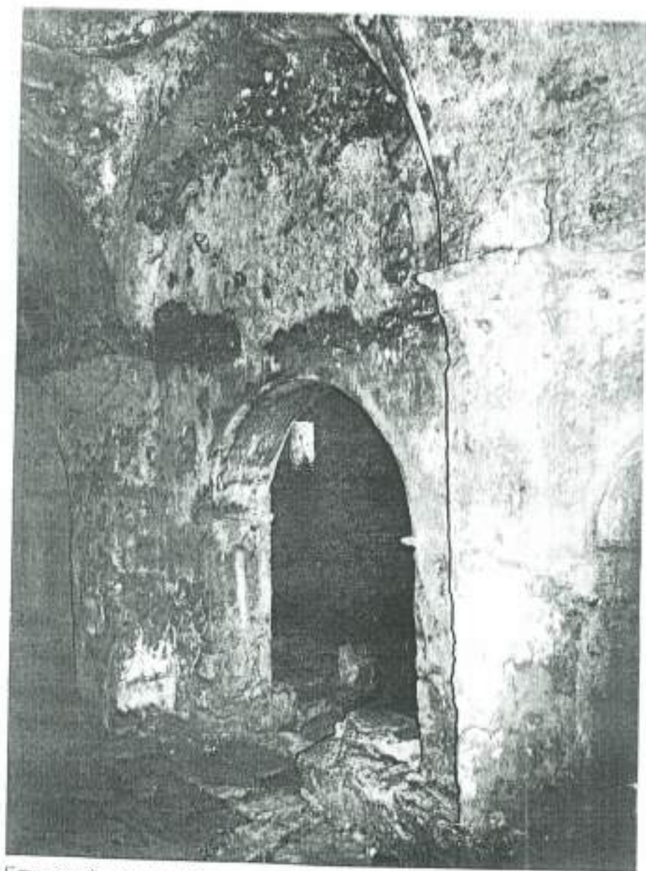
Εσωτερικό του ναού. Το μεσαίο τοξωτό άνοιγμα μεταξύ του ναού και του παρεκκλησίου.
