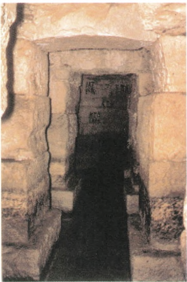
Εικ.9 Άποψη εσωτερικού της δεξαμενής κάτω από το εκκλησάκι
