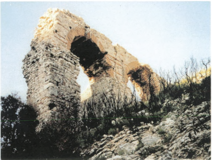
Εικ.19 Υδατογέφυρα Ρωμαϊκού Υδραγωγείου
