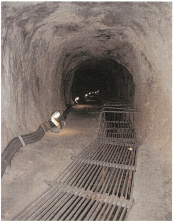
Εικ.7 Εσωτερική άποψη του Ορύγματος
