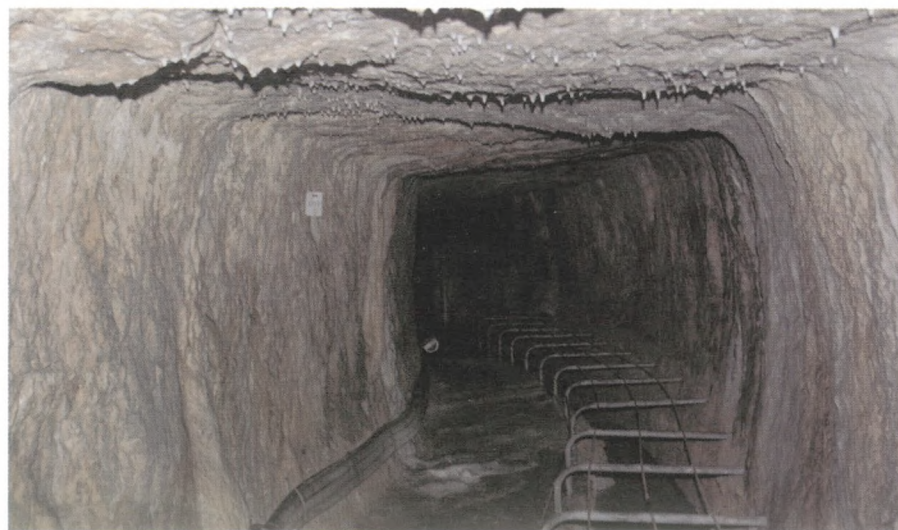
Εικ.5 Εσωτερική άποψη του Ορύγματος
