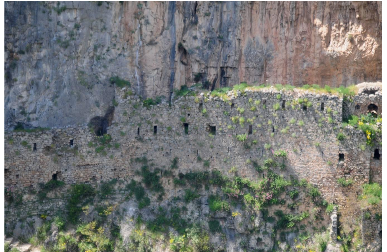
Εικ.49 Παλαιά Μονή Φιλοσόφου. Κτήριο ΚΕ.Κ3. Άποψη από τα Α (ΙΜΑΝΤΩΣΙΣ 2015-06-17).
