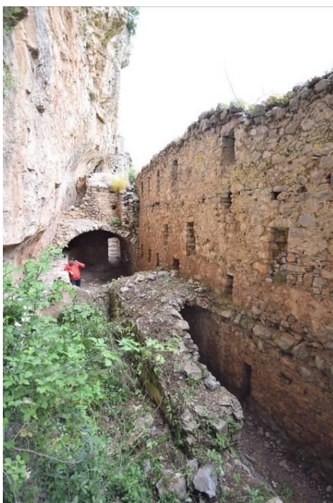
Εικ.52 Παλαιά Μονή Φιλοσόφου. Κτήριο ΚΕ.Κ3. Άποψη εσωτερικού προς τα ΒΑ (ΙΜΑΝΤΩΣΙΣ 2015-06-17).
