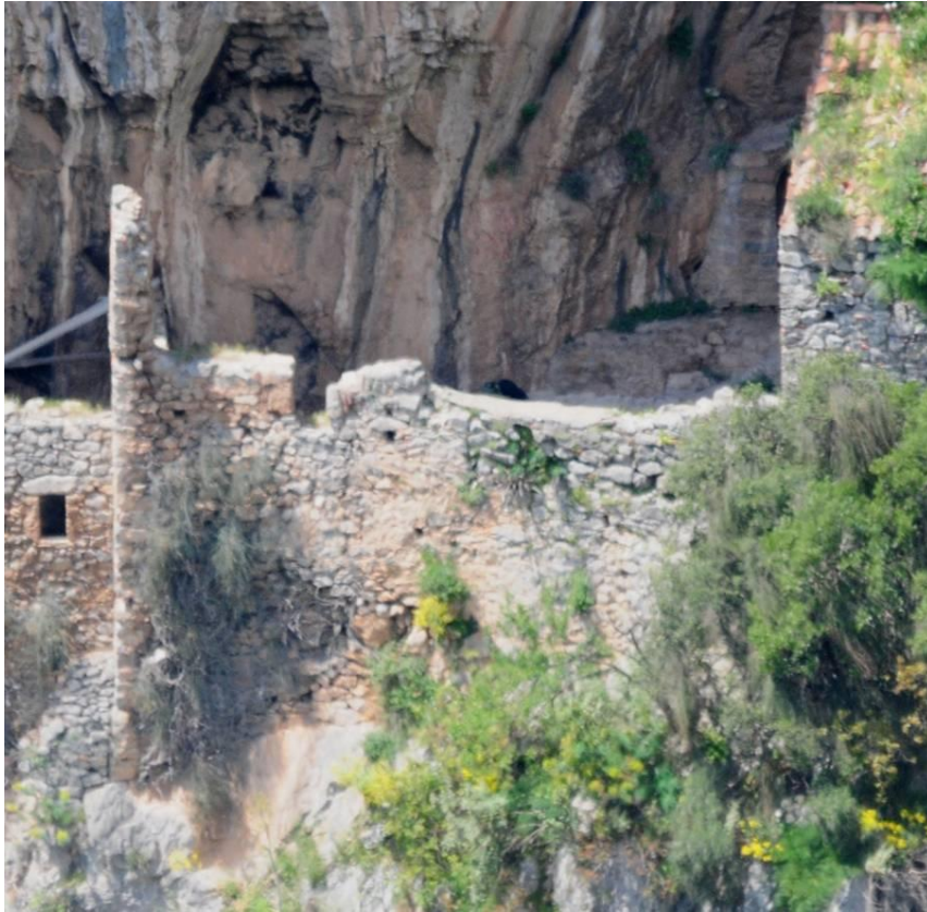
Εικ.26 Παλαιά Μονή Φιλοσόφου. Κτήριο ΒΕ.Κ1. Άποψη από τα Α (ΙΜΑΝΤΩΣΙΣ 2015-06-17).
