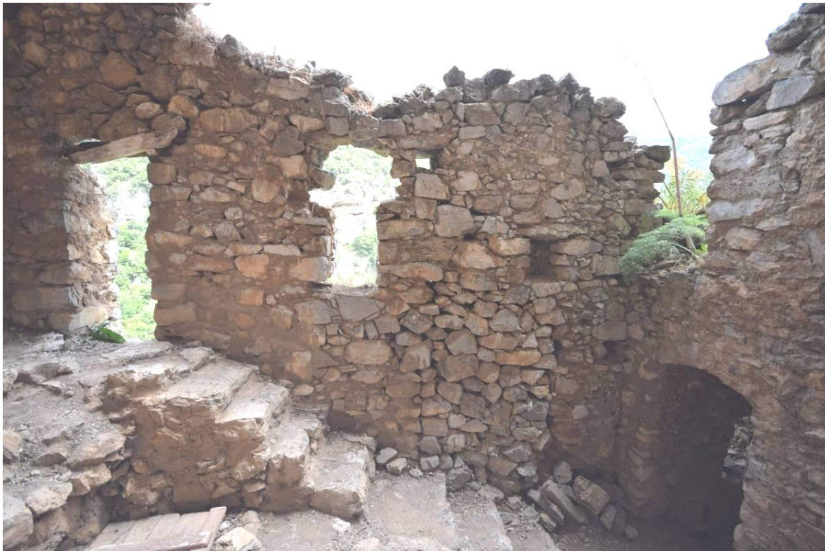
Εικ.38 Παλαιά Μονή Φιλοσόφου. Κτήριο ΚΕ.Κ5. Άποψη εσωτερικού χώρου ΚΕ.Κ5.101 προς τα Α (ΙΜΑΝΤΩΣΙΣ 2015-06-17).
