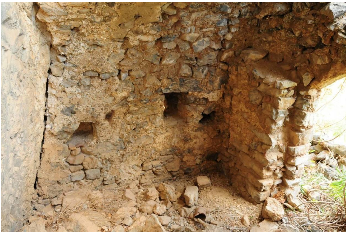
Εικ.48 Παλαιά Μονή Φιλοσόφου. Κτήριο ΚΕ.Κ4. Άποψη εσωτερικού χώρου ΚΕ.Κ4.203 προς τα ΒΑ (ΙΜΑΝΤΩΣΙΣ 2015-06-22)
