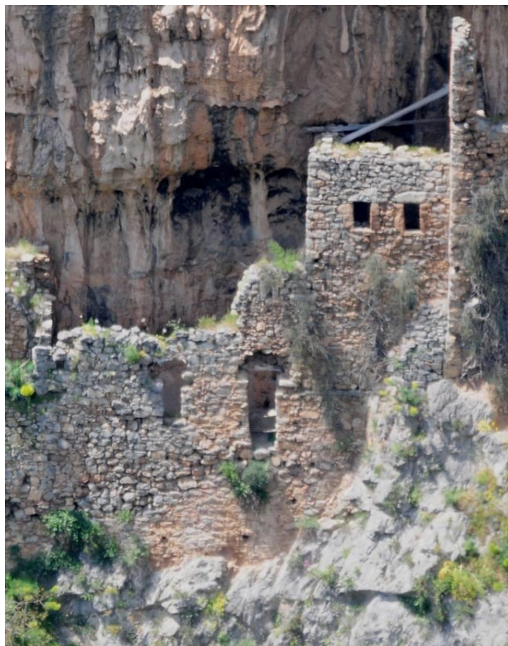
Εικ.33 Παλαιά Μονή Φιλοσόφου. Κτήριο ΚΕ.Κ5. Άποψη από τα Α (ΙΜΑΝΤΩΣΙΣ 2015-06-17).
