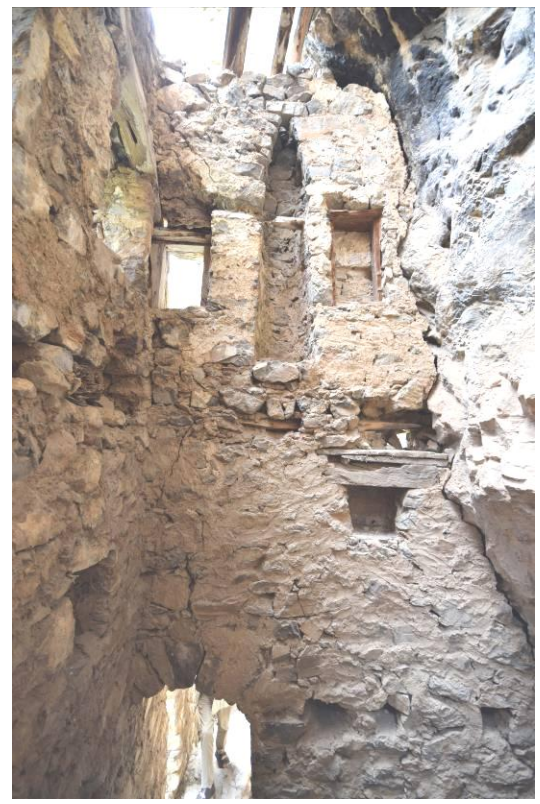
Εικ.41/42 Παλαιά Μονή Φιλοσόφου. Κτήριο ΚΕ.Κ5. Άποψη εσωτερικού χώρων ΚΕ.Κ5.102 & 202 προς τα Ν (ΙΜΑΝΤΩΣΙΣ 2015-06-17)
