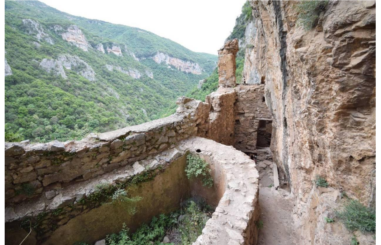
Εικ.29 Παλαιά Μονή Φιλοσόφου. Κτήριο ΒΕ.Κ1. Άποψη εσωτερικού προς τα Ν (ΙΜΑΝΤΩΣΙΣ 2015-06-17).
