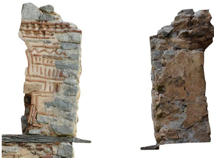
Εικ.31 Παλαιά Μονή Φιλοσόφου. Κτήριο ΒΕ.Κ1. Θ ΒΕ.Κ1 Θ 201. Εξωτερική όψη (Ορθοφωτογραφία ΙΜΑΝΤΩΣΙΣ).
