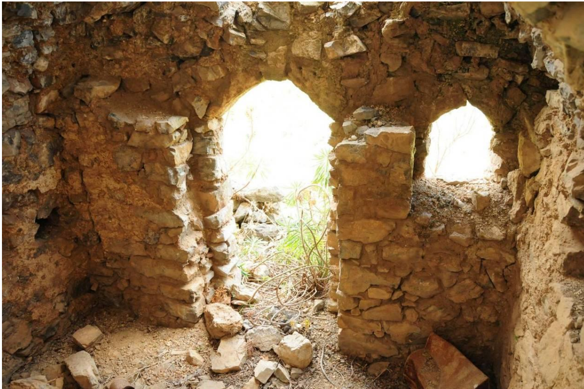
Εικ.47 Παλαιά Μονή Φιλοσόφου. Κτήριο ΚΕ.Κ4. Άποψη εσωτερικού χώρου ΚΕ.Κ4.203 προς τα Α (ΙΜΑΝΤΩΣΙΣ 2015-06-22).
