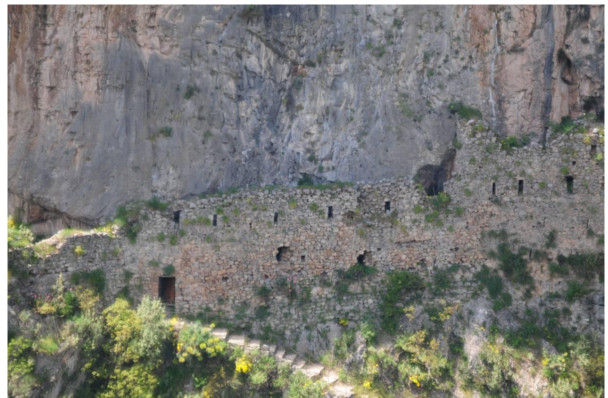
Εικ.56 Παλαιά Μονή Φιλοσόφου. Κτήριο ΚΕ.Κ2. Άποψη από τα Α (ΙΜΑΝΤΩΣΙΣ 2015-06-17).
