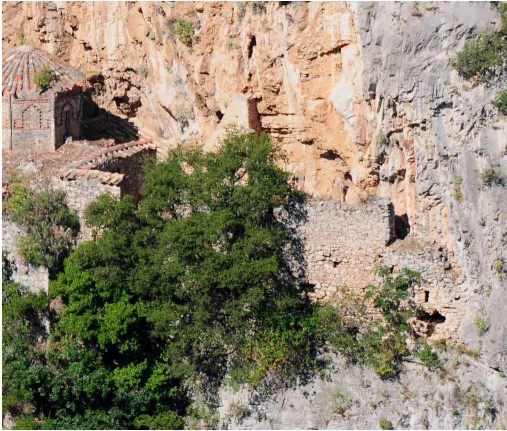
Εικ.21 Παλαιά Μονή Φιλοσόφου. Κτήριο ΒΕ.Κ2. Άποψη από τα Α (ΙΜΑΝΤΩΣΙΣ 2015-06-17).
