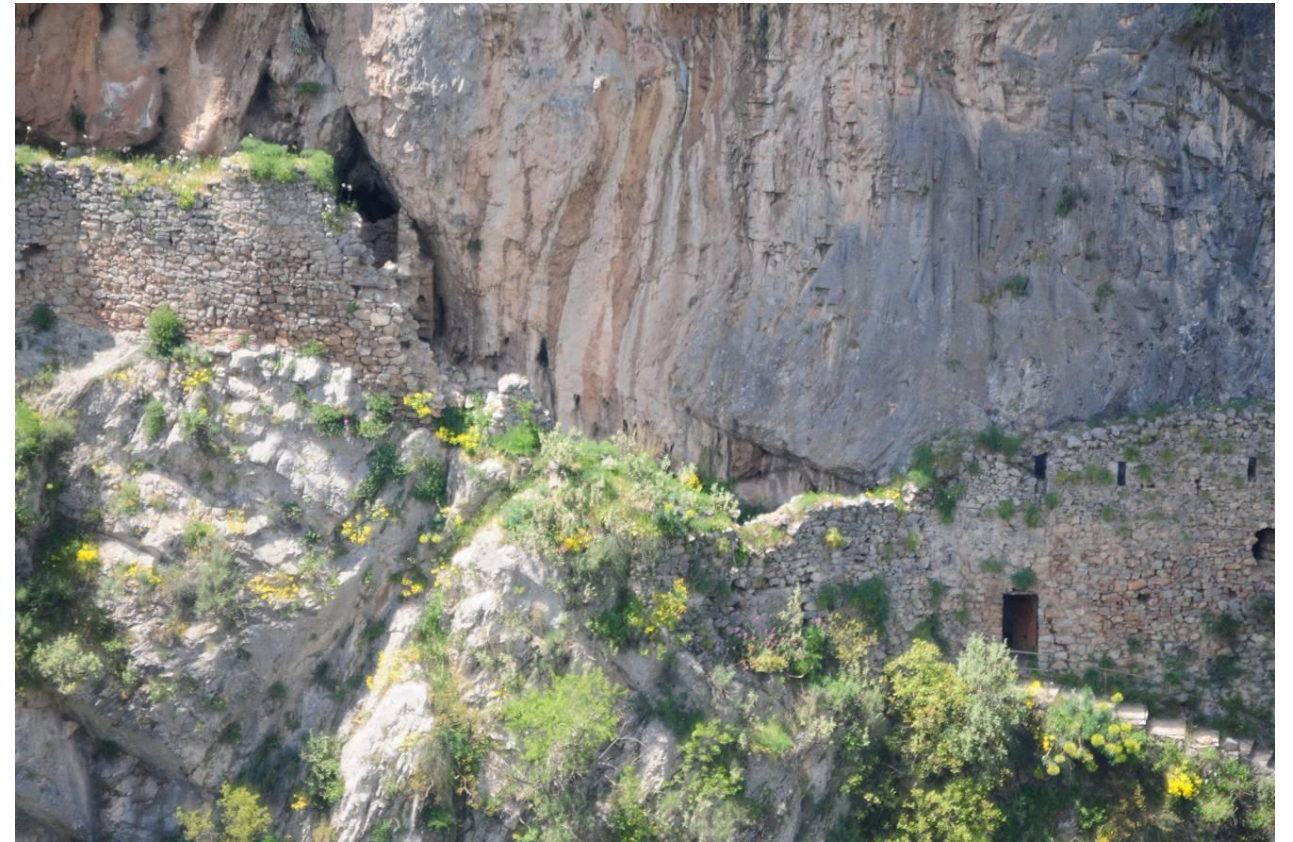
Εικ.61 Παλαιά Μονή Φιλοσόφου. Κτήριο ΚΕ.Κ1. Άποψη από τα Α (ΙΜΑΝΤΩΣΙΣ 2015-06-17).
