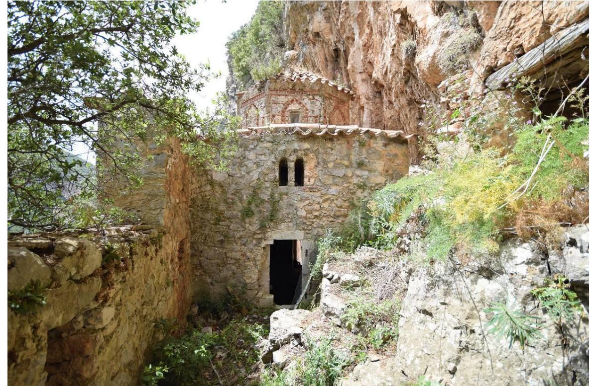
Εικ.23 Παλαιά Μονή Φιλοσόφου. Κτήριο ΒΕ.Κ2. Άποψη εσωτερικού προς τα Ν (ΙΜΑΝΤΩΣΙΣ 2015-06-17).
