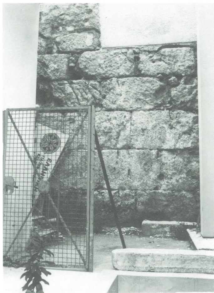
Εικ. 8. Τμήμα του μνημειώδους αναλημματικού τοίχου στην αυλή του ακινήτου οδού Τριπόδων 28.
