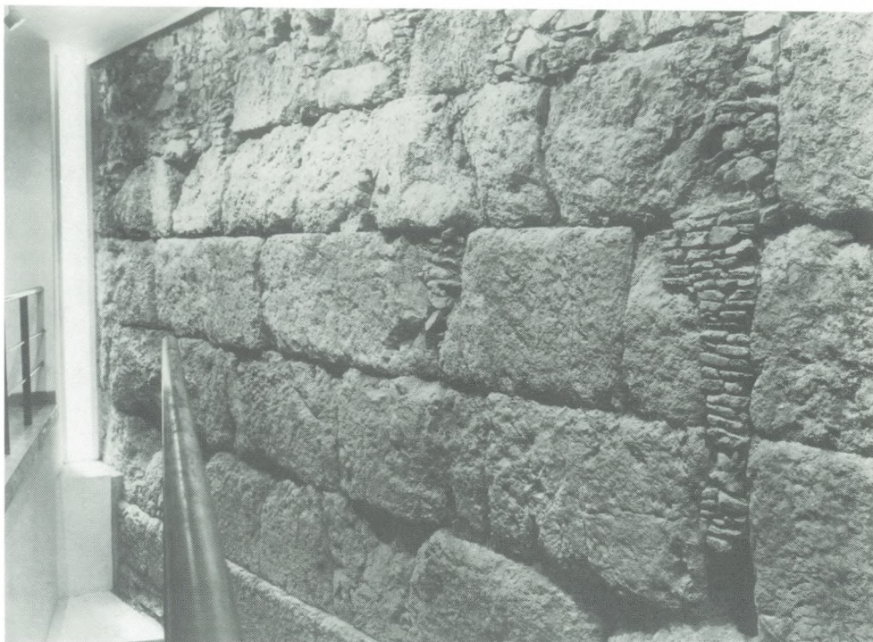
Εικ. 7. Μνημειώδης αναλημματικός τοίχος στο Δ. όριο του ακινήτου οδού Τριπόδων 28, προς την οδό Ραγκαβά.
