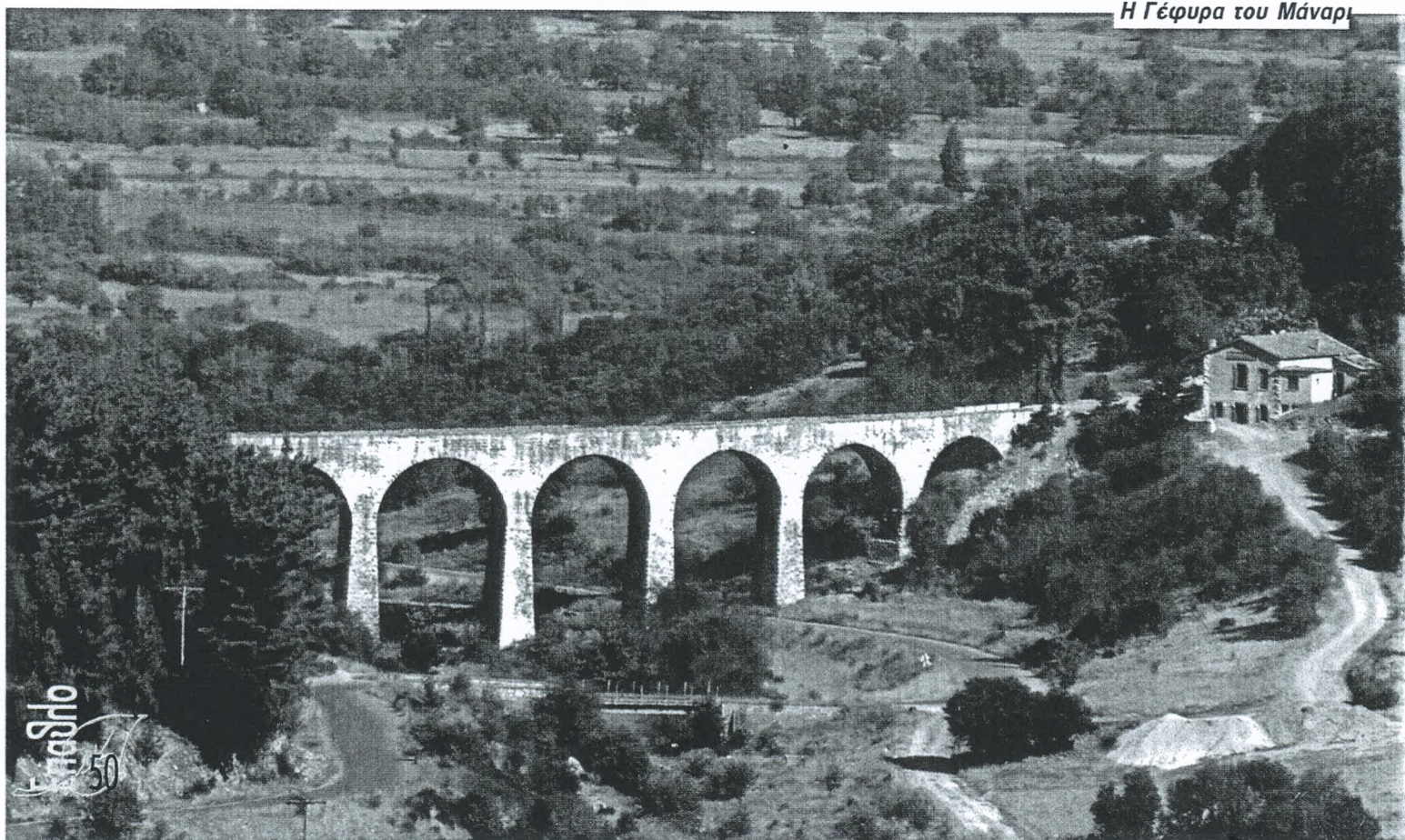
Η Γέφυρα του Μάναρι
