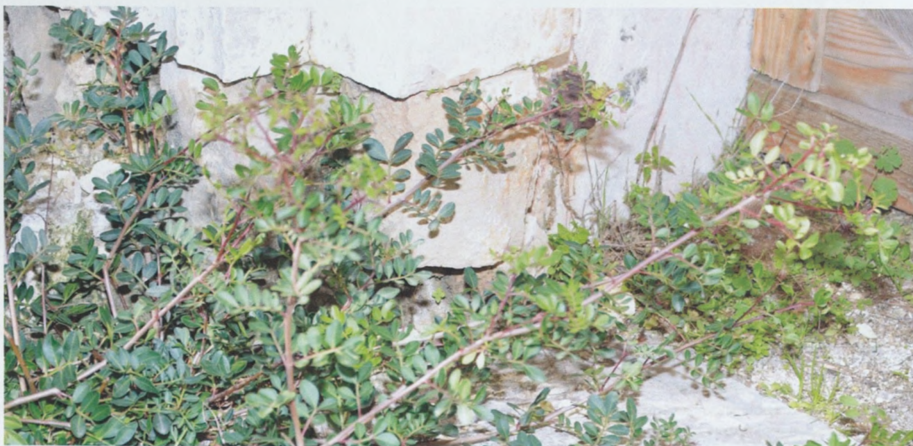
Εικόνα 24 και 25: Άνοιγμα Π4 στη ΝΑ πλευρά του καθολικού, λεπτομέρεια από τη βάση (κρηπίδα) του παραθύρου κάτω δεξιά. Βάση δεξιά παραστάδας και οριζόντιο γείσο με μαύρη κρούστα σε μεγάλη έκταση, από τη δράση βιολογικών παραγόντων. Οι σκοτεινές περιοχές παρουσιάζουν μεγαλύτερο πληθυσμό τέτοιων οργανισμών. Στις σκοτίες των αρμών φύονται άγρια φυτά , τα οποία με το ριζικό τους σύστημα ασκούν μηχανικές πιέσεις στα λίθινα στοιχεία. Κάτω: άγρια βλάστηση δίπλα στο λαμπά της θύρας Θ2.
