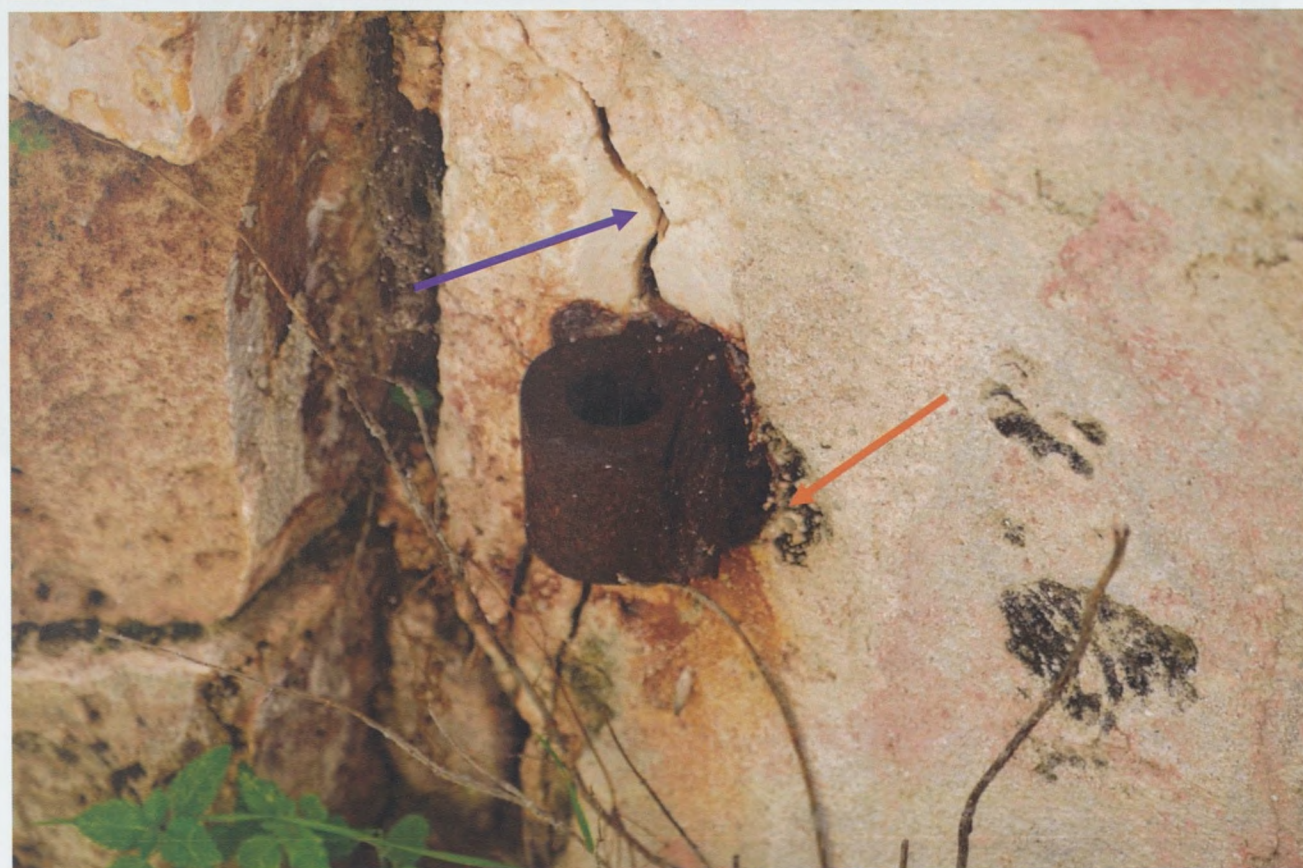
Εικόνα 57: Άνοιγμα Π2, λεπτομέρειες από το σιδερένιο διάφραγμα του υπερθύρου. Διακρίνεται το στρώμα διάβρωσης των οξειδίων του σιδήρου με χρώμα πορτοκαλί - καφέ. Εικόνα 31 κάτω: Σιδερένιο δακτυλίδι περιστροφής θύρας, αριστερός λαμπάς στην είσοδο της αυλής κάτω από το καμπαναριό. Διακρίνονται καθαρά τα υπολείμματα μολύβδου (ξεράσματα) από τη διαδικασία μολυβδοχόησης. Παρόλα αυτά η διάβρωση του σιδερένιου δακτυλιδιού άσκησε μηχανικές τάσεις στη πέτρα με αποτέλεσμα το βαθύ ρήγμα στη δεύτερη.
