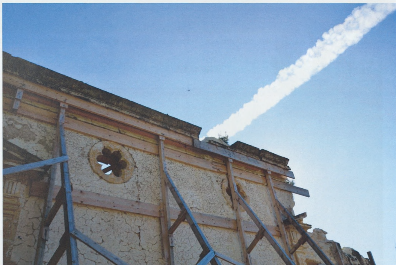
Εικόνα 16, 17: Γενική άποψη του οριζόντιου γείσου της στέψης στη ΒΑ πλευρά του καθολικού. Η μαύρο-γκρίζα κρούστα των βιολογικών επικαθίσεων είναι η χαρακτηριστική φθορά του υλικού, πέρα φυσικά από τις μετατοπίσεις, τις θραύσεις και τις απώλειές του.
