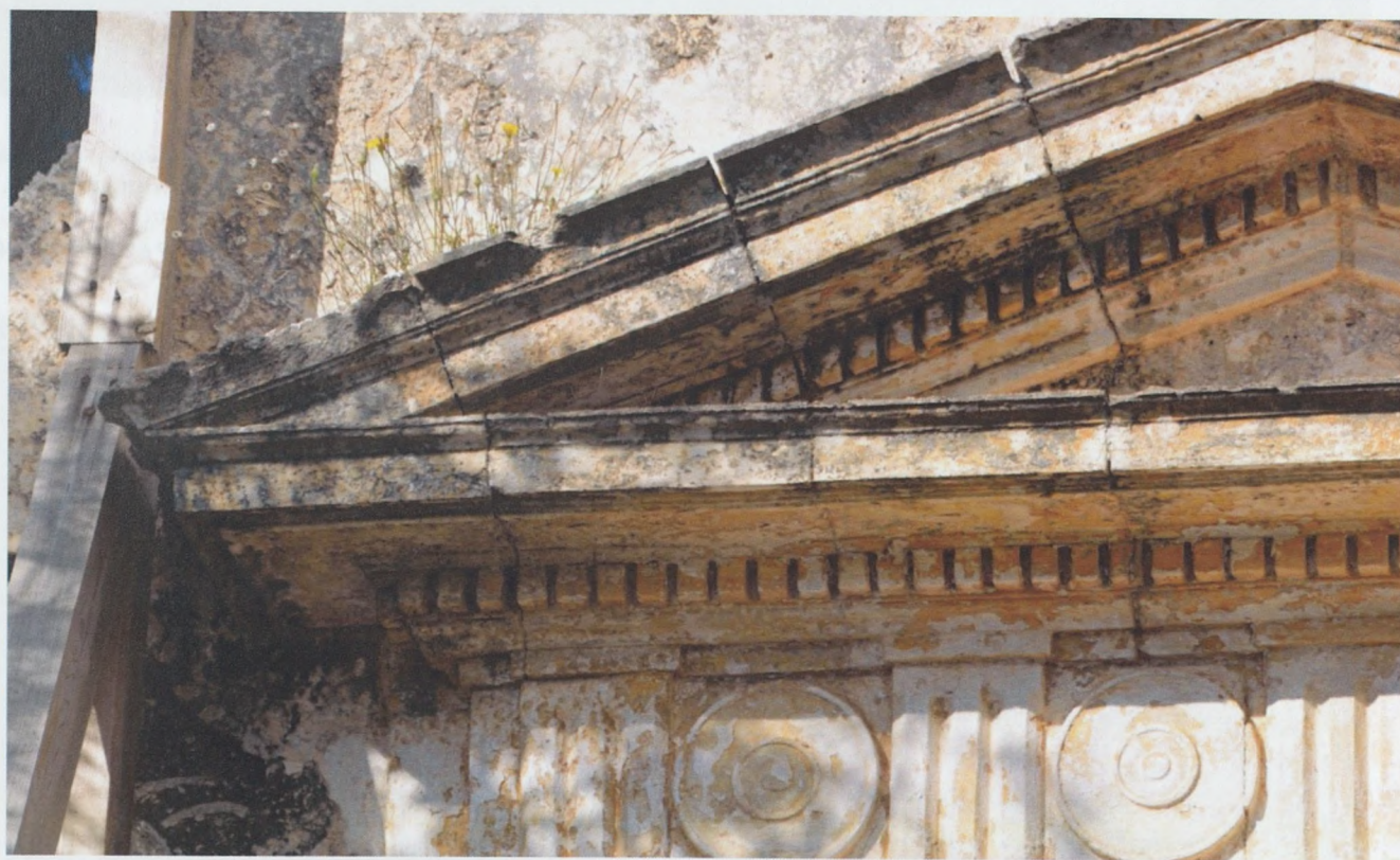
Εικόνα 23: Άνοιγμα Π4 στη ΝΑ πλευρά του καθολικού, λεπτομέρεια από το αέτωμα της στέψης του παράθυρου, πάνω αριστερά. Λίθοι του καταέτιου γείσου και της εναέτιας σίμης, καθώς και λίθοι από το οριζόντιο γείσο, με μαύρη κρούστα σε μεγάλη έκταση, από τη δράση βιολογικών παραγόντων. Οι σκοτεινές περιοχές παρουσιάζουν μεγαλύτερο πληθυσμό τέτοιων οργανισμών.
