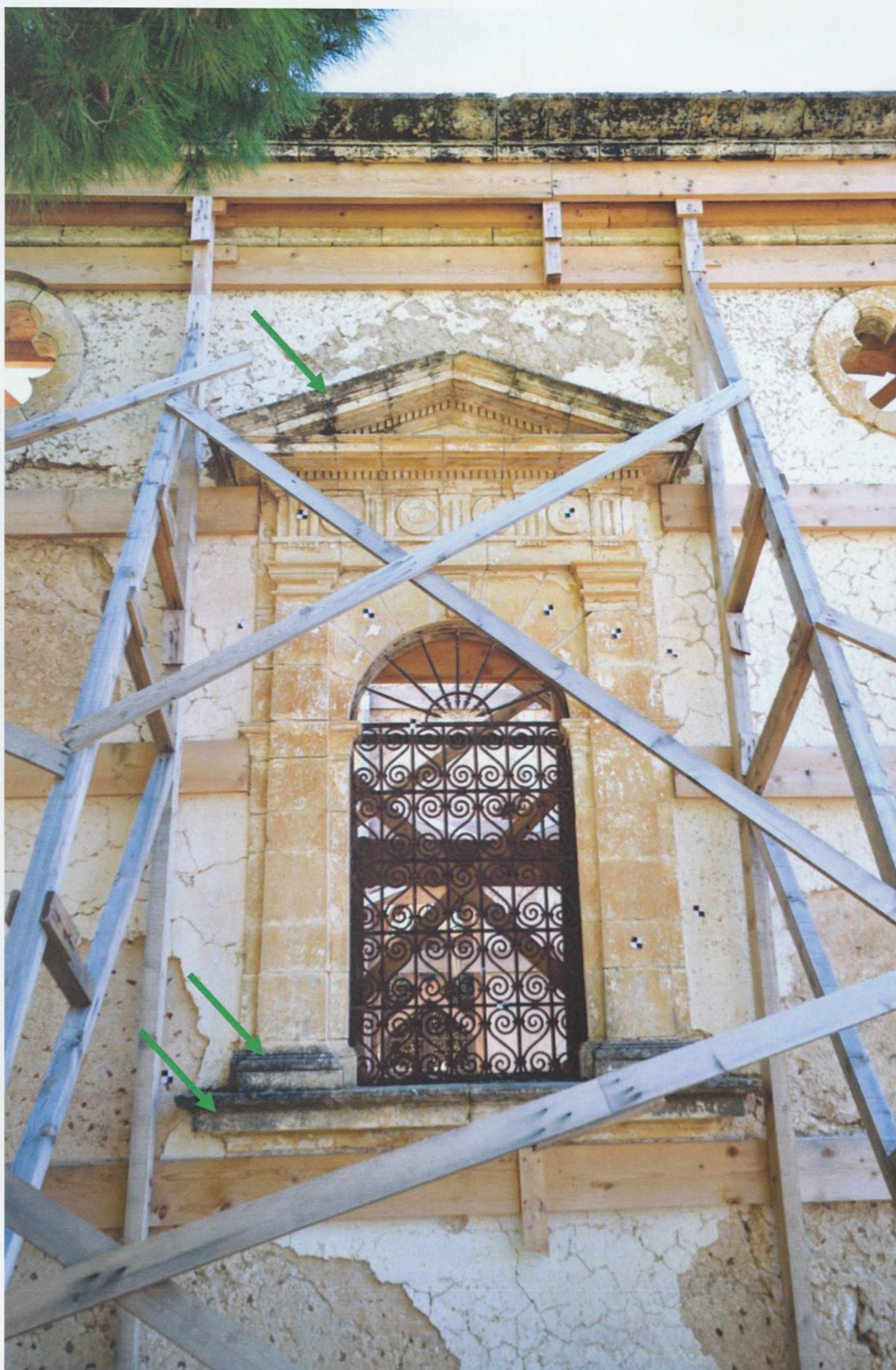
Εικόνα 6: Άνοιγμα Π2, σε καλή κατάσταση σώζεται ολόκληρο το διακοσμητικό περιθύρωμα με το δωρικό θριγκό και το αέτωμα. Περιοχές με μαύρη κρούστα βιολογικών επικαθήσεων στους πωρόλιθους της εναέτιας σίμα και στο οριζόντιο κάτω οριζόντιο γείσο της ποδιάς και στις βάσεις των παραστάδων. Υπολείμματα ασβεστοκονίας στην επιφάνεια των λίθων.
