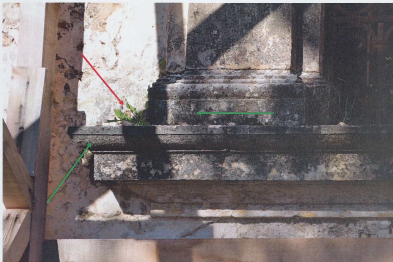
Εικόνα 24 και 25: Άνοιγμα Π4 στη ΝΑ πλευρά του καθολικού, λεπτομέρεια από τη βάση (κρηπίδα) του παραθύρου κάτω δεξιά. Βάση δεξιά παραστάδας και οριζόντιο γείσο με μαύρη κρούστα σε μεγάλη έκταση, από τη δράση βιολογικών παραγόντων. Οι σκοτεινές περιοχές παρουσιάζουν μεγαλύτερο πληθυσμό τέτοιων οργανισμών. Στις σκοτίες των αρμών φύονται άγρια φυτά , τα οποία με το ριζικό τους σύστημα ασκούν μηχανικές πιέσεις στα λίθινα στοιχεία. Κάτω: άγρια βλάστηση δίπλα στο λαμπά της θύρας Θ2.
