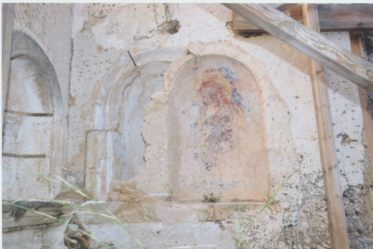
Εικόνα 45, 46: Πάνω: η κόγχη στον ΒΑ τοίχο του καθολικού, σε καλή κατάσταση οι λίθοι του θυρώματος. Διακρίνεται αλλοίωση της αρχικής επιφάνειας από τη δράση των βιολογικών παραγόντων. Κάτω: Η κόγχη και η ψευδοκόγχη στον Ανατολικό τοίχο του ιερού. Διάνοιξη αρμού και κάλυψη των λίθων του θυρώματος με επίχρισμα.
