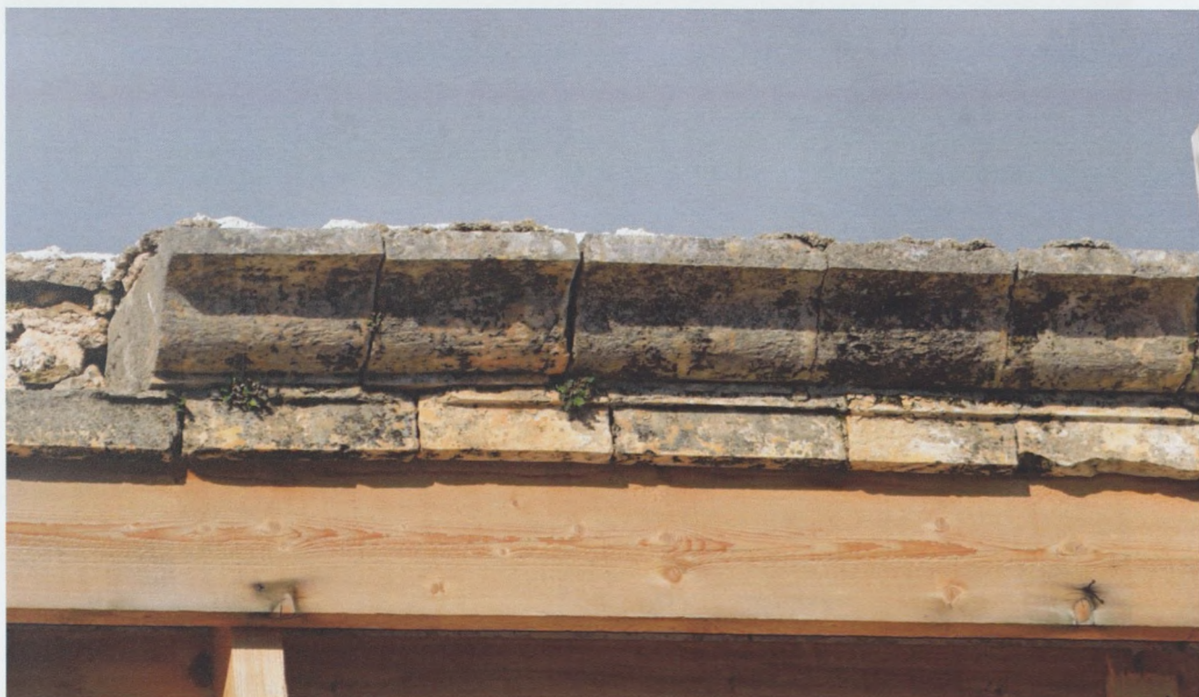
Εικόνα 41, 42: Οριζόντιο γείσο στέγης, ΝΑ πλευρά. Όπως και στις φωτογραφίες 39, 40.
