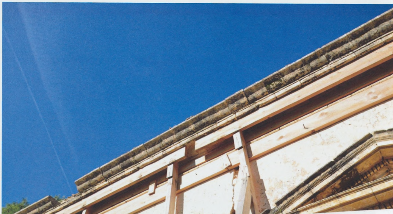
Εικόνα 37, 38: Το οριζόντιο γείσο της στέγης στη ΝΑ πλευρά του καθολικού – γενικές απόψεις. Πάνω: λεπτομέρεια από την απώλεια υλικού από σεισμικές δονήσεις. Κάτω: εμφανείς οι γκρίζες κρούστες από τη δράση των βιολογικών παραγόντων.
