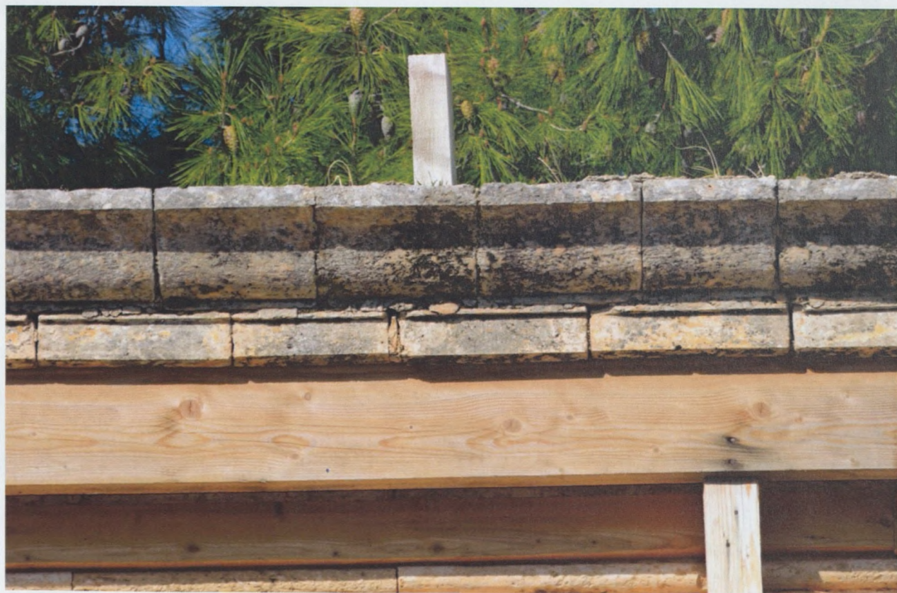
Εικόνα 39, 40: Πάνω γενική άποψη του γείσου. Κάτω: λεπτομέρεια από τους περίτεχνους δόμους που απαρτίζουν το γείσο, έντονη παρουσία κρούστας βιολογικών παραγόντων.
