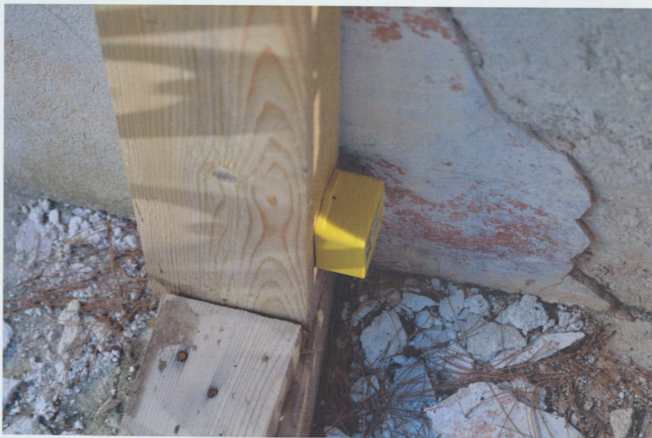
Εικόνα 58: Το σημείο τοποθέτησης του καταγραφικού (Data Logger) in situ στο μνημείο (άνοιγμα Π5).
