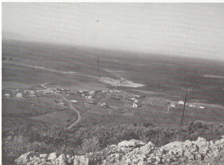
Κύθηρα: Διακόφτι - Μακροκύθηρα: η επιχωμάτωση του «διαποριού».
