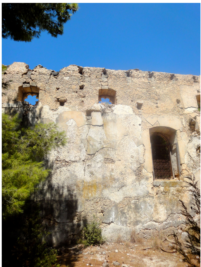
Άποψη βορείου τοίχου (εσωτερικό)
