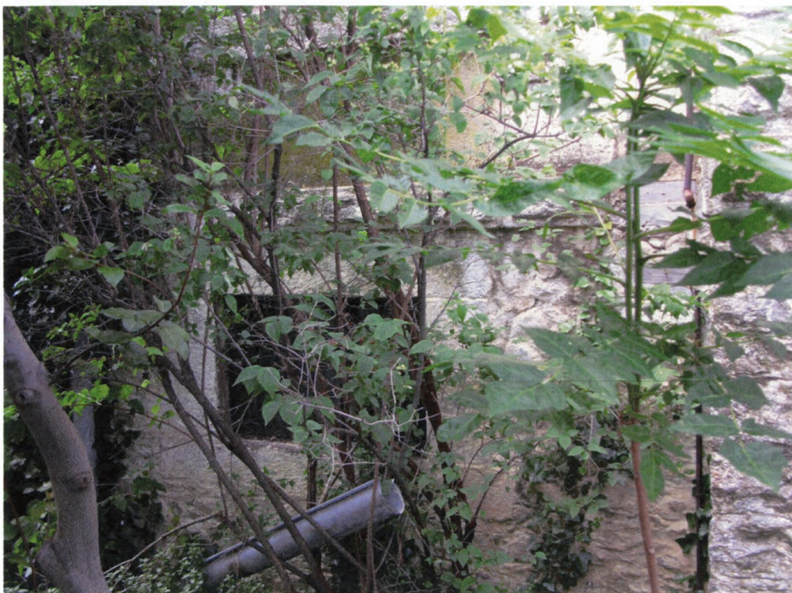
41. ΕΞΩΤΕΡΙΚΗ ΤΟΙΧΟΠΟΙΙΑ ΥΠΟΓΕΙΟΥ
