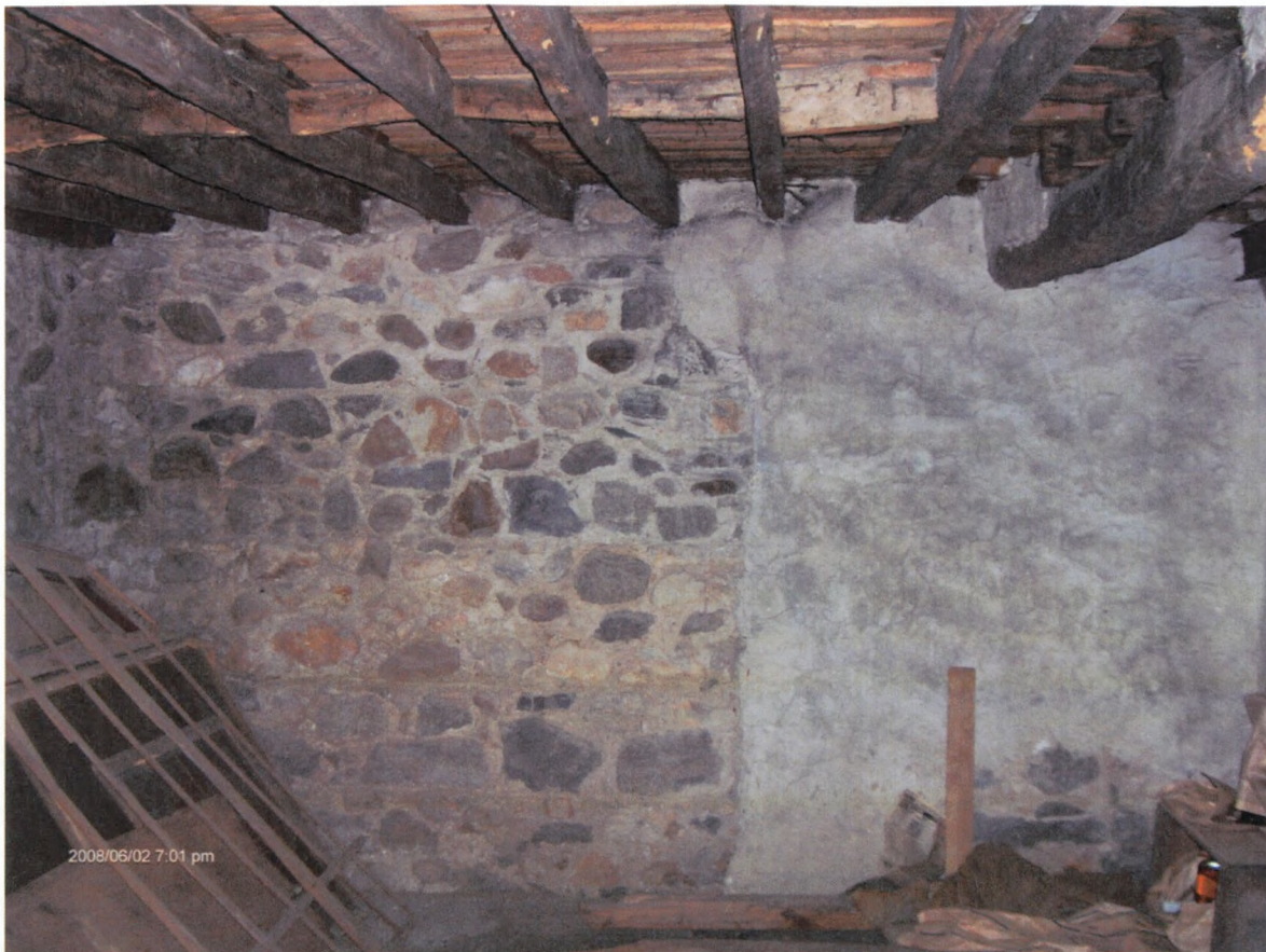
45. ΕΣΩΤΕΡΙΚΗ ΑΠΟΨΗ ΥΠΟΓΕΙΟΥ 3
