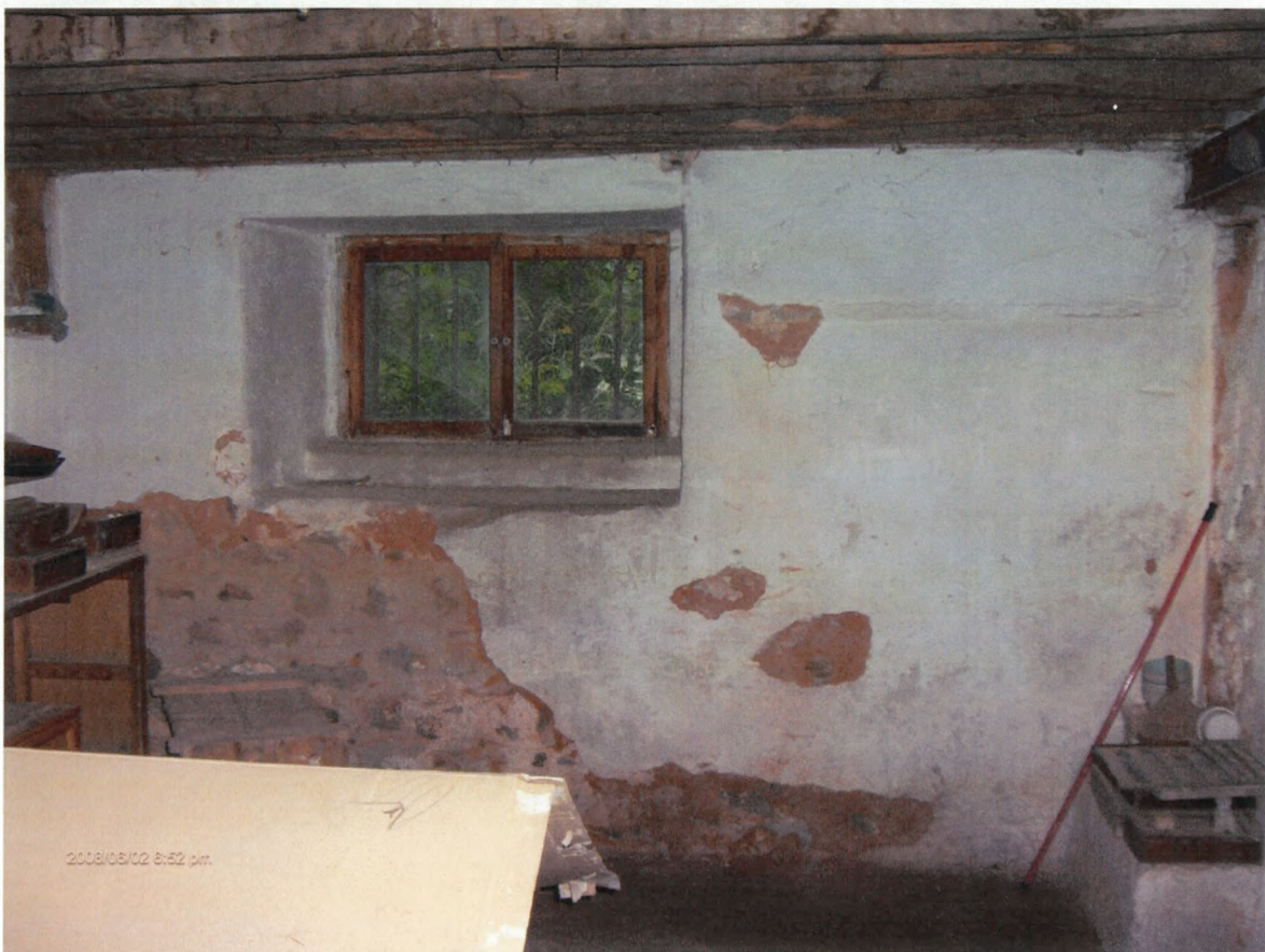
46. ΕΣΩΤΕΡΙΚΗ ΑΠΟΨΗ ΥΠΟΓΕΙΟ
