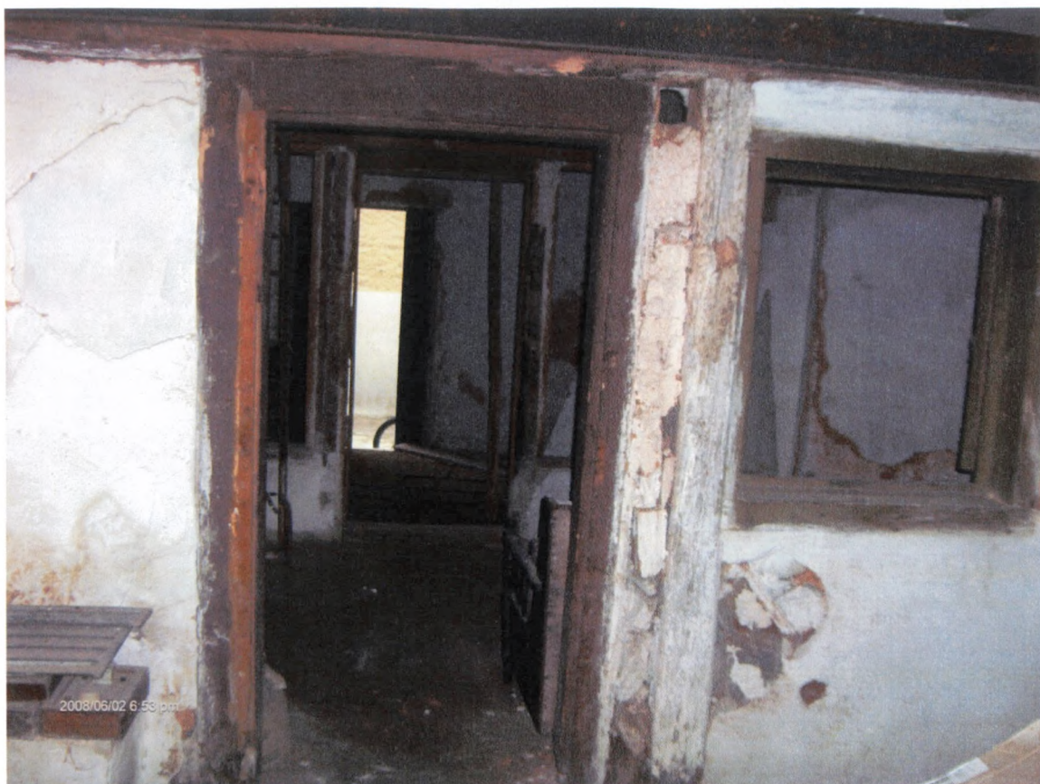
43. ΕΣΩΤΕΡΙΚΗ ΑΠΟΨΗ ΥΠΟΓΕΙΟΥ
