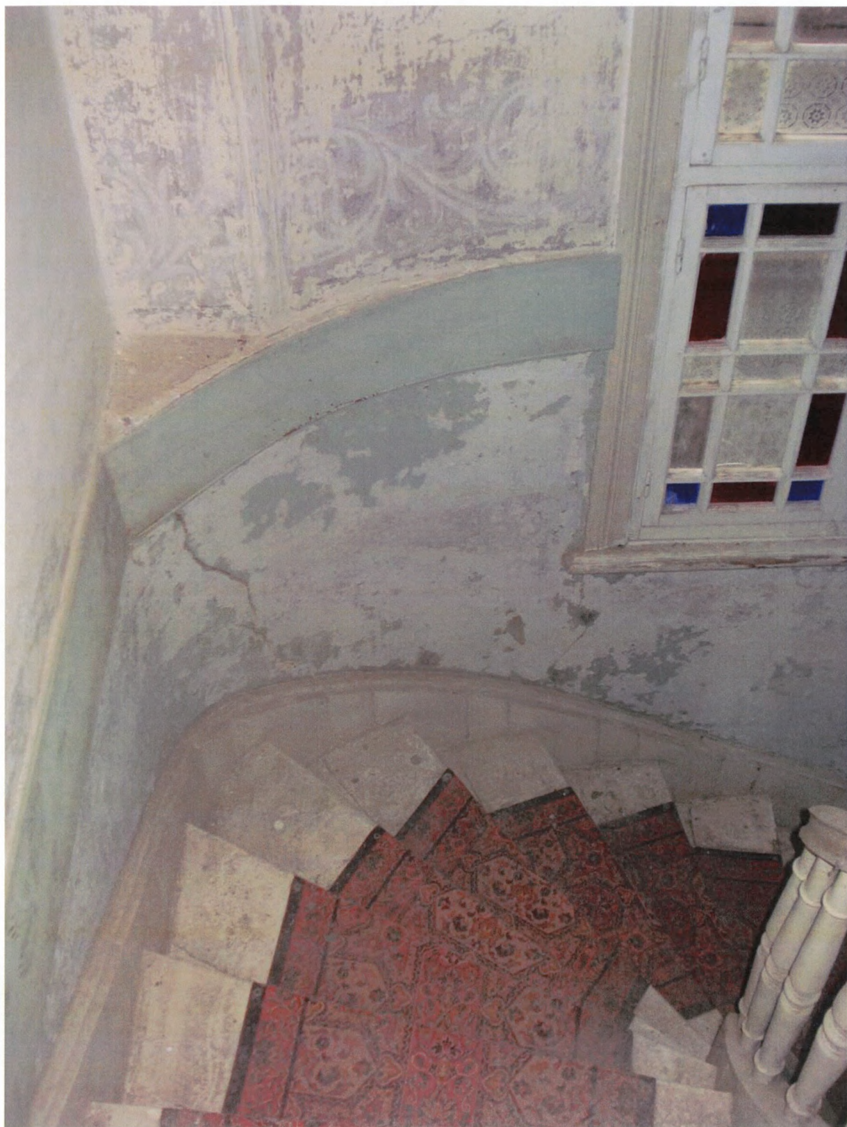
35. ΑΠΟΨΗ ΚΛΙΜΑΚΟΣΤΑΣΙΟΥ ΑΠΟ ΤΟΝ ΟΡΟΦΟ
