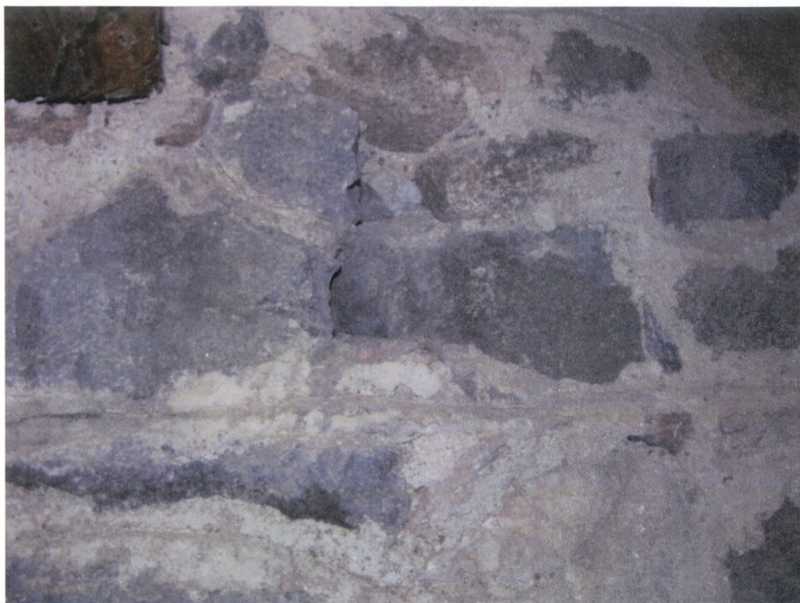
12. ΦΕΡΟΥΣΑ ΤΟΙΧΟΠΟΙΑ ΛΙΘΟΔΟΜΗΣ (γρανίτης και συνδετικό ασβεστοκονίαμα).
