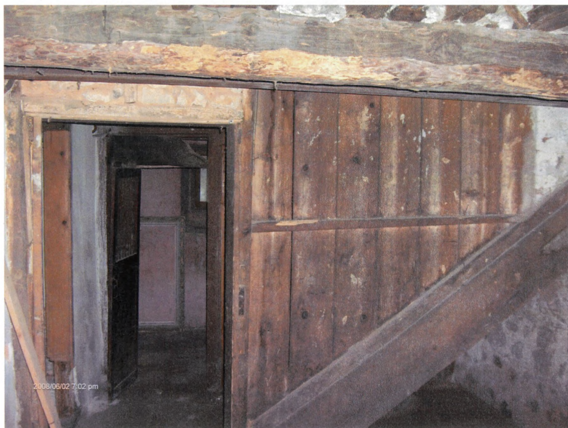
44. ΕΣΩΤΕΡΙΚΗ ΑΠΟΨΗ ΥΠΟΓΕΙΟΥ 2
