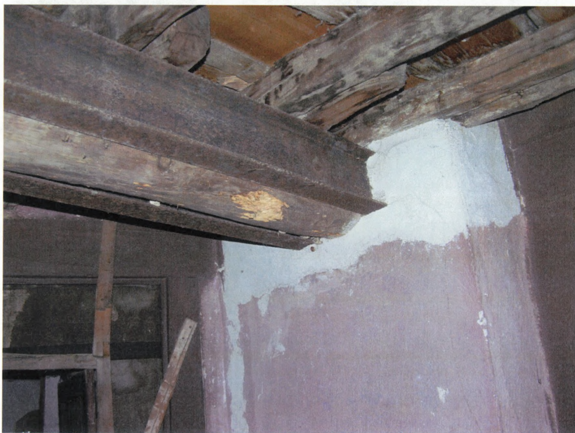
49. ΕΝΙΣΧΥΣΗ ΔΟΚΟΥ ΜΕ ΑΜΦΙΠΛΕΥΡΟΥΣ ΣΙΔΗΡΟΔΟΚΟΥΣ
