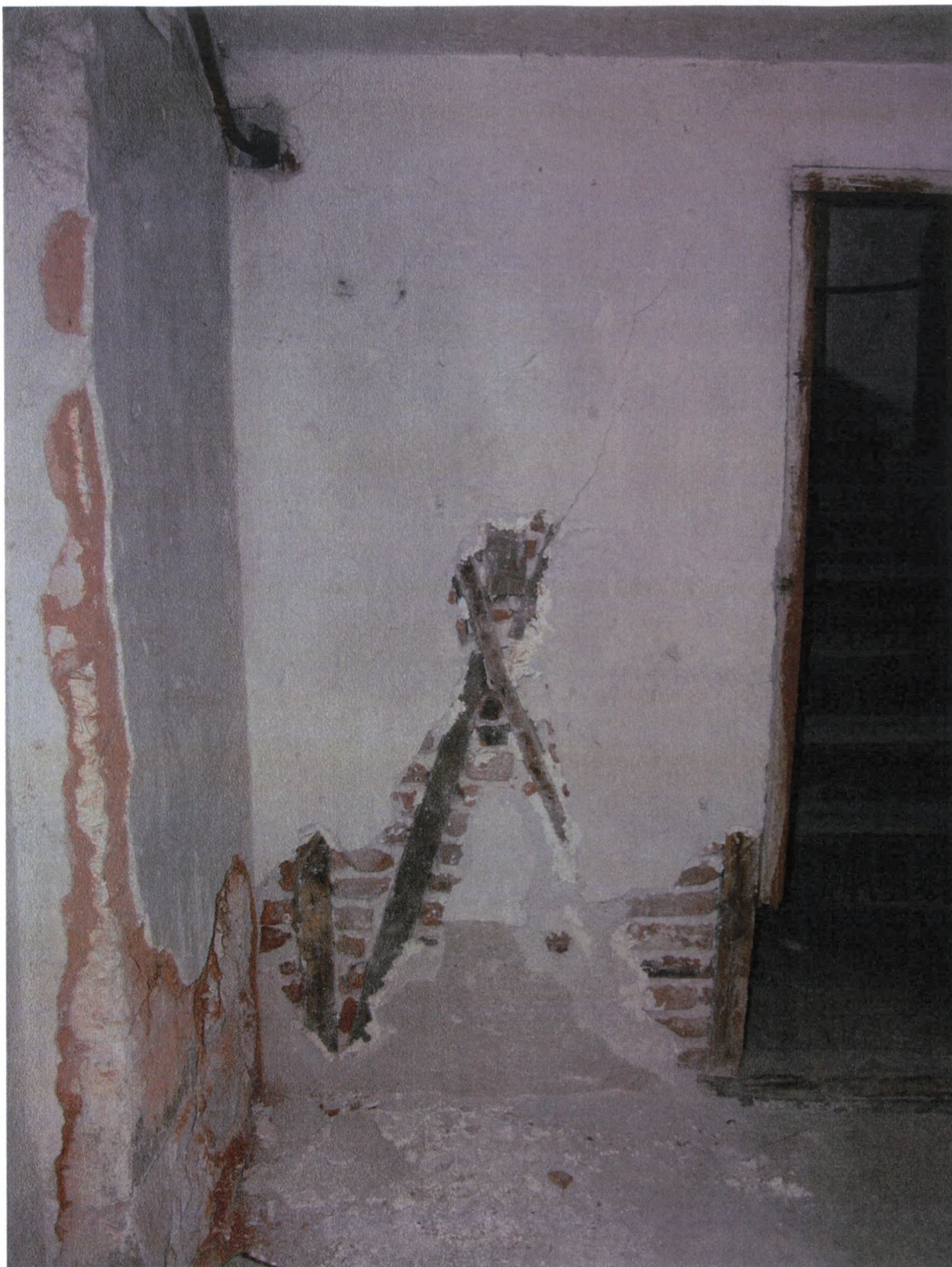
47. ΞΥΛΟΠΙΚΤΗ ΤΟΙΧΟΠΟΙΙΑ ΥΠΟΓΕΙΟΥ
