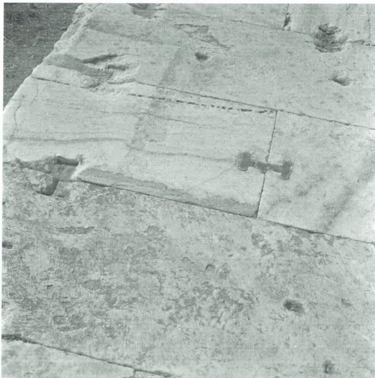
εικ. 72 β . Τμήματα της κρηπίδας με μεταλλικούς συνδέσμους, φωτογραφία από εποχή της ανασκαφής
