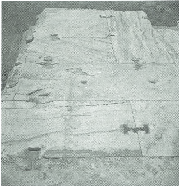
εικ. 71 α . Τμήματα της κρηπίδας με μεταλλικούς συνδέσμους, φωτογραφία από εποχή της ανασκαφής
