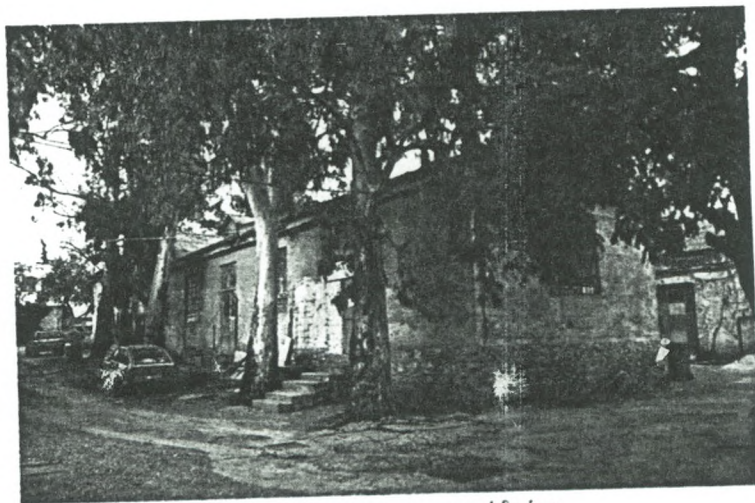
Άποψη κτιρίων από δυτικά με όψη στον εσωτερικό δρόμο.
