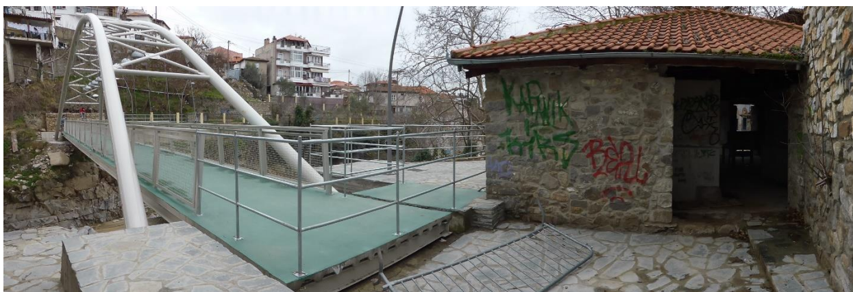
Φ2. (2016) Η μεταλλική πεζογέφυρα κάλυψε τμήμα του οικοπέδου (II) και απέκλεισε την εξωτερική πρόσβαση στην πίσω είσοδο του ισόγειου κτίσματος του Νερόμυλου.
