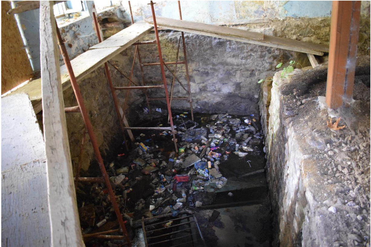
Φ73. (2021) Η κολώνα στο μέσον του κτίσματος τοποθετήθηκε μεταγενέστερα, για την υποστήριξη της στέγης.
