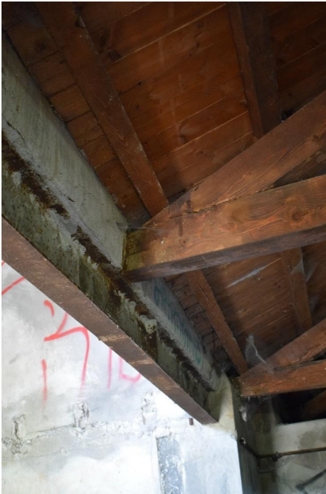
Φ28. Η μεταλλική δοκός χρειάζεται επιπλέον και ενδιάμεση υποστήριξη.
