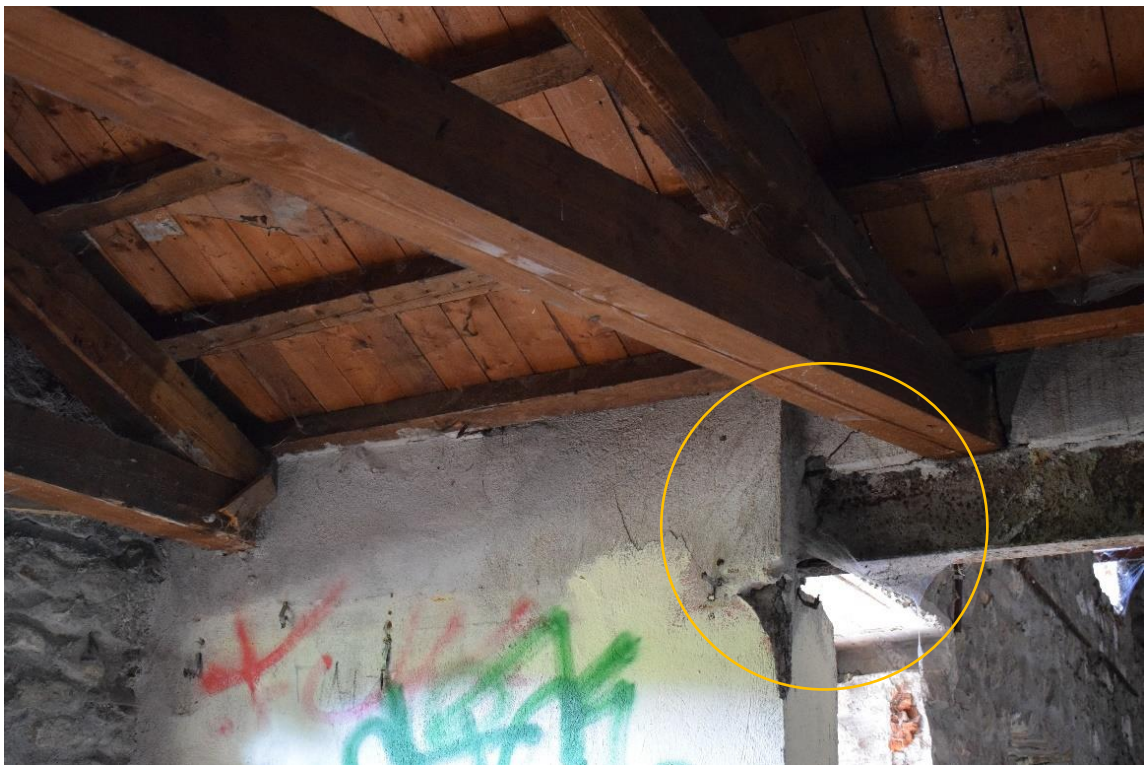
Φ27. Η έδραση της μεταλλικής δοκού, στην ένωση των δύο κτισμάτων, όπου χρειάζεται στατική ενίσχυση.
