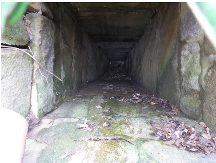
Φ56. (2016) Ο υδραγωγός και ο πλαστικός σωλήνας μεταφοράς του νερού.
