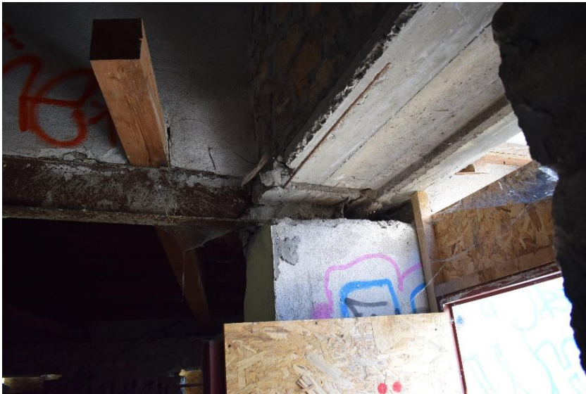
Φ35. Θέσεις αποσπασμένων ξύλινων πρεκιών που θέλουν αποκατάσταση.
