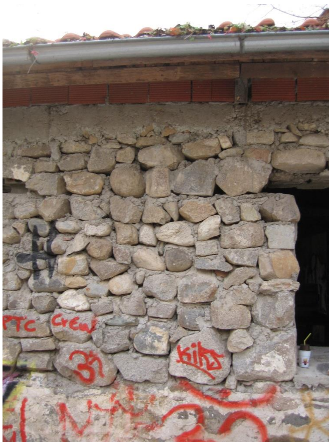
Φ31. Στέψη της τοιχοποιίας της ανατολικής πλευράς, με εμφανείς κακοτεχνίες.
