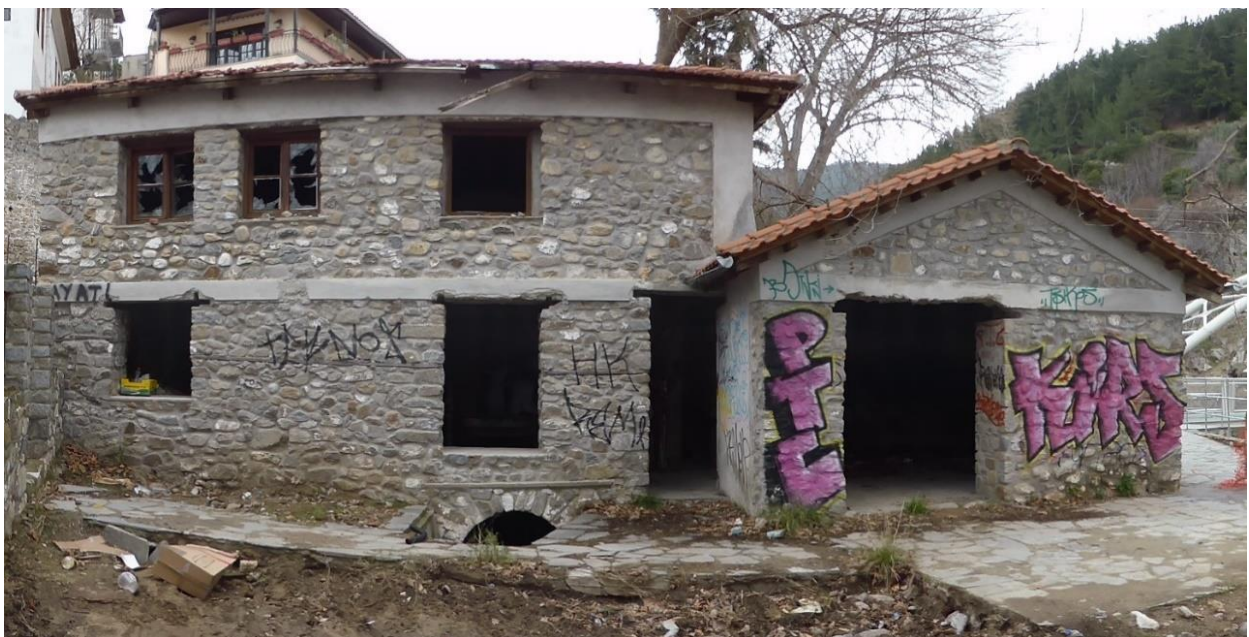
Φ40. (2016) Η πρόσοψη του ληλατημένου Νερόμυλου, ένα χρόνο μετά την κατασκευή της μεταλλικής πεζογέφυρας.
