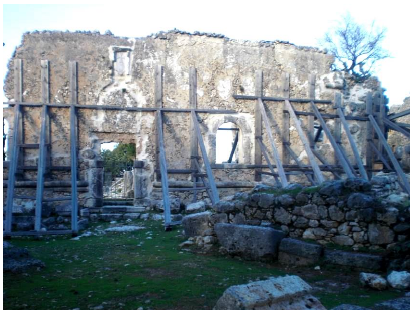
Εικ. 2. Καθολικό Μονής – Νότιος όψη
