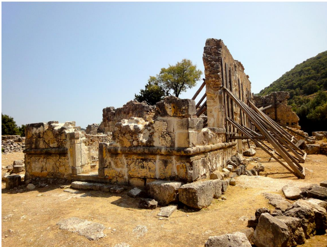
Εικ. 4. Καθολικό Μονής – Δυτική και Νότια όψη.
