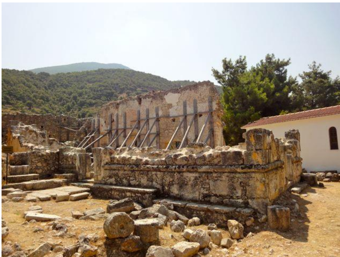
Εικ. 5. Καθολικό Μονής – Βόρεια και Δυτική όψη. Διακρίνεται, επίσης, υποστυλωμένη η εσωτερική πλευρά του Νοτίου τοίχου, καθώς και η μετασεισμική εκκλησία του Αγίου Νικολάου.
