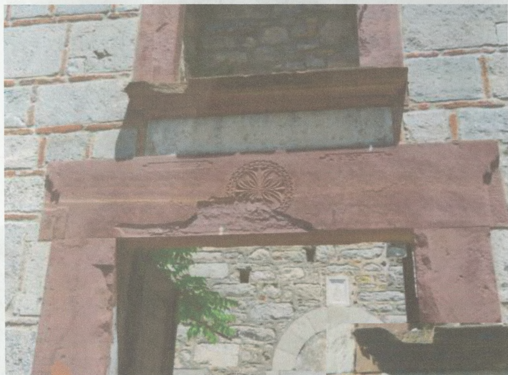
Εικ. 32. Πρότυλο. Ο ερυθρός λίθος των Θυμιανών παρουσιάζει φαινόμενα αποφλοιώσεων με κίνδυνο περαιτέρω βλαβών.
