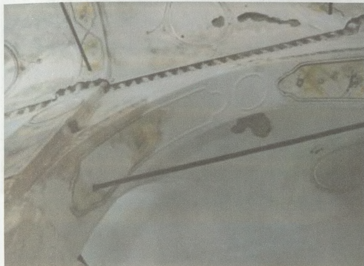
Εικ.30 α,β, Η υγρασία προκαλεί εκτεταμένες φθορές στο εσωτερικό του ναού με αποτέλεσμα να καταστρέφονται τα επιχρίσματα και οι τοιχογραφίες.
