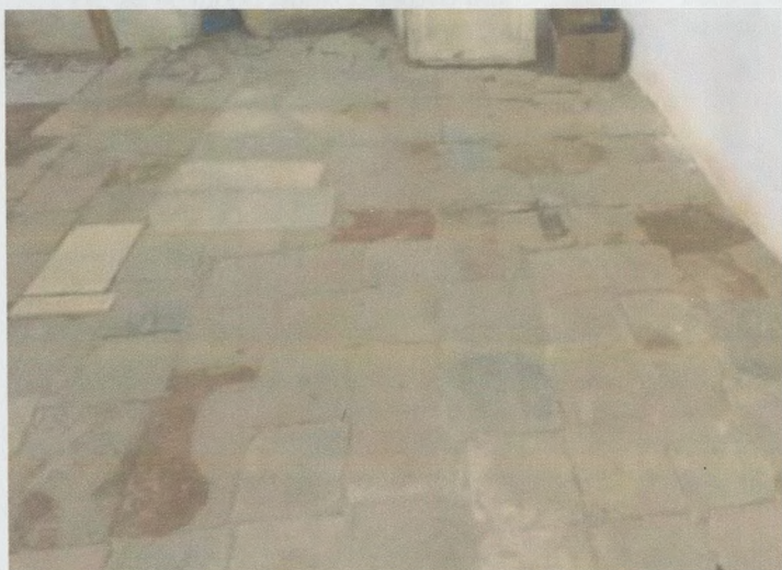
Εικ.24, Τετράγωνες κεραμικές πλάκες εναλλάσσονται με λίθινες στο δάπεδο του βόρειου κλίτους.
