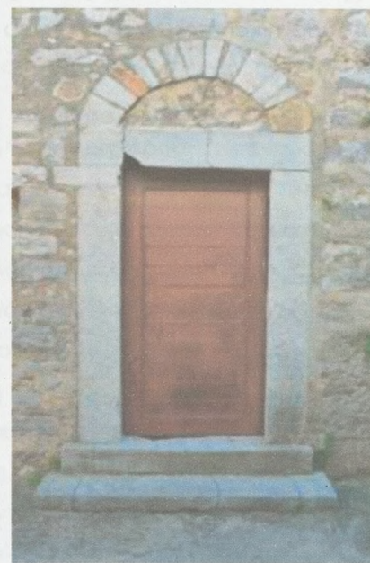
Εικ. 7, Τα πλαίσια των θυρών αποτελούνται και αυτά από ολόσωμα ορθογωνισμένα τεμάχια λίθων
