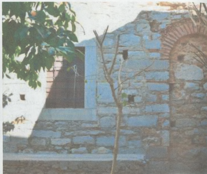
Εικ.23, Ν. όψη. Η τοιχοποιία της Α' φάσης στο αν. τμήμα είναι κατασκευασμένη κατά το περίκλειστο σύστημα, ενώ στο δυτικό τμήμα οι οπτόπλινθοι συναντώνται σποραδικά.
