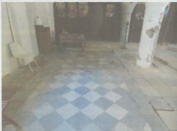
Εικ. 14 α,β, Το δάπεδο καλύπτεται με λίθινες τετράγωνες πλάκες, που είναι τοποθετημένες σε διάχωρα αλλά και σύγχρονες προσθήκες στις περιοχές που παλαιότερα καλύπτονταν με στασίδια.
