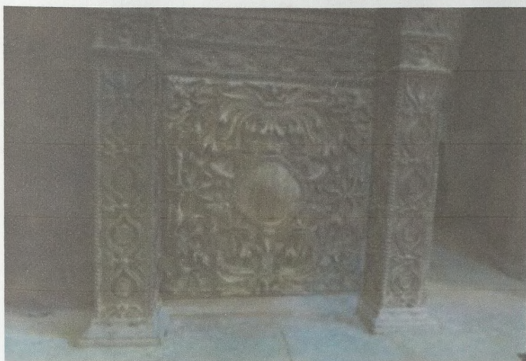
Εικ. 41, 42, Στο τέμπλο και τις εικόνες του δωδεκαόρτου παρατηρούνται οπές από ξυλοφάγα έντομα.
