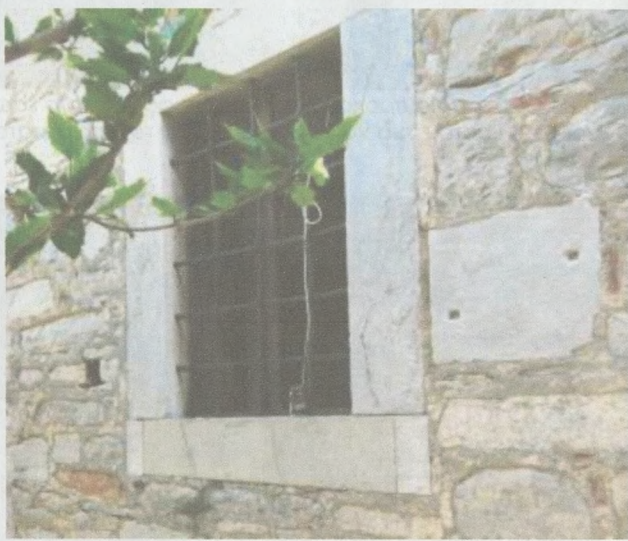
Εικ. 37, Στα ανοίγματα του Ν. τοίχου παρατηρείται παραμόρφωση στα κιγκλιδώματα
