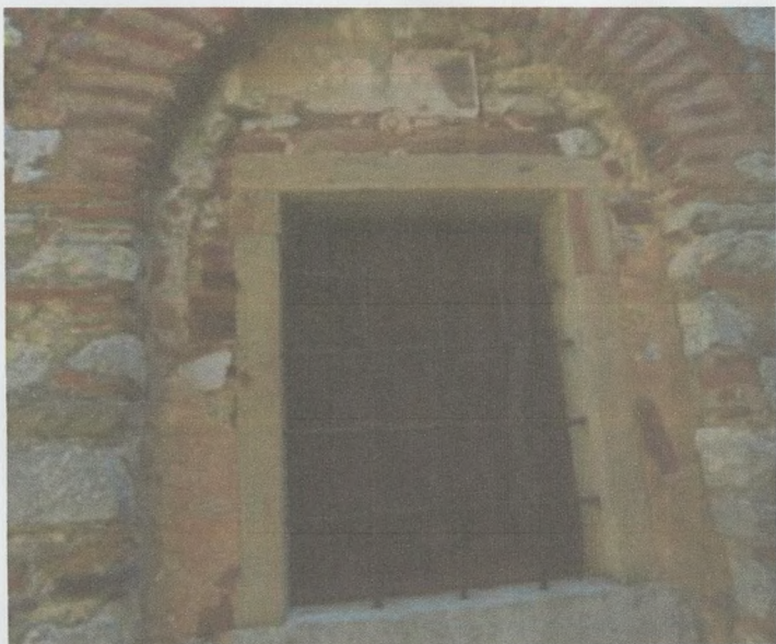
Εικ.22.Ν.όψη Το πλαίσιο στο παράθυρο είναι κατασκευασμένο από ψαμμίτη και ασβεστόλιθο μόνο στο κάτω μέρος.
