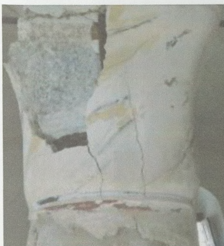
Εικ. 11. Οι κίονες και τα κιονόκρανα κοσμούνται με γραπτή απομίμηση ορθομαρμάρωσης.
