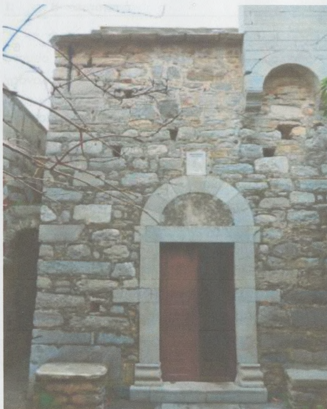
Εικ. 3, Η επέκταση του ναού (Β' φάση) είναι κατασκευασμένη από ανεπίχριστη αργολιθοδομή.
