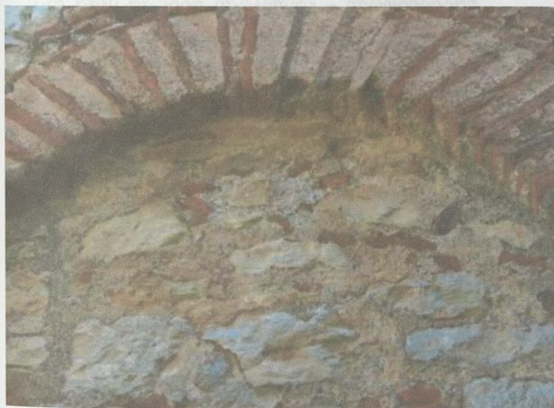
Εικ.29, Στα αψιδώματα της Νόπας όψης εντοπίζεται οστρακο-κονίαμα, κουρασάνι
