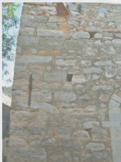
Εικ.5, Η αργολιθοδομή περιλαμβάνει λίθους που είναι λαξευμένοι στα πρόσωπα.
