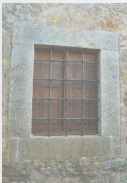
Εικ. 6, Τα πλαίσια των ανοιγμάτων διαμορφώνονται από ολόσωμα τεμάχια καλοδουλεμένων ασβεστόλιθων.
