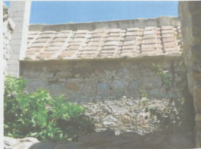
Εικ.25, Πλακοειδείς κέραμοι καλύπτουν τη στέγη στο νότιο κλίτος.
