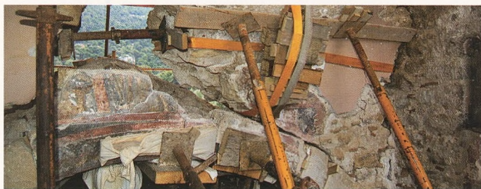
Στήριξη καμάρας κατά την αποκατάσταση
