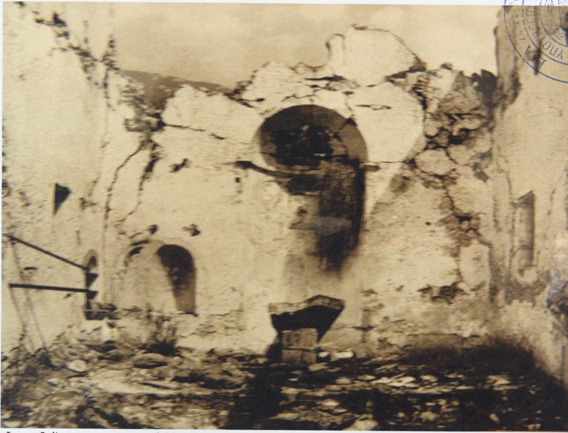
Φωτ. 5. Αποψη εσωτερικό Ναού μετά τον καταστροφικό σεισμό του 1953
