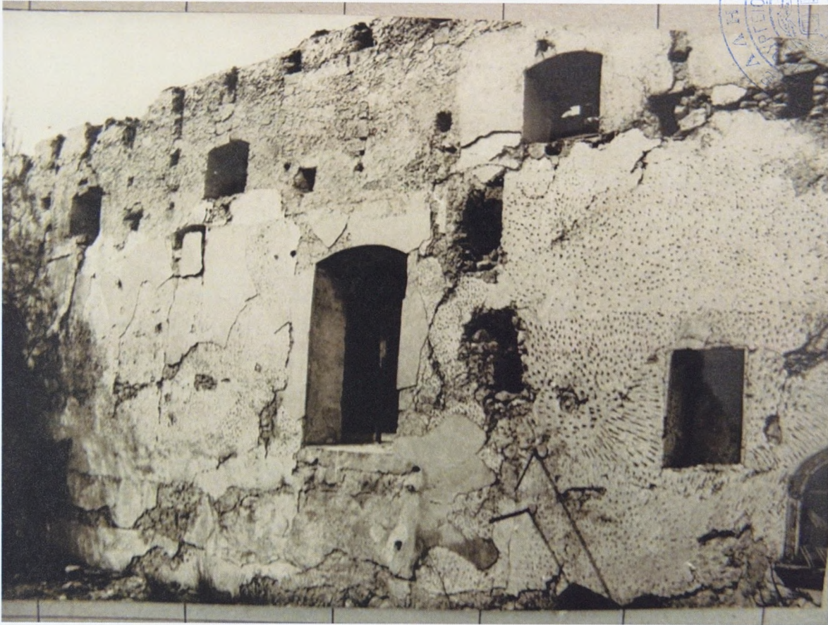
Φωτ. 5. Άποψη εσωτερικού ΒΔ τοίχου, μετά τον καταστροφικό σεισμό του 1953
