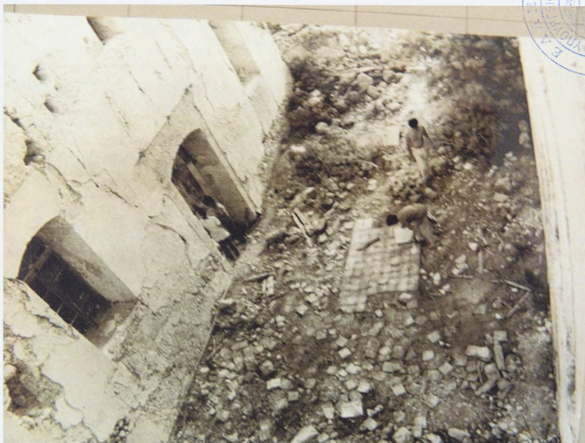
Φωτ. 5. Άποψη εσωτερικό Ναού μετά τον καταστροφικό σεισμό του 1953
