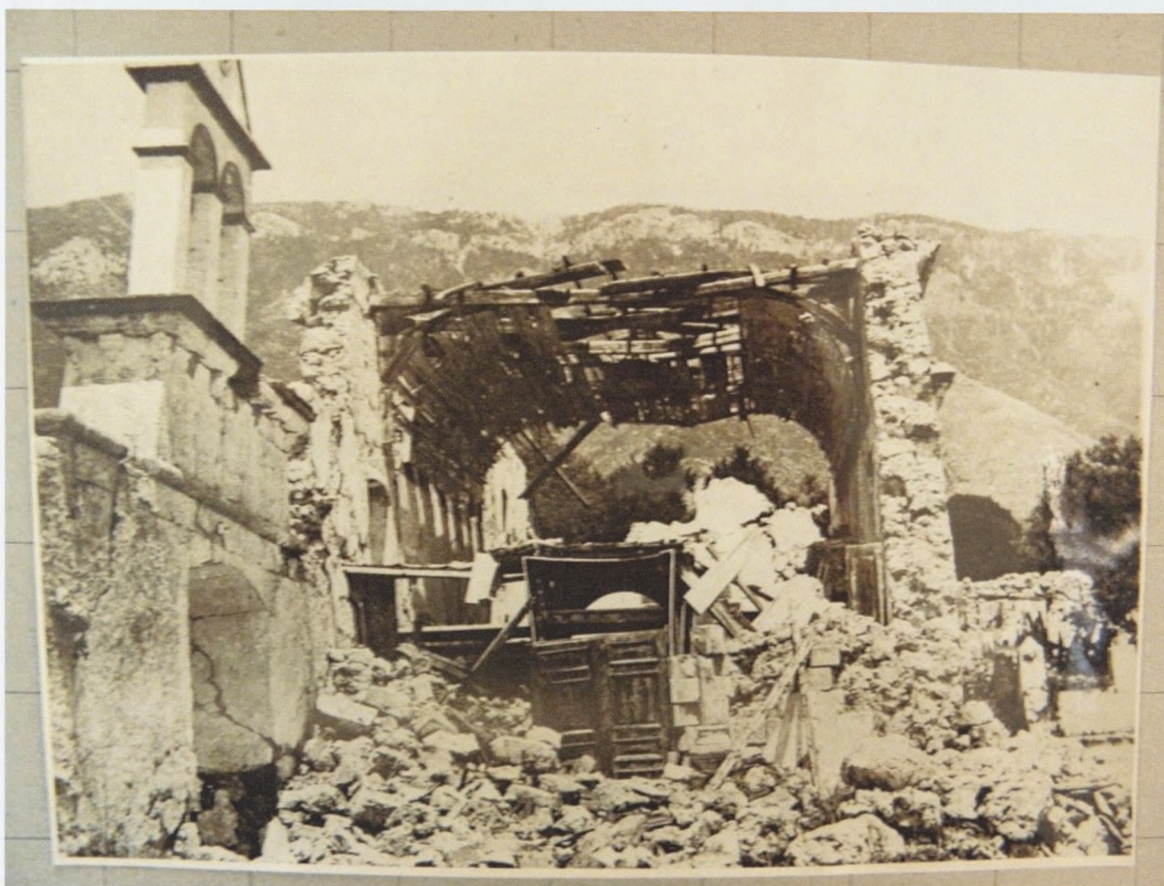
Φωτ. 3. Άποψη του Καθολικού μετά τον καταστροφικό σεισμό του 1953
