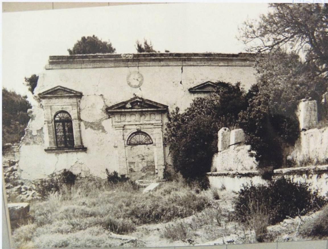
Φωτ. 4. ΝΑ όψη μετά τον καταστροφικό σεισμό του 1953
