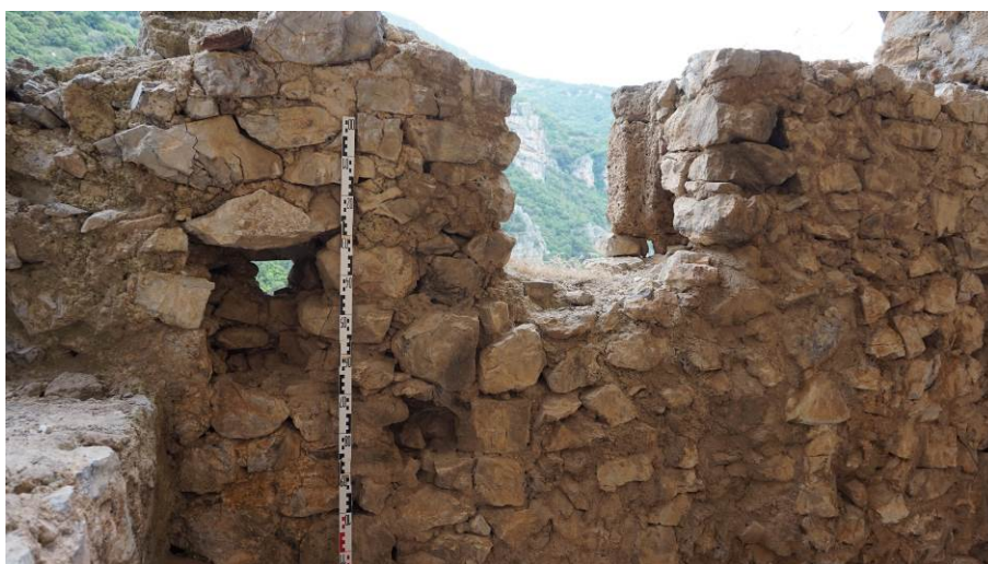
Εικ. 2.3: Τρόπος δόμησης των τοιχοποιιών του ναού
