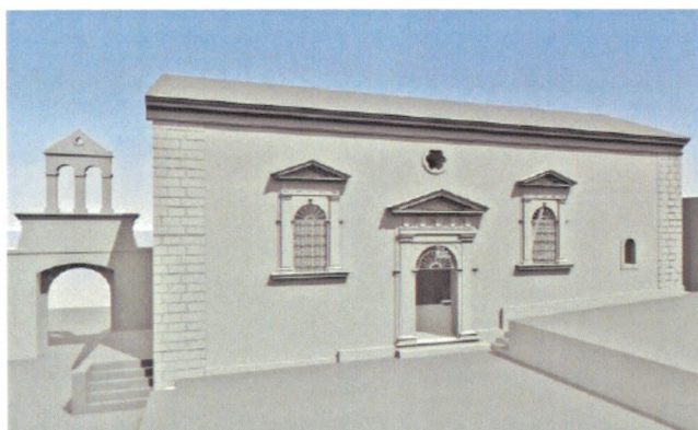
Εικ. 37. Η νοτιοανατολική όψη του καθολικού με ισόδομη λαξευτή τοιχοποιία στα άκρα.
