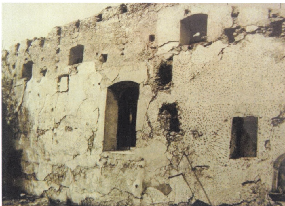
Εικ. 6. Εσωτερική παρειά του βορειοδυτικού τοίχου.
