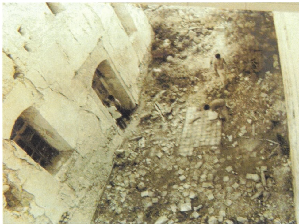
Εικ. 9. Το δάπεδο του ναού χωρίς την πέτρινη βαθμίδα των στασιδιών από Ανατολικά.
