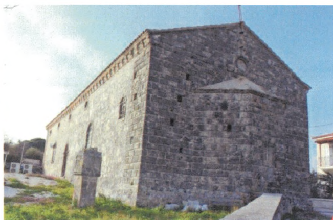
Εικ. 36 Λαξευτή τοιχοποιία στην πρόσοψη και στην πλάγια όψη του ναού της Ευαγγελίστριας στο Κάστρο.
