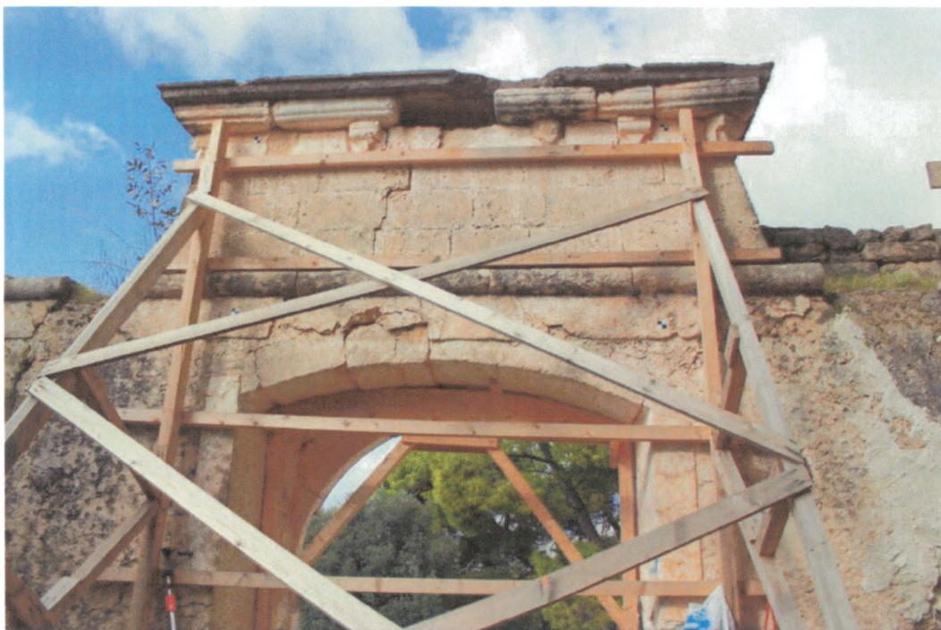
74. ΕΣΩΤΕΡΙΚΗ ΠΛΕΥΡΑ ΕΙΣΟΔΟΥ – ΚΩΔΩΝΟΣΤΑΣΙΟΥ.
