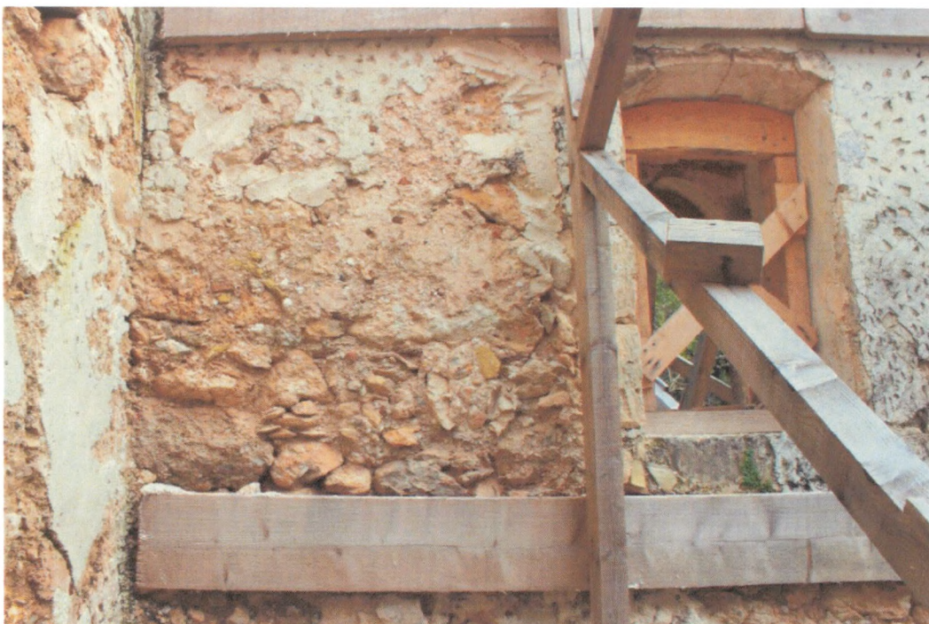
53. ΑΡΓΟΛΙΘΟΔΟΜΗ ΣΤΟΝ ΝΑ ΤΟΙΧΟ
