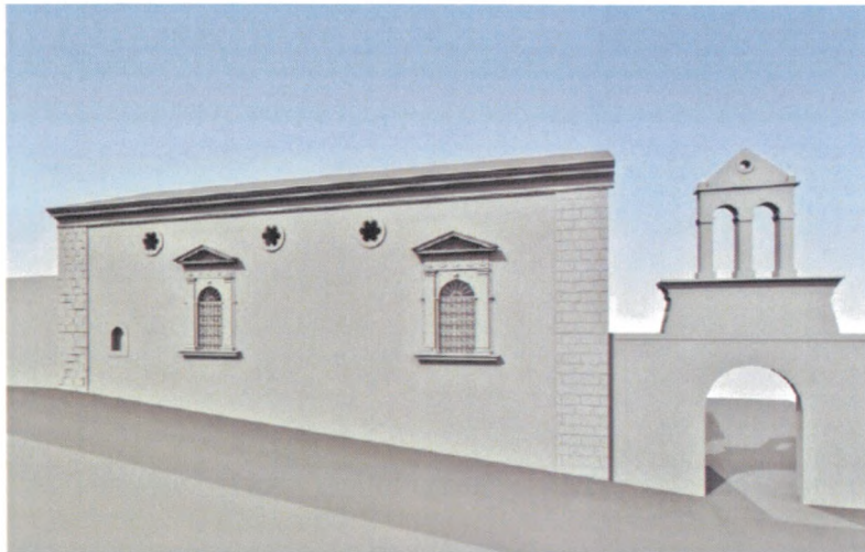
Εικ. 35. Γραφική αποκατάσταση της βορειοδυτικής όψης της βασιλικής. Αναπαρίσταται η ισόδομη λαξευτή τοιχοποιία που αποτελεί συνέχεια της λαξευτής τοιχοποιίας της κατεστραμμένης σήμερα νοτιοδυτικής πρόσοψης προς το προαύλιο της εκκλησίας. Στα αριστερά αναπαρίσταται η ισόδομη λαξευτή τοιχοποιία σε συνέχεια της βορειοανατολικής όψης του ιερού.
