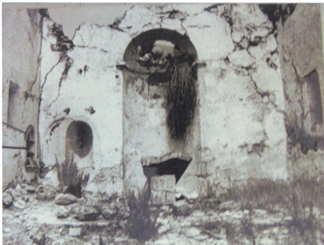
Εικ. 4. Αποψή του ιερού μετά τον σεισμό του 1953.
