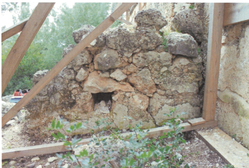
54. ΑΡΓΟΛΙΘΟΔΟΜΗ ΣΤΗΝ ΕΣΩΤΕΡΙΚΗ ΠΑΡΕΙΑ ΤΟΥ ΝΑ ΤΟΙΧΟΥ.
