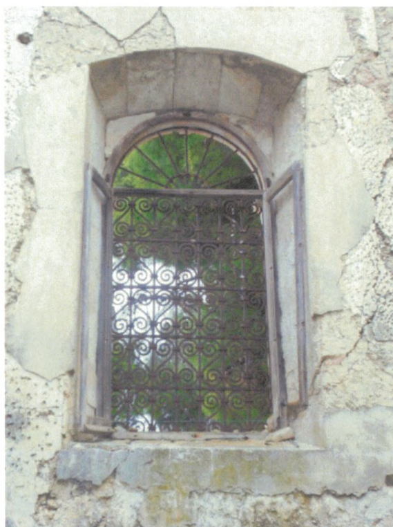
18. ΠΑΡΑΘΥΡΟ Π2 - ΕΣΩΤΕΡΙΚΗ ΟΨΗ (ΕΛΛΕΤ) ΚΑΙ ΕΞΩΤΕΡΙΚΗ ΟΨΗ (2014).
