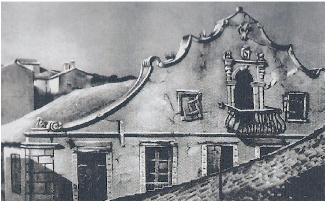
ΦΩΤΟ 1.6.1 ΟΙΚΙΑ ΚΟΝΤΕ ΤΖΩΡΤΖΗ ΑΝΝΙΝΟΥ. ΛΙΘΟΣΤΡΩΤΟ ΑΡΓΟΣΤΟΛΙΟΥ.
