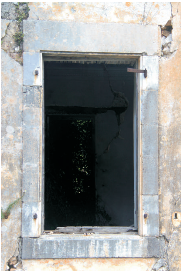
ΦΩΤΟ 3.6.5.1 ΑΝΟΙΓΜΑ ΟΡΟΦΟΥ.
