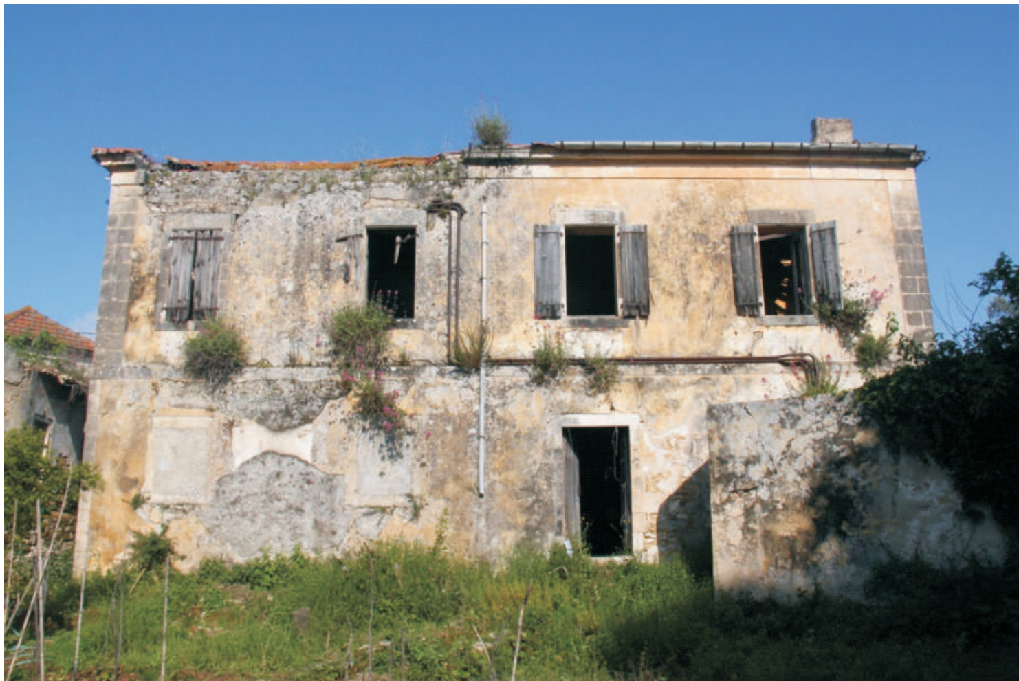
ΦΩΤΟ 2.1.4 ΑΝΑΤΟΛΙΚΗ ΟΨΗ.
