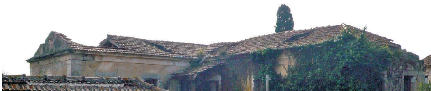
ΦΩΤΟ 2.1.2 ΒΟΡΕΙΟΔΥΤΙΚΗ ΓΩΝΙΑ ΤΟΥ ΚΤΙΡΙΟΥ.
