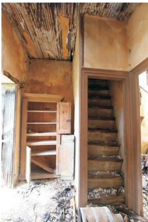
ΦΩΤΟ 3.6.8.2 ΑΠΟΤΟΜΗ ΞΥΛΙΝΗ ΚΛΙΜΑΚΑ ΠΟΥ ΟΔΗΓΕΙ ΣΤΗ ΣΟΦΙΤΑ.
