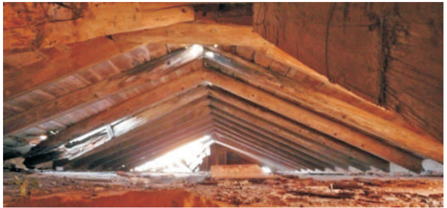
ΦΩΤΟ 2.3.5 ΤΕΤΡΑΡΙΧΤΗ ΣΤΕΓΗ ΣΤΗΝ ΜΑΚΡΙΑ ΠΛΕΥΡΑ ΤΟΥ ΚΤΙΡΙΟΥ.
