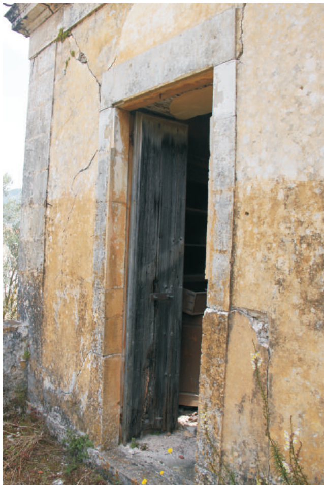
ΦΩΤΟ 2.5.5 ΠΑΡΑΘΥΡΟ ΠΟΥ ΜΕΤΑΤΡΑΠΗΚΕ ΣΕ ΘΥΡΑ.
