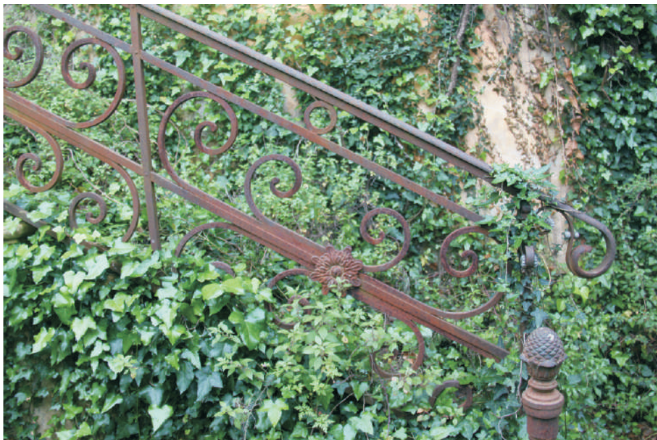
ΦΩΤΟ 3.6.9.2 ΜΕΤΑΛΛΙΚΟ ΣΤΗΘΑΙΟ ΣΚΑΛΑΣ.
