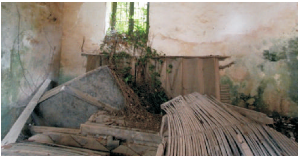
ΦΩΤΟ 2.5.3 ΥΠΟΛΕΙΜΜΑΤΑ ΞΥΛΙΝΗΣ ΣΚΑΛΑΣ ΣΤΟ ΚΑΤΩΪ.
