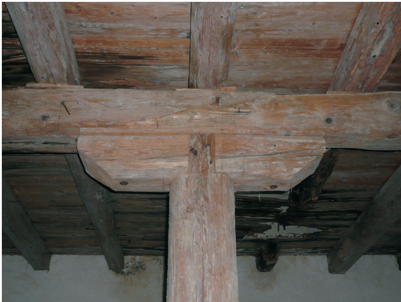
ΦΩΤΟ 3.6.3.1 ΞΥΛΙΝΟ ΔΑΠΕΔΟ ΣΤΟ ΚΑΤΩΪ.
