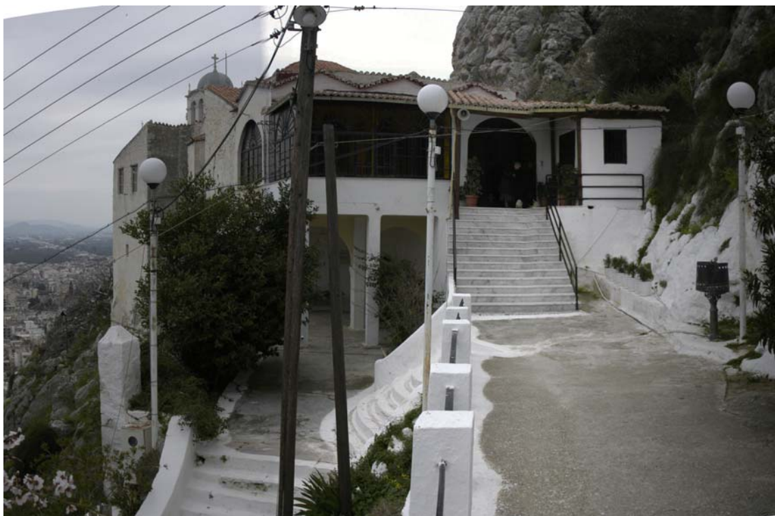
Εικ. 3. Άποψη της εισόδου της Μονής Κατακεκρυμμένης Άργους και του τελευταίου πεσσίσκου του αναλημματικού τοίχου πριν την κατάρρευσή του (5 Μαρτίου 2007).
