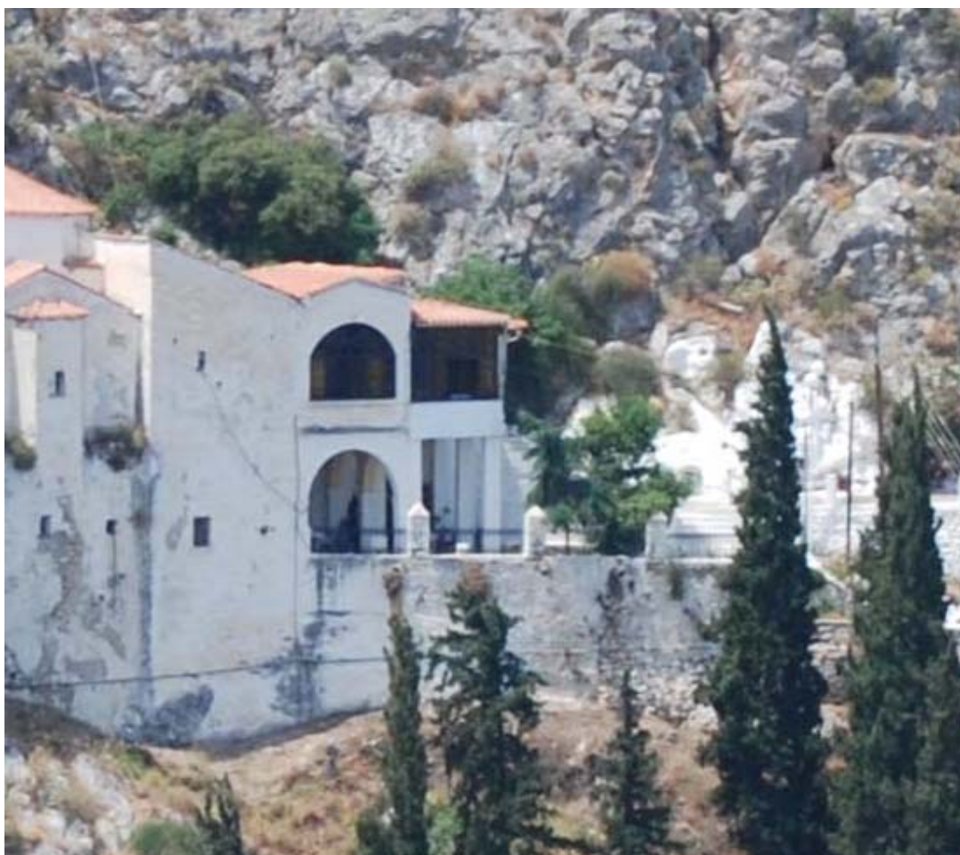
Εικ. 2. Άποψη του αναλημματικού τοίχου από ανατολικά πριν την κατάρρευσή του (Αρχείο Μονής).
