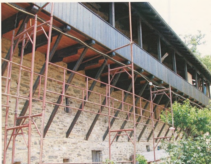
Η βόρεια πτέρυγα κατά την αποκατάσταση
