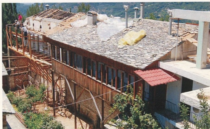
Αποψη της βόρειας πτέρυγας από τα ΝΑ κατά την αποκατάσταση
