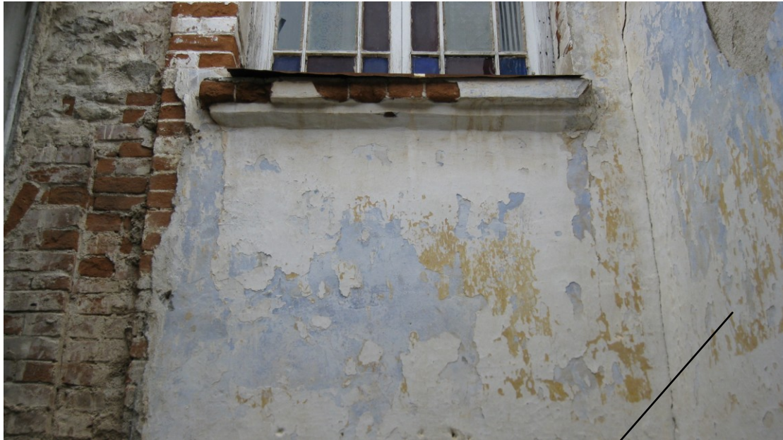
Εικόνα 1 Άποψη της πίσω όψης του κτιρίου.
