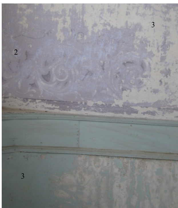
Εικόνα 18 Δείγμα από τον τοίχο του κλιμακοστασίου.
