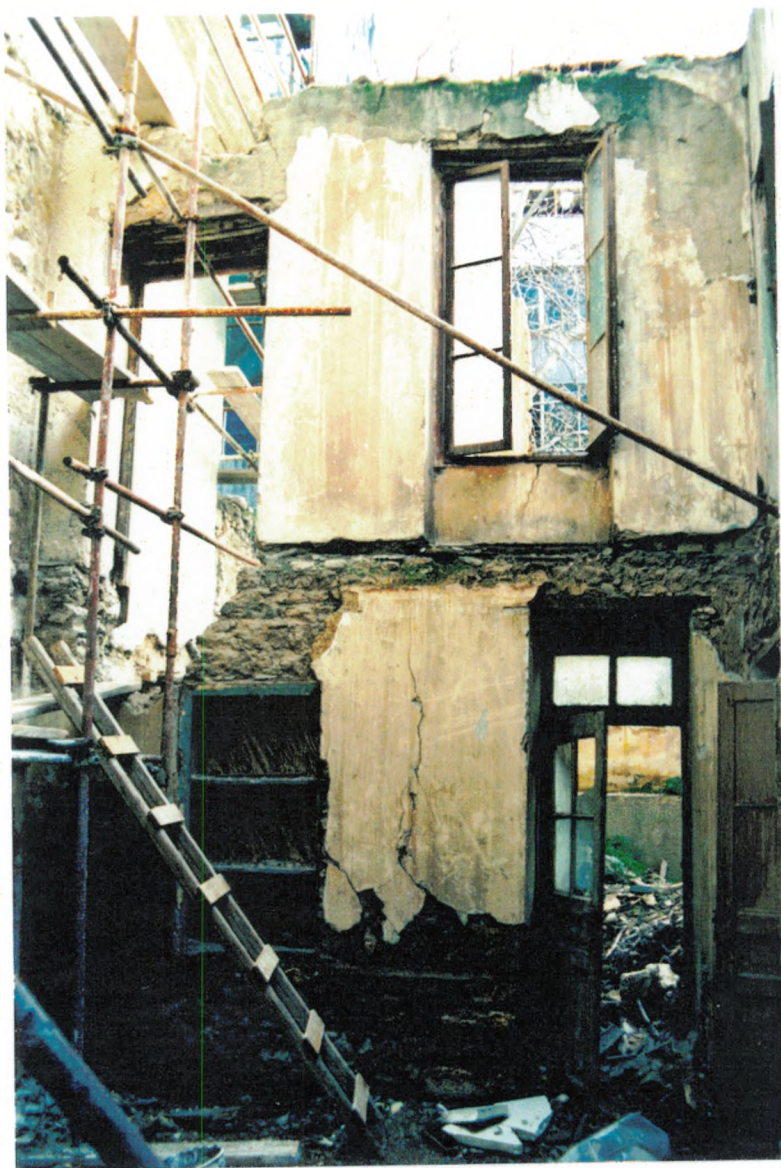
Εικ.11 «Ρηνάκι» Πλάκας. Αποψη του εσωτερικού του σπιτιού.
