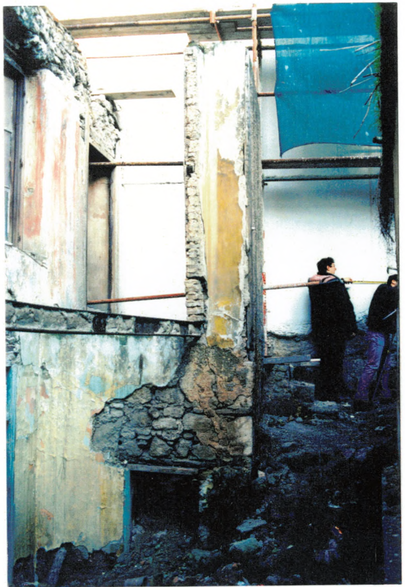
Εικ.9 «Ρηνάκι» Πλάκας. Μερική άποψη της νότιας πλευράς του σπιτιού.
