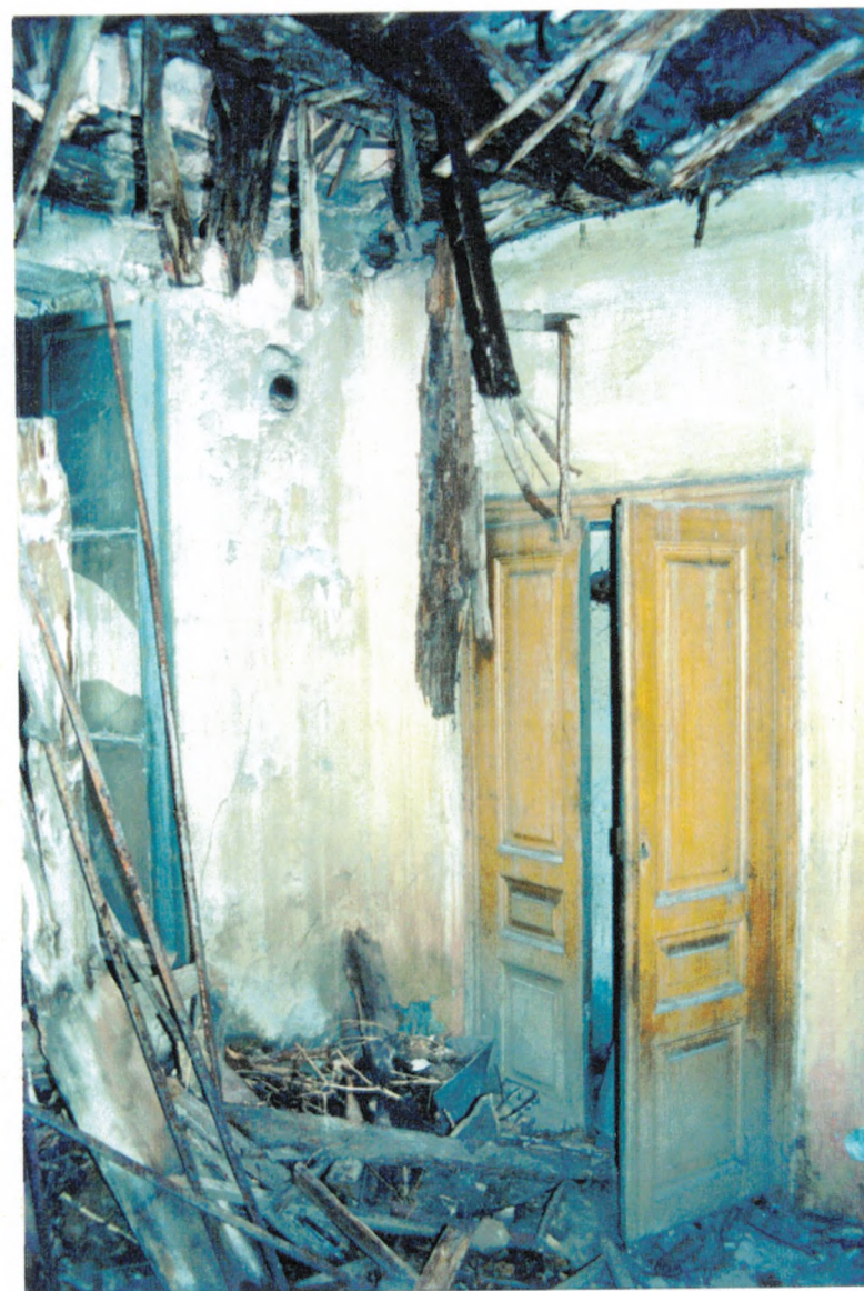
Εικ.12 «Ρηνάκι» Πλάκας. Αποψη του εσωτερικού του σπιτιού.
