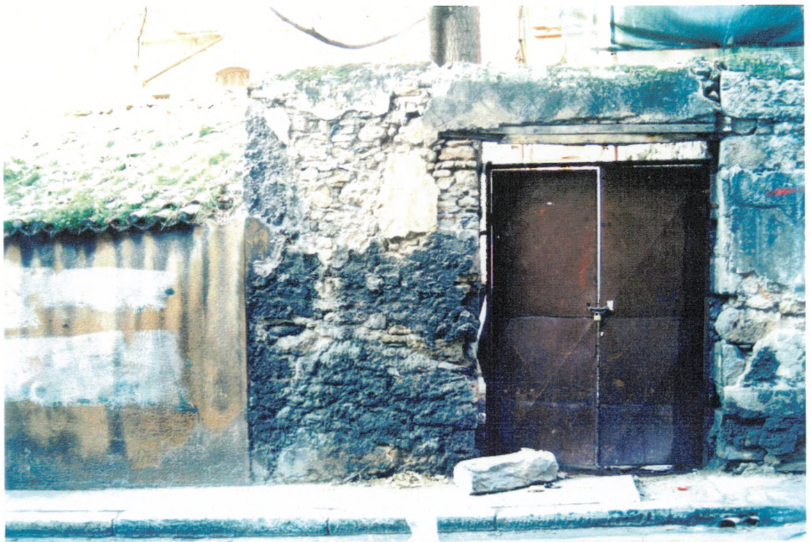
Εικ.7 «Ρηνάκι» Πλάκας. Το ανατολικό τμήμα του μανδρότοιχου προς το δρόμο.
