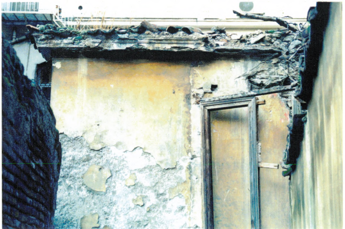
Εικ.10 «Ρηνάκι» Πλάκας. Μερική άποψη της νότιας πλευράς του σπιτιού.
