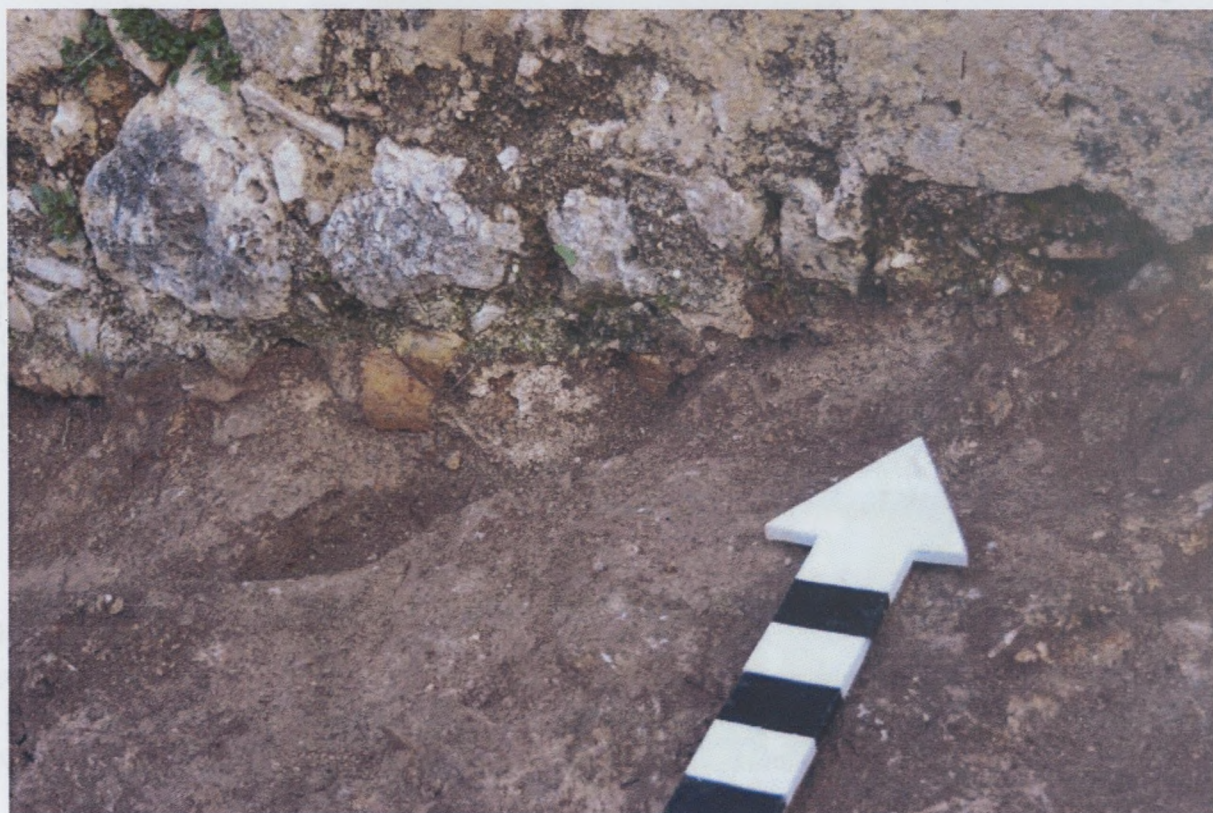
Εικ. 3.2 Λεπτομέρεια του εδάφους θεμελίωσης
