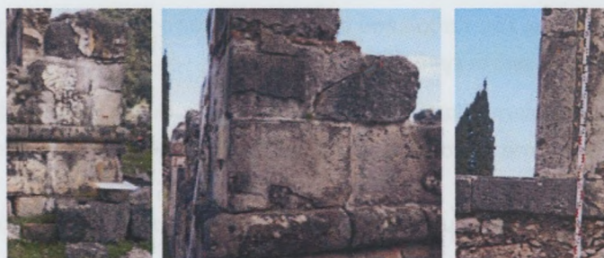
Εικ. 2.10,11 : Τοιχοποιία Καθολικού, λεπτομέρειες διαμόρφωσης γωνιών και θυρωμάτων
