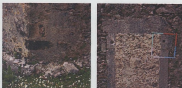
Εικ. 2.12.12 : Τοιχοποιία Παρεκκλησίου Αγίου Νικολάου, λεπτομέρειες διαμόρφωσης γωνιών και θυρωμάτων
