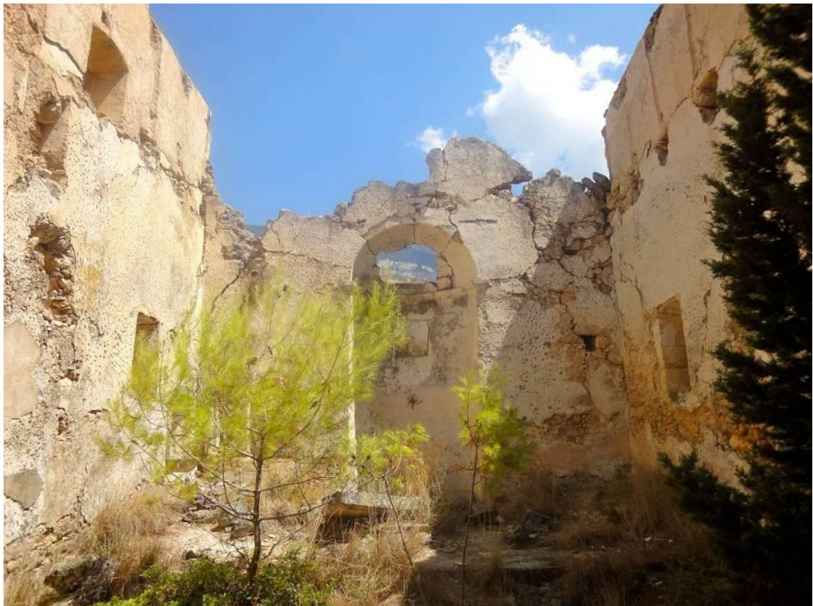
Εικ. 10. Η κόγχη του ιερού. Διακρίνονται ρηγματώσεις, καθώς και δένδρα στο εσωτερικό του ναού (2012).
