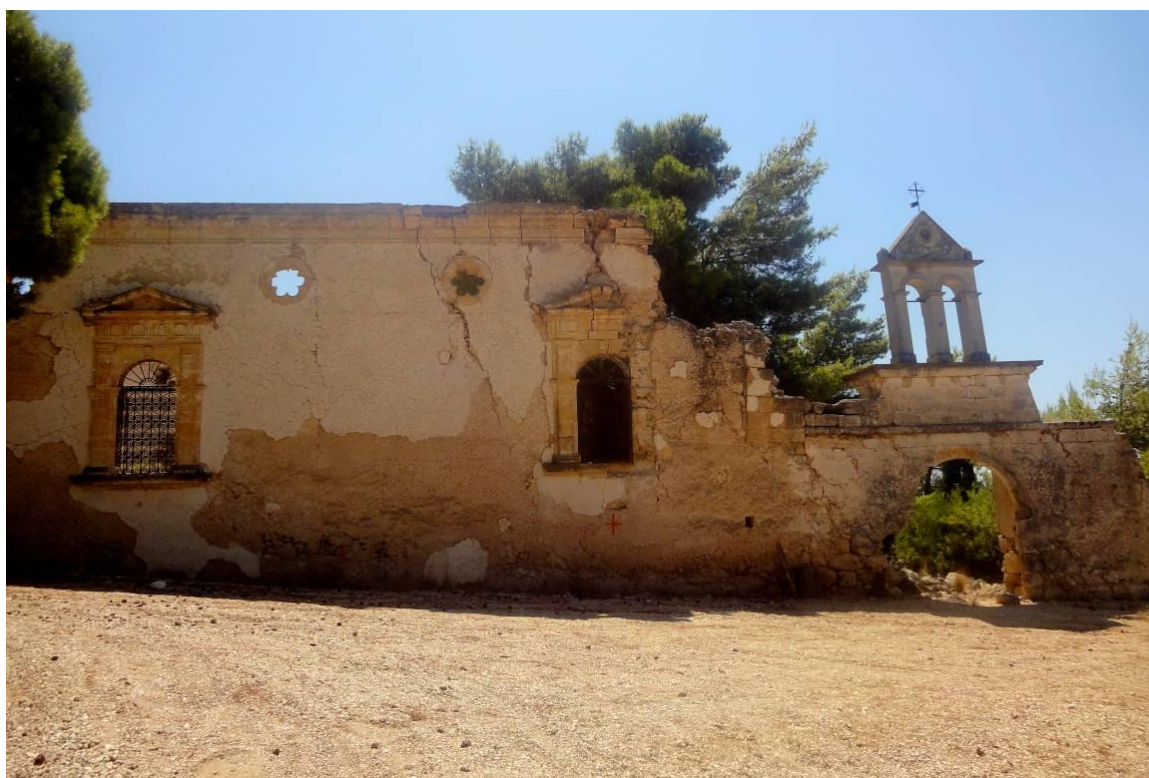
Εικ. 6. Η ΒΔ. όψη του ναού, στην οποία εφάπτεται ο πυλώνας-κωδωνοστάσιο της μονής (2012).
