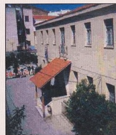
7ο Δημοτικό Σχολείο Βύρωνα, κτίσμα του 1936.
