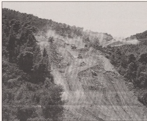
Εργασίες κατασκευής της Ρεωφόρου
