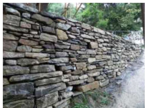
Ο ανατολικός αναλημματικός τοίχος ανακατασκευάστηκε και τοποθετήθηκε αναμονή για το σύστημα αποστράγγισης.
