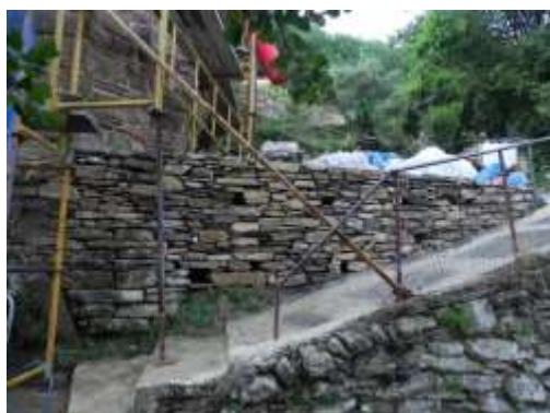
Ο ανατολικός αναλημματικός τοίχος ανακατασκευάστηκε και τοποθετήθηκε αναμονή για το σύστημα αποστράγγισης.
