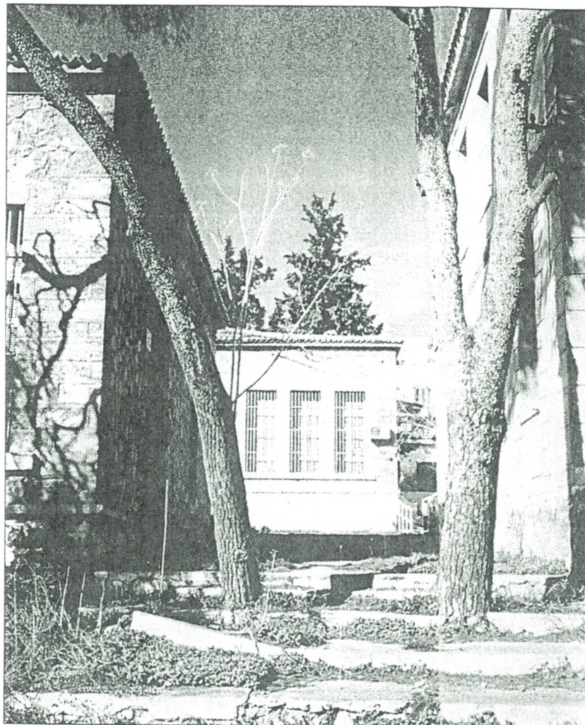
Τα παλαιά λιθόκτιστα κτίρια στις υπώρειες του Λυκαβηττού, τα οποία η Εκκλησία ως ιδιοκτήτρια του χώρου θέλει να αντικαταστήσει με ένα ξενοδοχείο. Τα εικονιζόμενα κτίρια θα καταδαφιστούν αν ο υπουργός Πολιτισμού υπογράψει την απόφαση.
