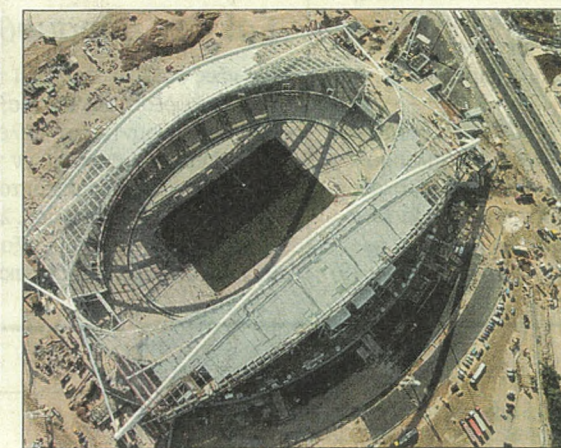
ΟΑΚΑ, κοιτάζοντας ψηλά. Το περίφημο στέγαστρο Καλατράβα που ολίσθησε, επιτέλους, στη θέση του και κάτω το εργοτάξιο (αεροφωτογραφία Ασοσ. Πρες).
