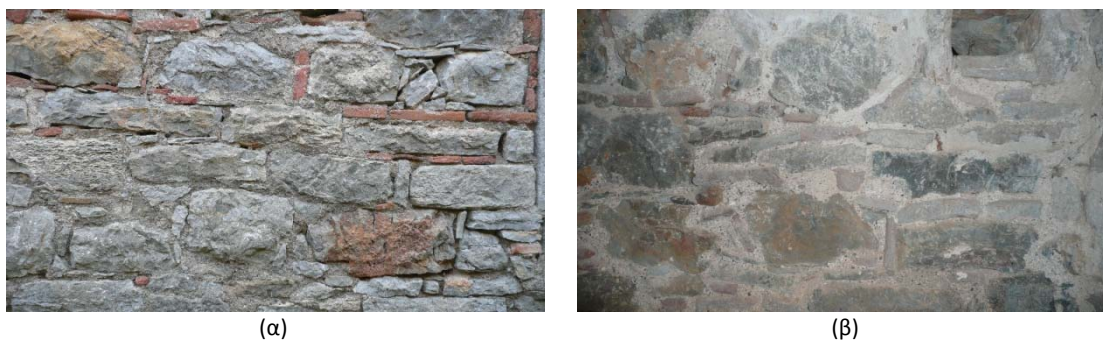
Εικ. 3.2: Δόμηση τοιχοποιίας: (α) εξωτερική και (β) εσωτερική παρειά.
