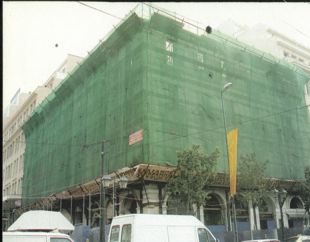
Το κτίριο Σταδίου και Κοραή όπως ανακατασκευάζεται
