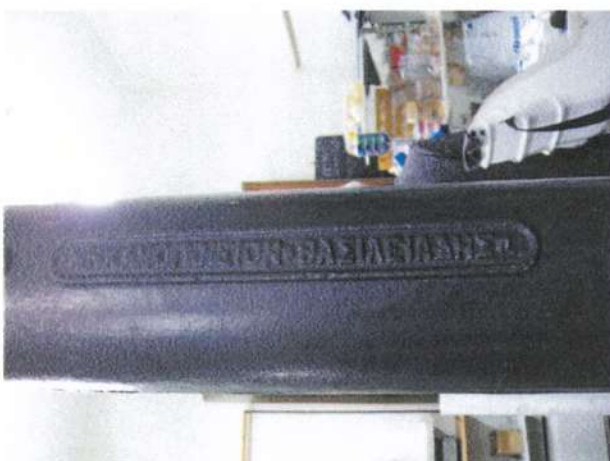
Η κεντρική κολόνα από χυτοσίδηρο, με τη σφραγίδα «ΜΗΧΑΝΟΥΡΓΕΙΟΝ ΒΑΣΙΛΕΙΑΔΗΣ»
