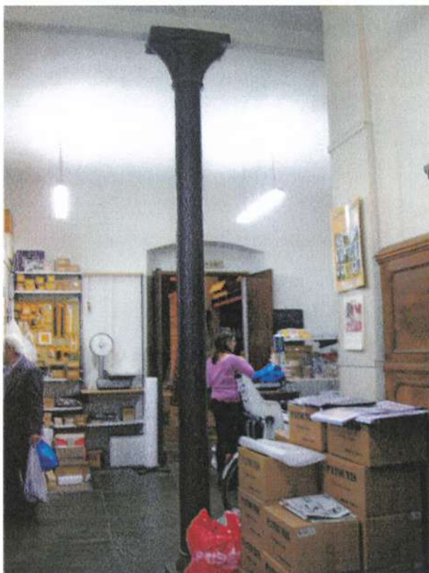
Η κεντρική κολόνα από χυτοσίδηρο, με τη σφραγίδα «ΜΗΧΑΝΟΥΡΓΕΙΟΝ ΒΑΣΙΛΕΙΑΔΗΣ»
