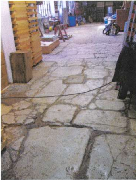
Η πλακόστρωση στον χώρο παρασκευής του σαπουνιού, με μία μαρμάρινη πλάκα υποδοχής ξύλινου υποστρώματος, από το παλιότερο χαγιάτι
