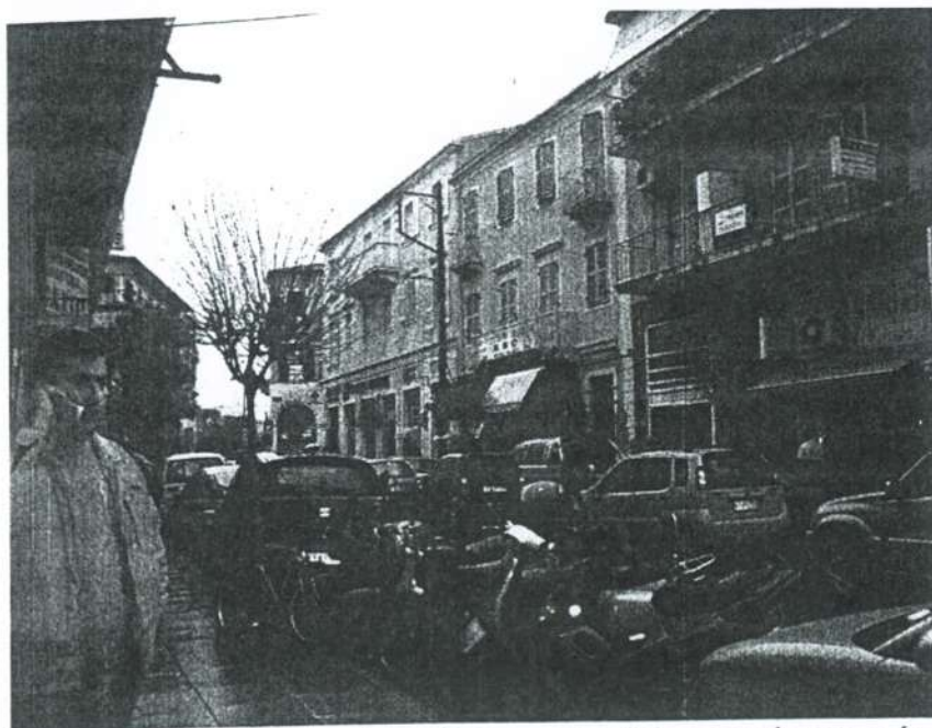
Τα γειτονικά τριόροφα κτίρια, δίπλα στην ενδιάμεση πολυκατοικία
