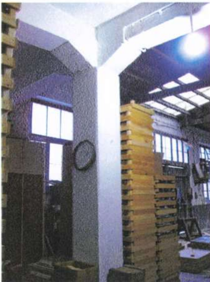
Οι επεμβάσεις από μπετόν, στο ίδιο σημείο του υπόστρου χώρου, προς εκείνον της παρασκευής του προϊόντος.
