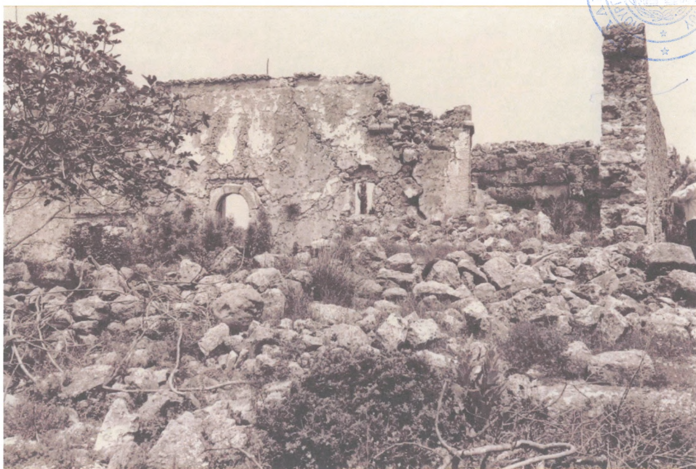
Εικ. 58 Άποψη της νότιας πλευράς του καθολικού, μετά τους σεισμούς του 1953 (Αρχείο του Κοργιαλενείου Ιδρύματος).
