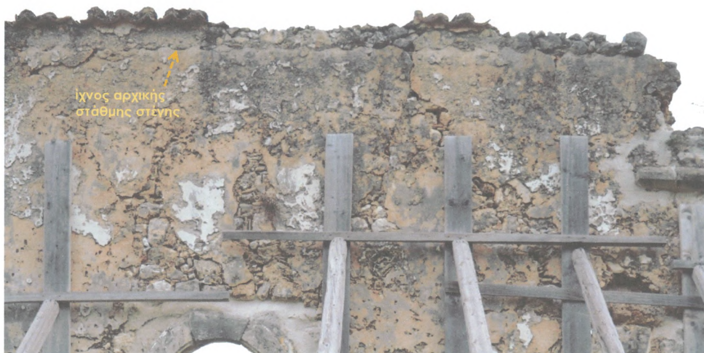
Εικ. 41 Απόληξη του νότιου τοίχου. Διακρίνονται τα σωζόμενα κεραμίδια αλλά και το ίχνος των κεραμιδιών της αρχικής στέγης.
