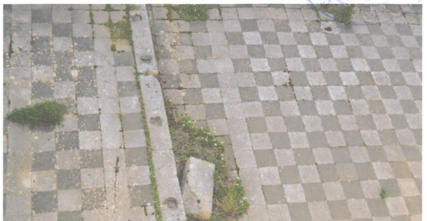
Εικ. 50 Λεπτομέρεια του δαπέδου και της βαθμίδας του ιερού. Διακρίνονται οι εγκοπές στήριξης του τέμπλου.
