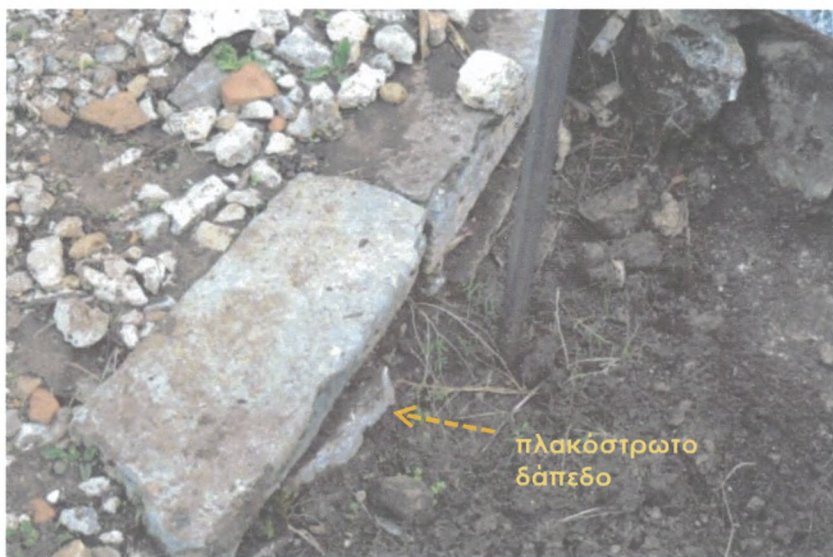
Εικ. 54 Πλακόστρωτο δάπεδο κάτω από τη μεταγενέστερη βαθμίδα.
