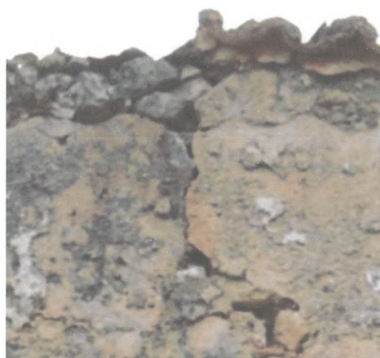
Εικ. 40 Απόληξη νότιου τοίχου. Λεπτομέρεια.
