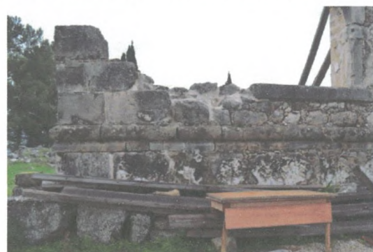
Εικ. 73 Το δυτικό τμήμα του νότιου τοίχου.
