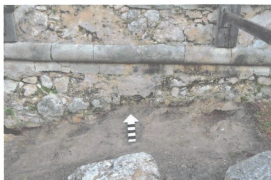
Εικ. 71 Η θεμελίωση του νότιου τοίχου στον βράχο.
