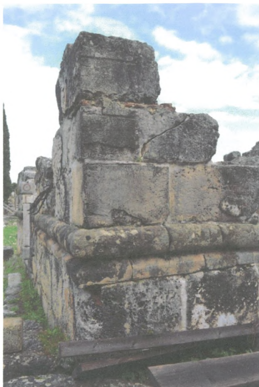
Εικ. 29 Απομίμηση γωνιόλιθων στο αρχικό επίχρισμα της νοτιοδυτικής γωνίας του ναού.
