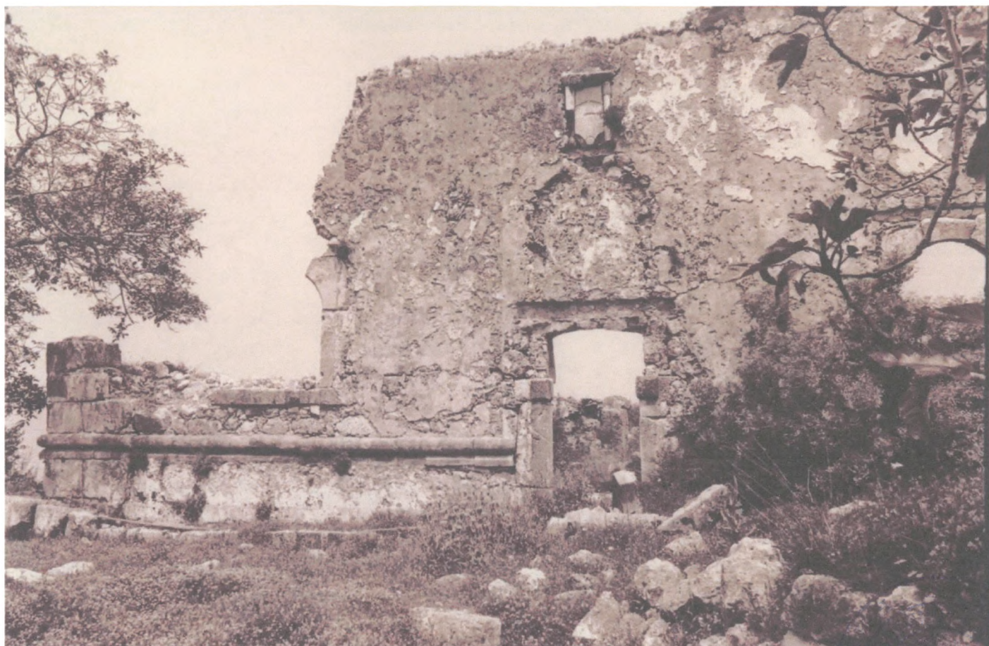
Εικ. 57 Άποψη της νότιας πλευράς του καθολικού, μετά τους σεισμούς του 1953 (Αρχείο του Κοργιαλενείου Ιδρύματος).
