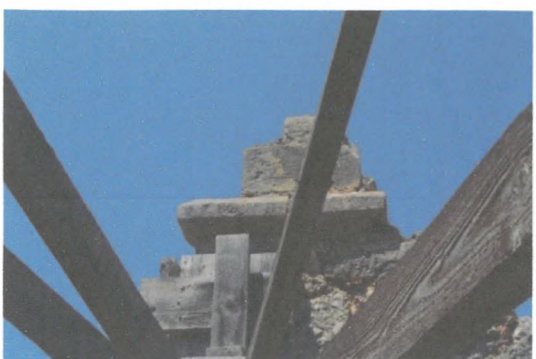
Εικ. 26 Κοσμήτης τρίπλευρης διατομής στην νοτιοανατολική γωνία.
