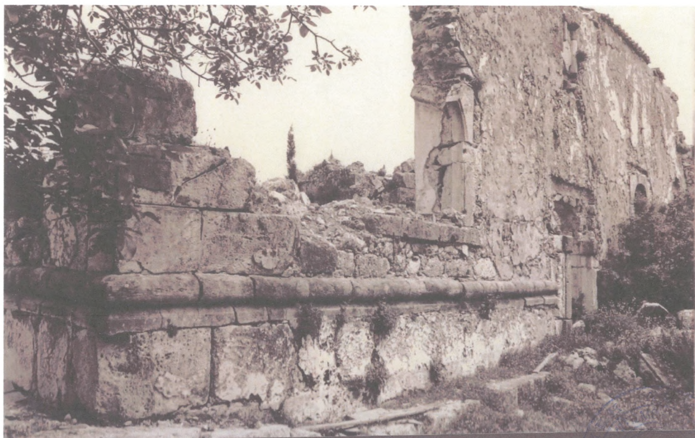
Εικ. 59 Άποψη από τα νοτιοδυτικά της νότιας πλευράς του καθολικού, μετά τους σεισμούς του 1953 (Αρχείο του Κοργιαλενείου Ιδρύματος).
