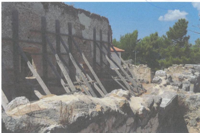
Εικ. 63 Η αντιστήριξη του νότιου τοίχου στο εσωτερικό του ναού.
