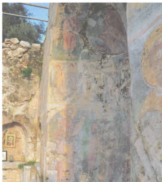
Εικ. 79 Άποψη της κόγχης του ιερού από τα νοτιοανατολικά.
