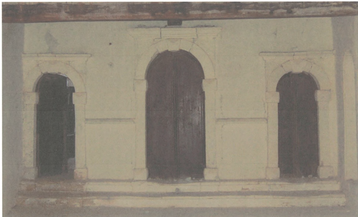
Εικ. 84 Θύρες στον δυτικό τοίχο του καθολικού της μονής Στροφάδων.
