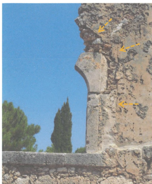
Εικ. 30 Νότιο παράθυρο (ΠΝ1). Διακρίνονται τμήματα του εγχάρακτου πλαισίου.
