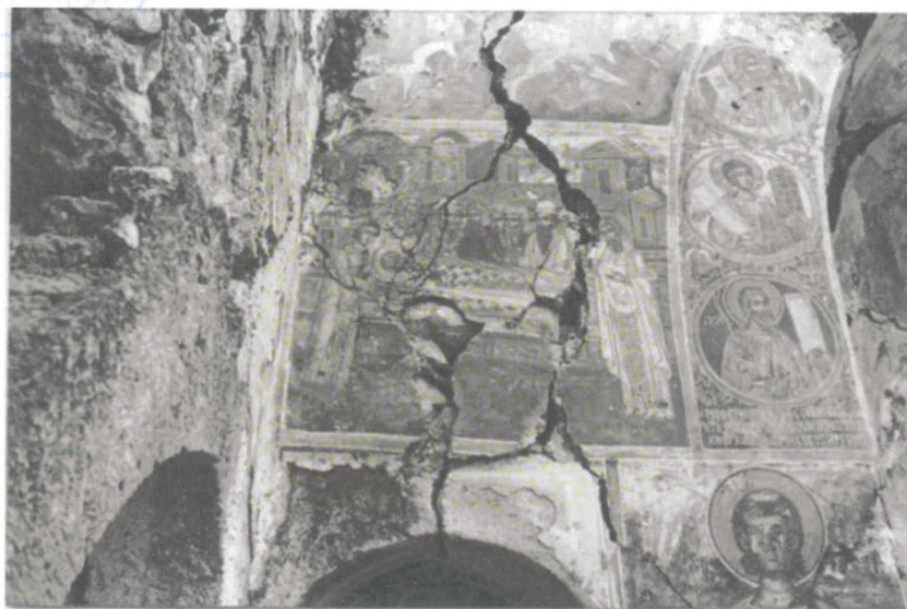
Εικ. 68 Ρωγμή πάνω από την κόγχη της πρόθεσης (1970-1980). Από το αρχείο του Κοργιαλενείου Ιδρύματος.
