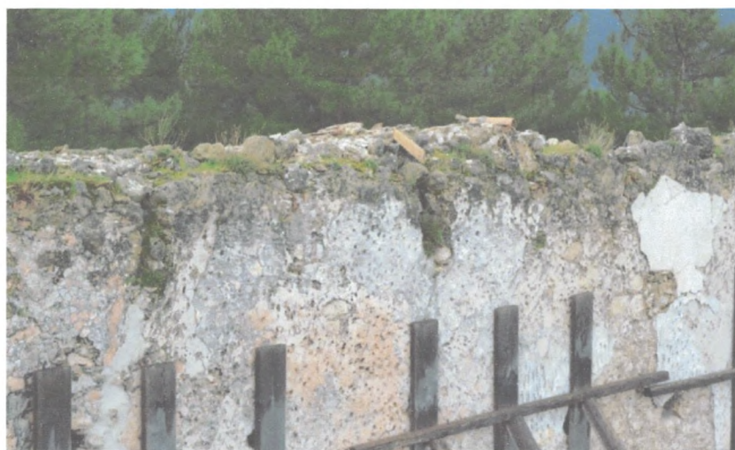
Εικ. 39 Εσωτερική παρειά του νότιο τοίχου. Διακρίνονται οι δοκοθήκες της ξύλινης στέγης.
