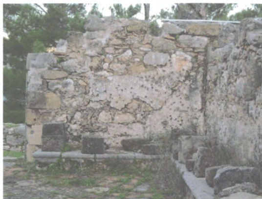
Εικ. 32 Βόρειο τμήμα της δυτικής πλευράς. Διακρίνονται τα διαδοχικά στρώματα των εσωτερικών επιχρισμάτων.
