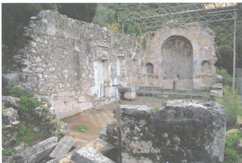
Εικ. 69 Άποψη του ναού από τα νοτιοδυτικά.
