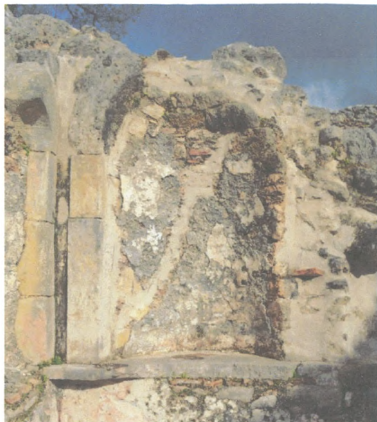
Εικ. 75 Η κόγχη της πρόθεσης. Διακρίνεται επίσης το λίθινο πλαίσιο της κόγχης στον βόρειο τοίχο του ιερού.
